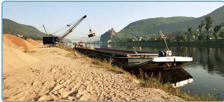
Takto vypadal přístav ve Vaňově před zahájením rekonstrukce
