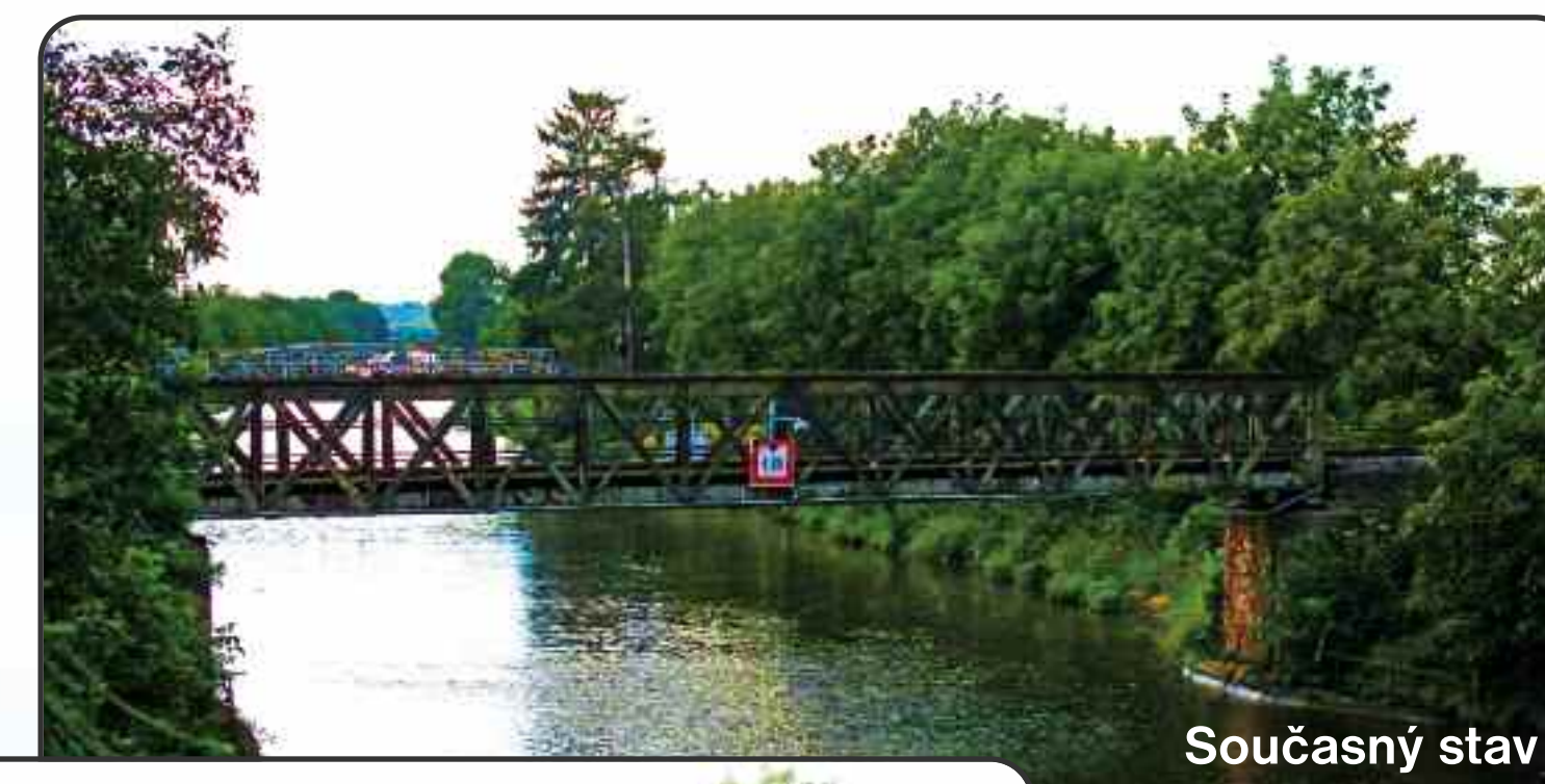
Železniční most v ev. km 2,622 – Lužec nad Vltavou
