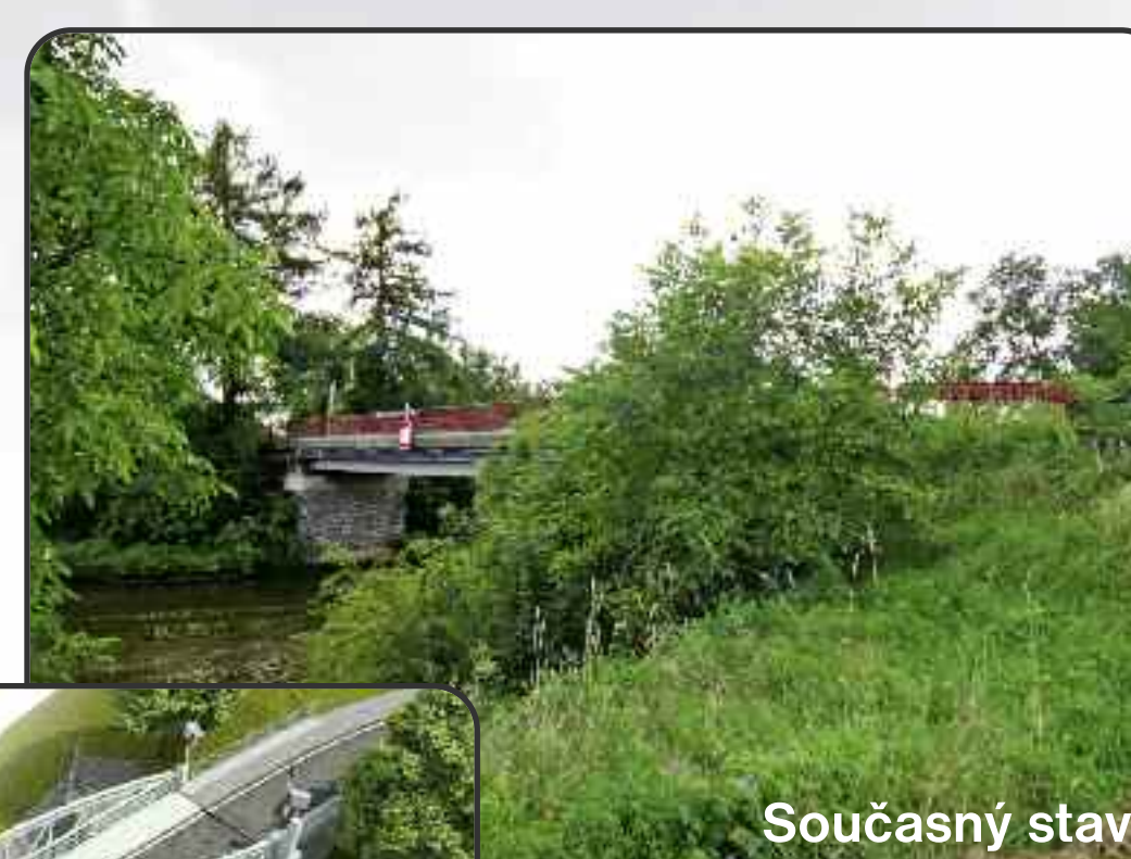
Silniční most na místní komunikaci – Lužec nad Vltavou
