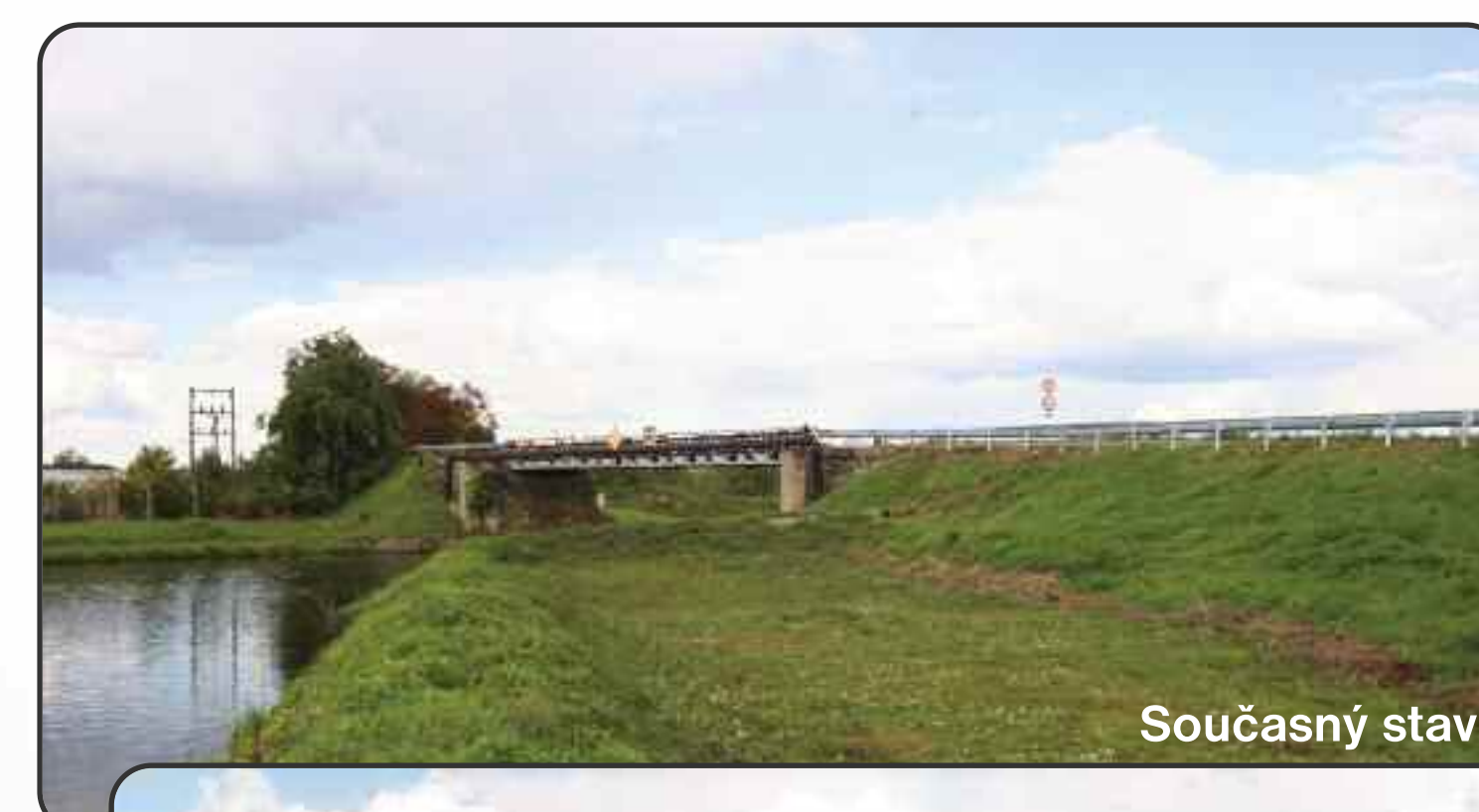
Silniční most na silnici III/24635 – Vrbno
