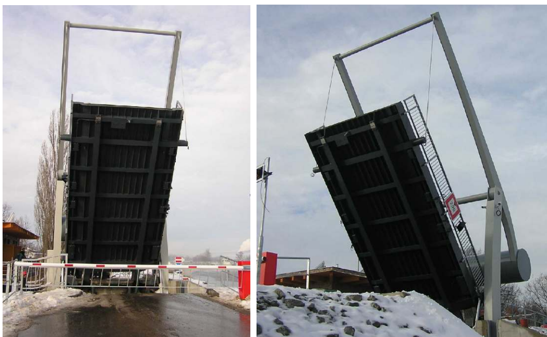
Obr.4) Pohledy na sklopený most
