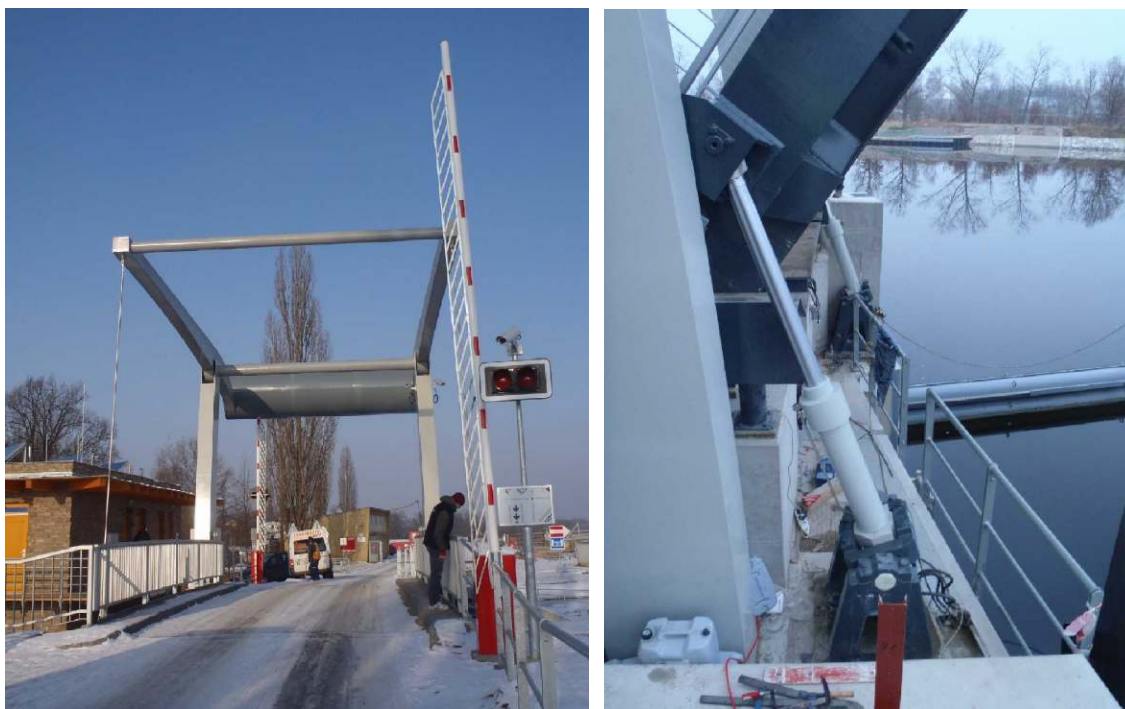
Obr.3) Pohled na závory a zabezpečení mostu a na hydraulické válce
