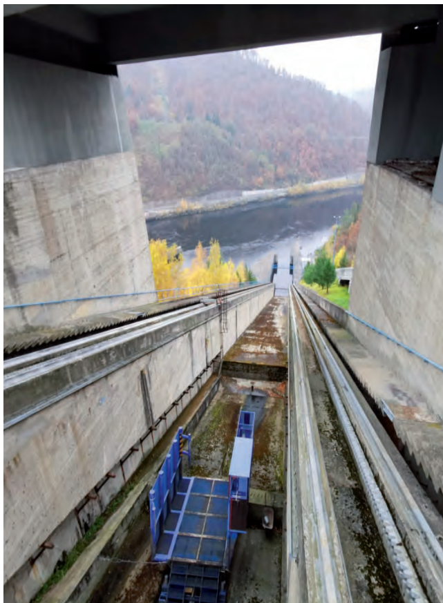
Pohled na kolejovou dráhu lodního zdvihadla Orlík
