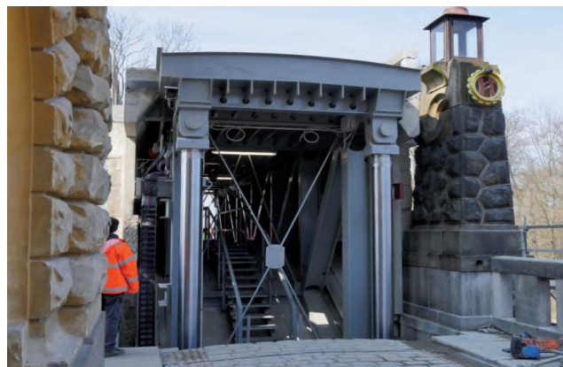
Detail mostovky, ocelového jádra mostu a hydraulických válců
