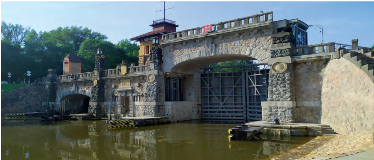
Výsledek unikátní modernizace: Historické zdymadlo s novou mostovkou ve zdvižené poloze
