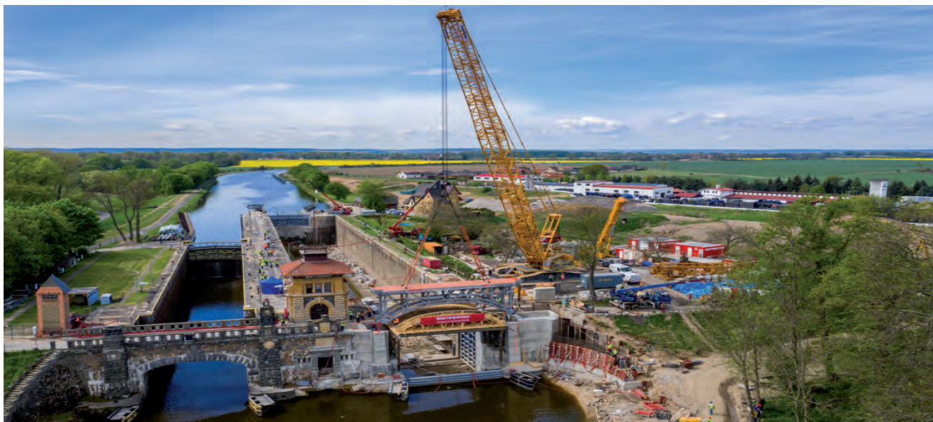
Montáž mostovky přes velkou plavební komoru
