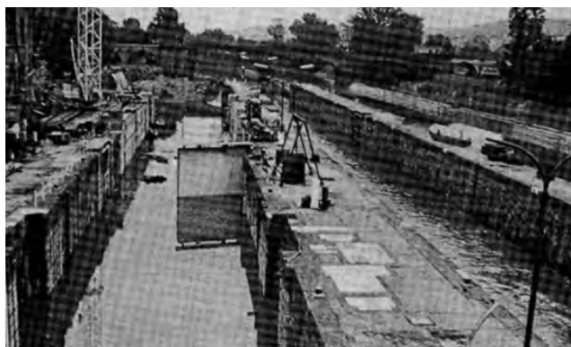
Modernizace plavebních komor a stavba umělé slalomové dráhy Štvanice
