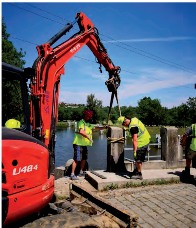
Demontáž kamenných prvků
