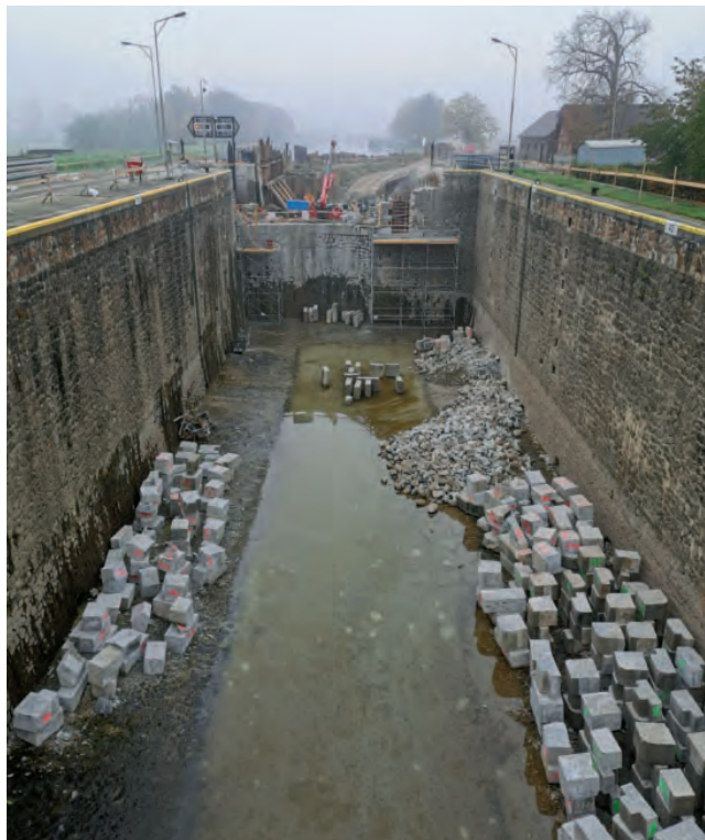
Kameny pečlivě očišované a připravené na dně plavební komory
