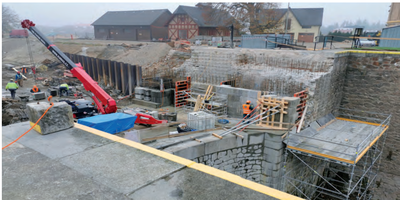
Kamenické práce na horním ohlavi plavební komory rozšířeném na 12 m
