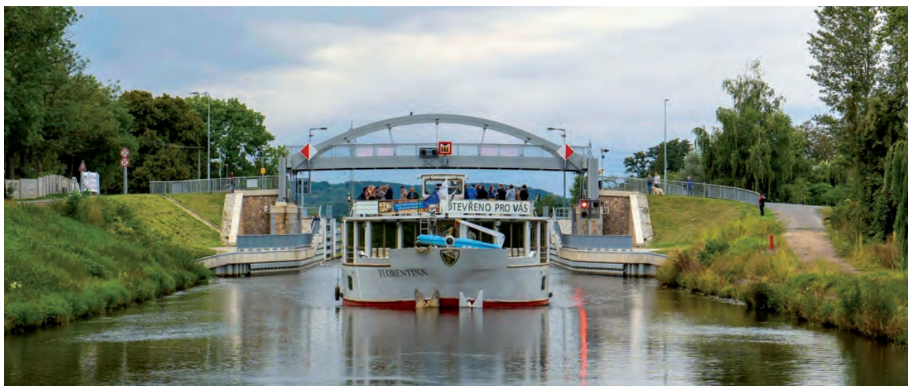
Zdvižný silniční most ve Vraňanech
