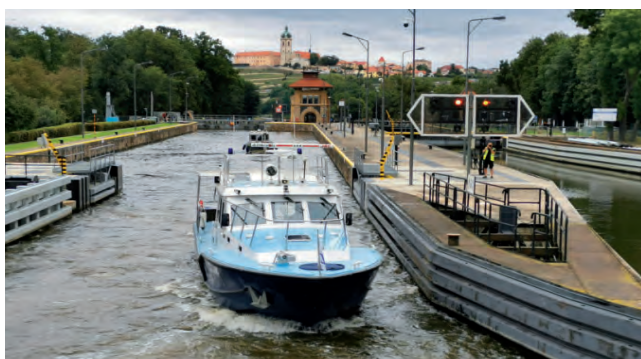
Během rekonstrukce došlo i na rozšíření horního ohlavi VPK Hořín
