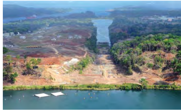
Místo zemních prací na atlantské straně průplavu z 2. světové války bylo nyní využito pro výstavbu třetí řady plavebních komor
