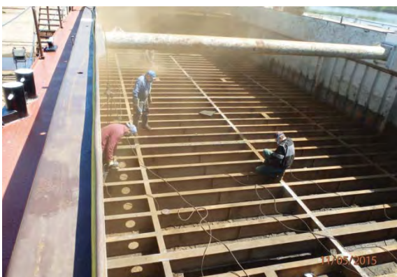
Výměna obšívky Silja 2 v loděnici Chvaletice
