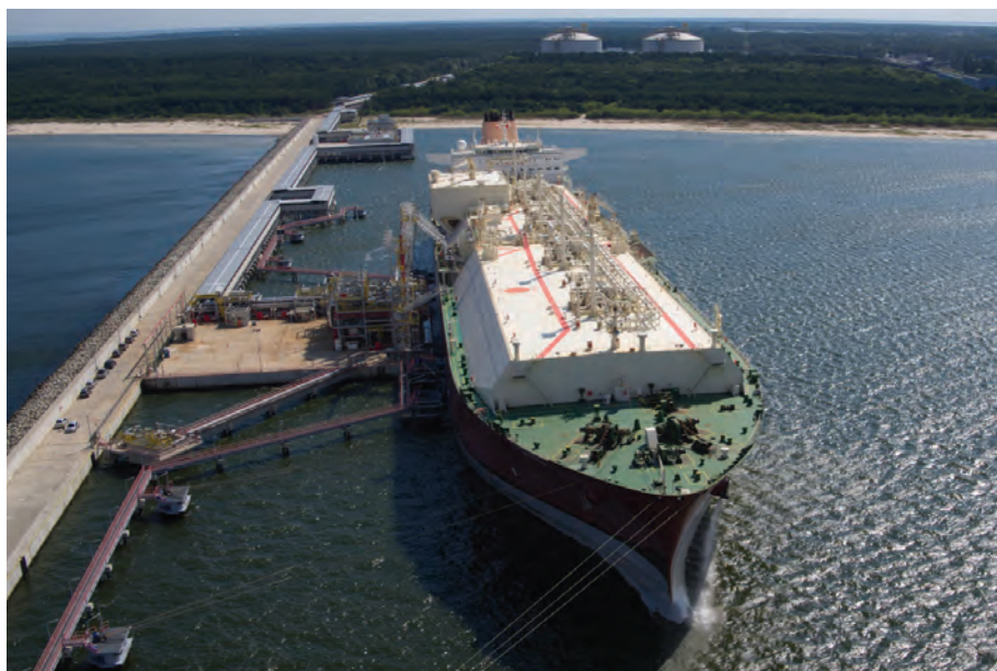
Lodní stanoviště pro vykládku LNG z tankerů
