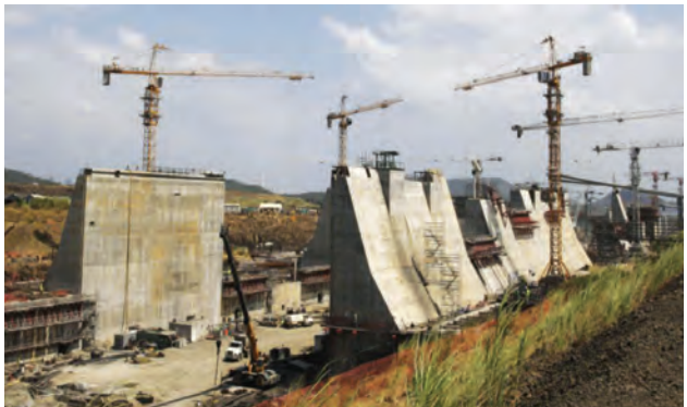
Výstavba nových plavebních komor
