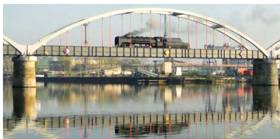
Zatěžkávací zkouška nové mostní konstrukce parní lokomotivou a železničním jeřábem
