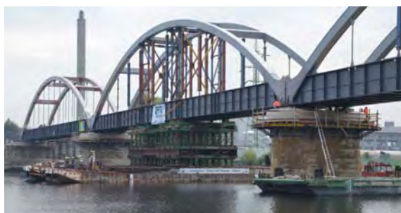
Usazování nové mostní konstrukce pomocí speciálního soulodí
