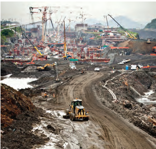
Práce na výstavbě nových plavebních komor Panamského průplavu
