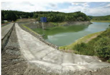
Probíhající rekonstrukce vodního díla, Opatovice
