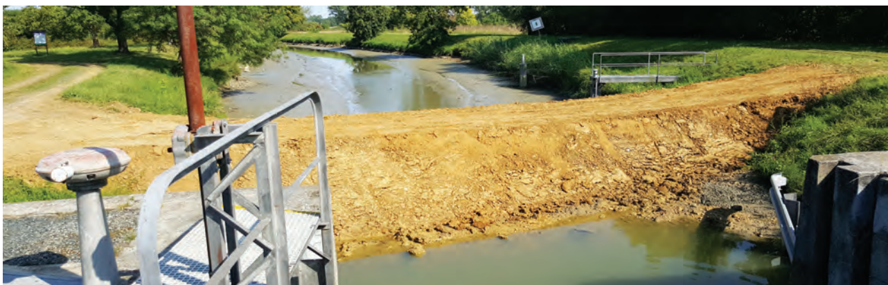
Zahrazení opravovaného úseku Baťova kanálu
