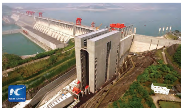
Dokončené lodní zdvihadlo v na přehradě Tři Soutěsky
