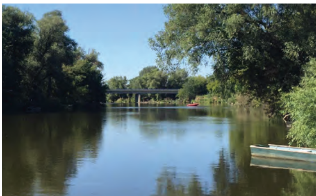
Místo předpokládaného umístění zbytků plavební komory u Rohatce
