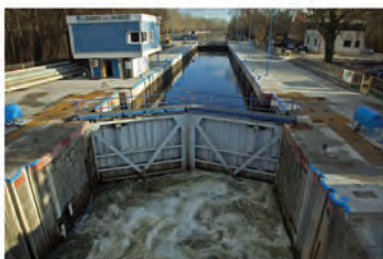
Modernizace plavební komory, Brandýs nad Labem
