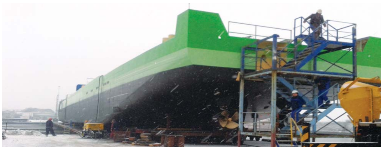
Dozor stavby LNG tankeru GREENSTREAM
