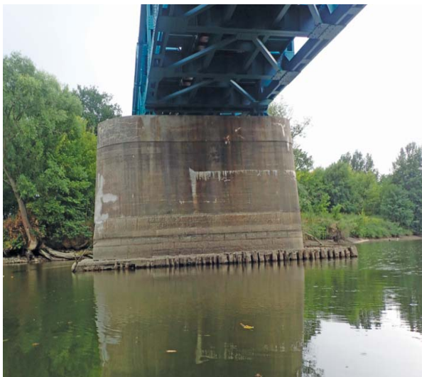
Železniční most v Rohatci - srpen 2018
