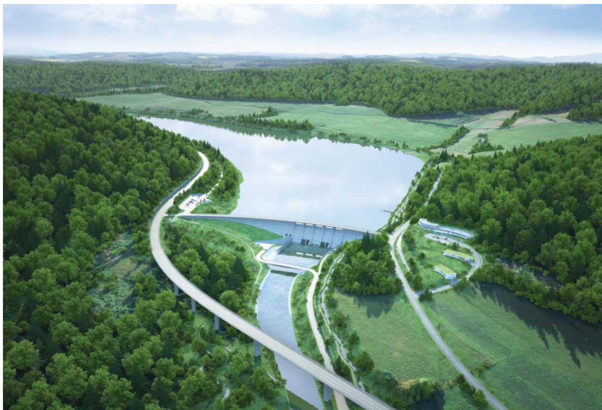
Připravovaná nádrž Nové Heřminovy na řece Opavě je navržena tak, aby řešila oba hydrologické extrémny. Za povodní bude snižovat kulminaci na přibližně 1/2 a za sucha bude významně nadlepšovat průtoky v řece pod hrází. Zdroj: Povodí Odry, s.p.
