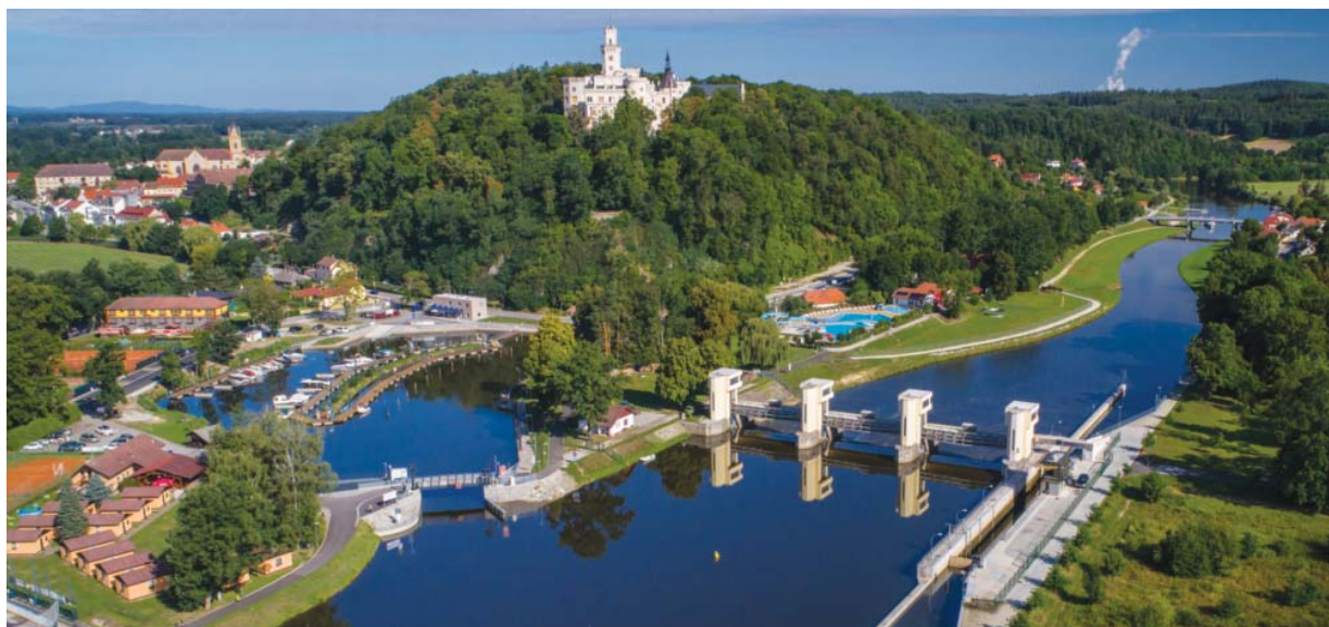
Přístav a plavební komora Hluboká nad Vltavou
