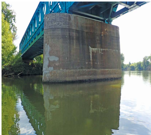
Železniční most v Rohatci - září 2018
