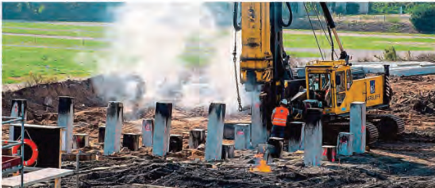
Začíná se budovat Ředitelství vodních cest (RVC) začalo stavět nový silniční most přes Labe mezi Valy a Mělicemi na Pardubicku. Foto: Tichák Kalfous, MAFTA
