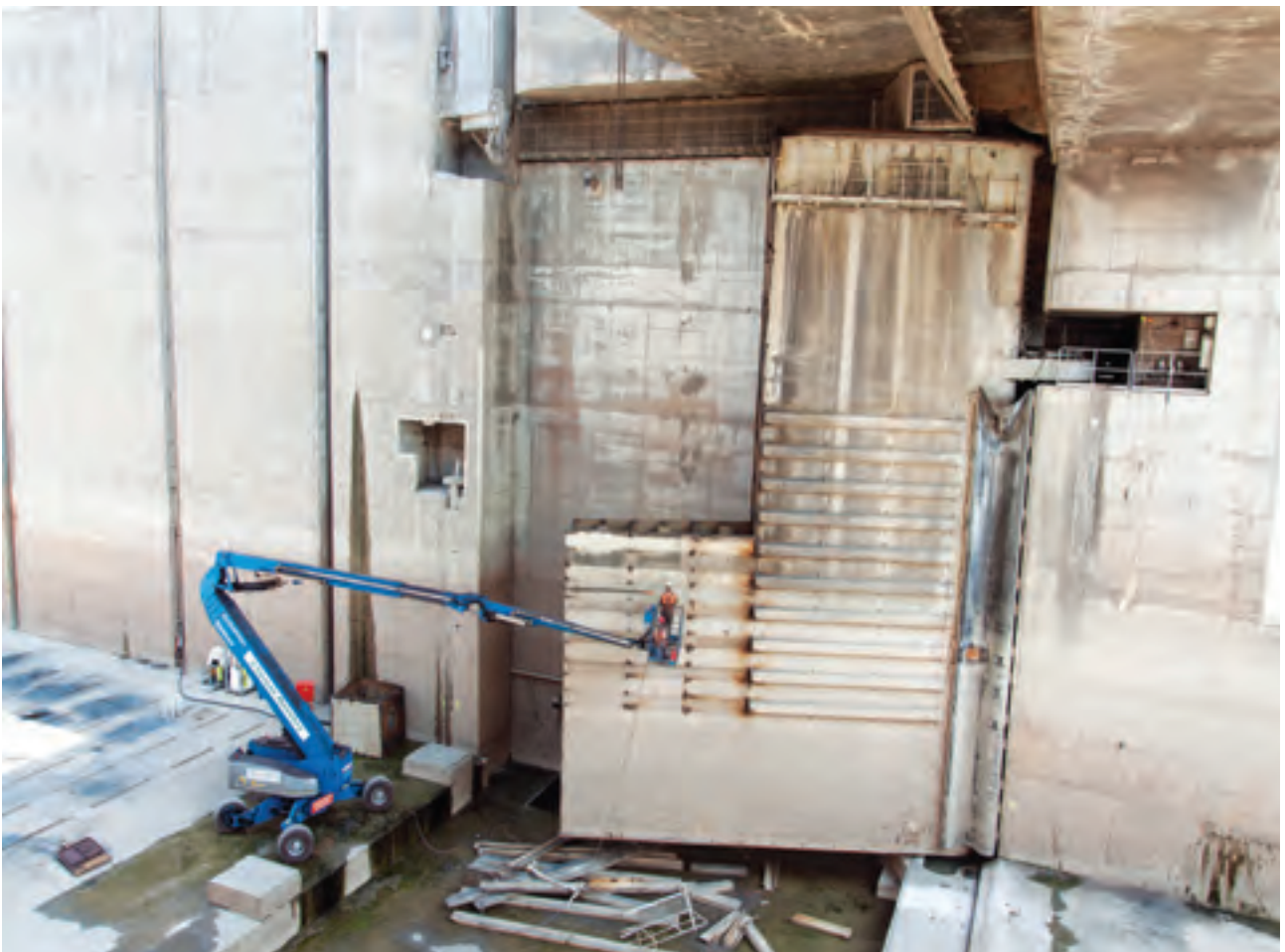
Demontáž dolných vrát pravej plavebnej komory
