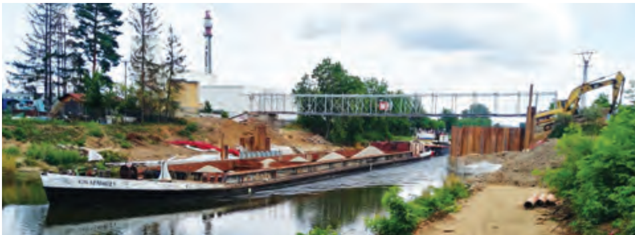
První lodě opět proplouvají po plavebním kanále Vraňany-Hořín přes staveniště nových mostů
