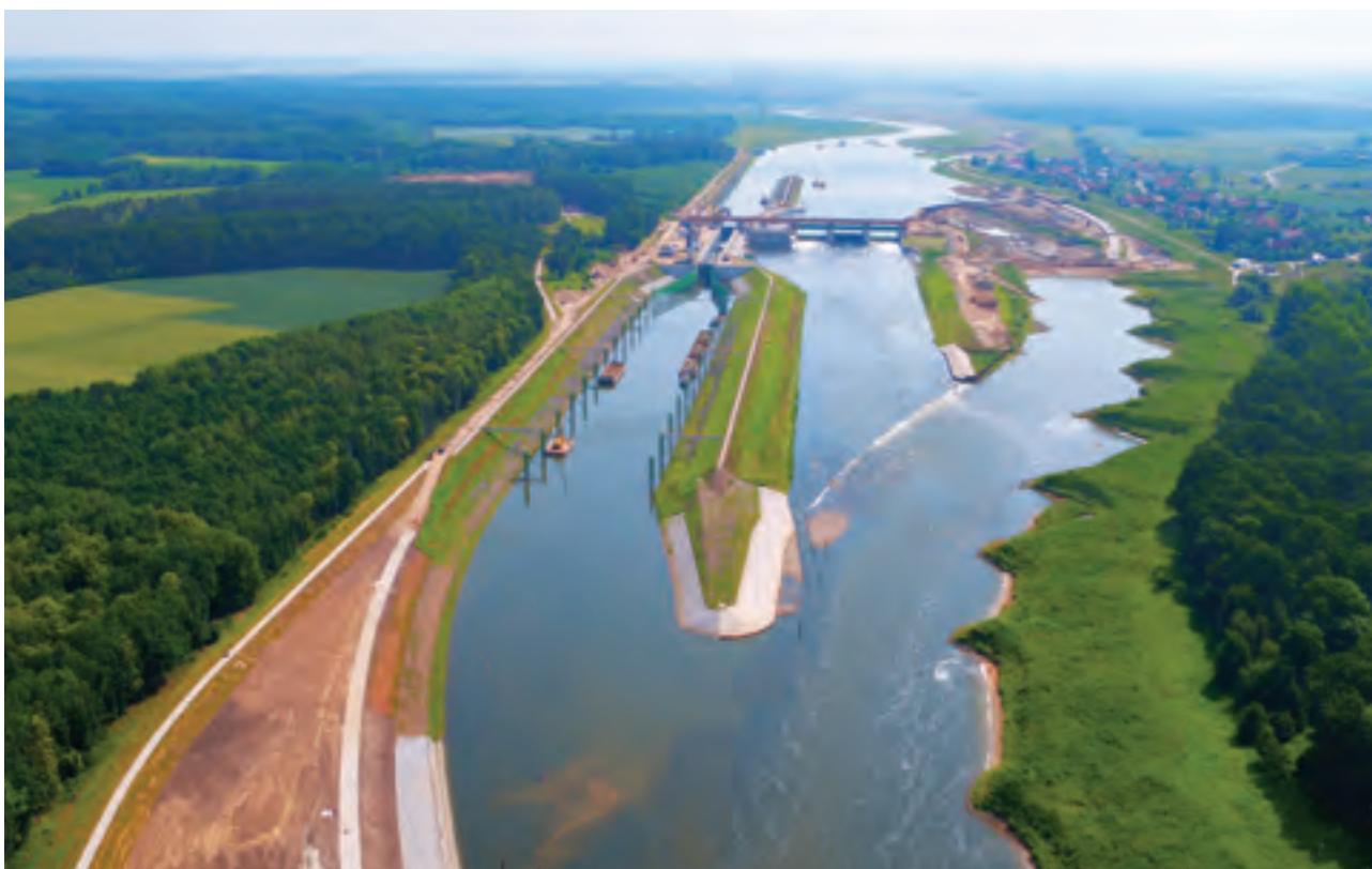
V roce 2018 byl dokončen nový oderský plavební stupeň Malczyce, ihned poté začaly práce na přípravě dalších stupňů
