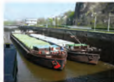
VD Střekov - proplavovací plavební komora
