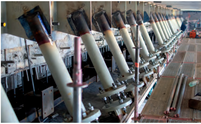
Část ocelové konstrukce horního opěrného prahu
