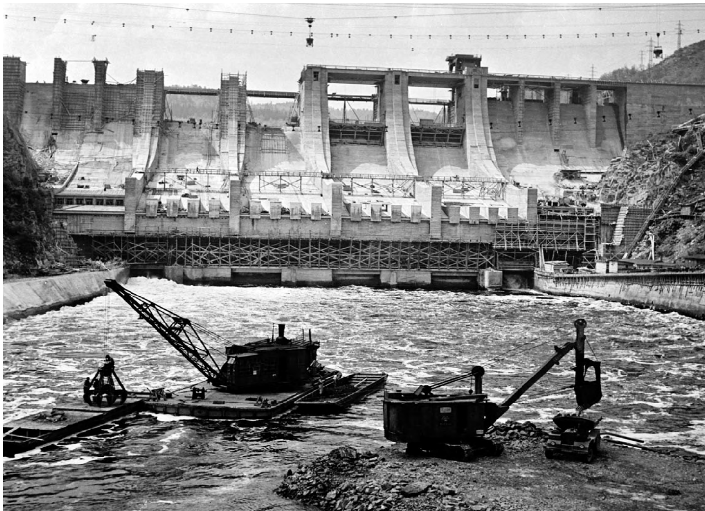
Výstavba slapské přehradě v roce 1955
