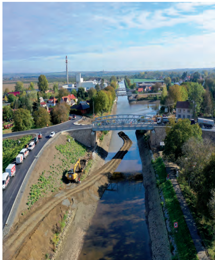
Dokončovací práce na mostech přes Vraňansko-hořínský kanál si vyžádaly jeho vypuštění
