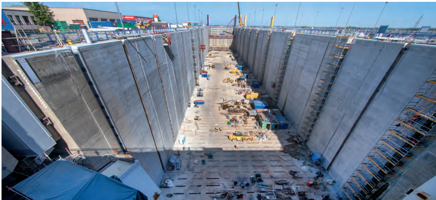
Celkový pohled na probíhající práce v komoře
