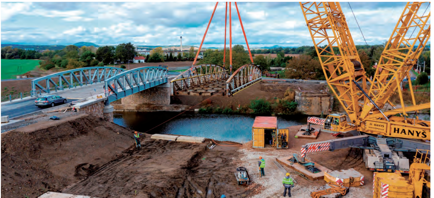
Demontáž původní mostní konstrukce silničního mostu v Lužci nad Vltavou
