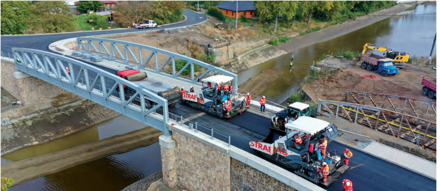
Pokládání asfaltu na novém silničním mostě v Lužci nad Vltavou
