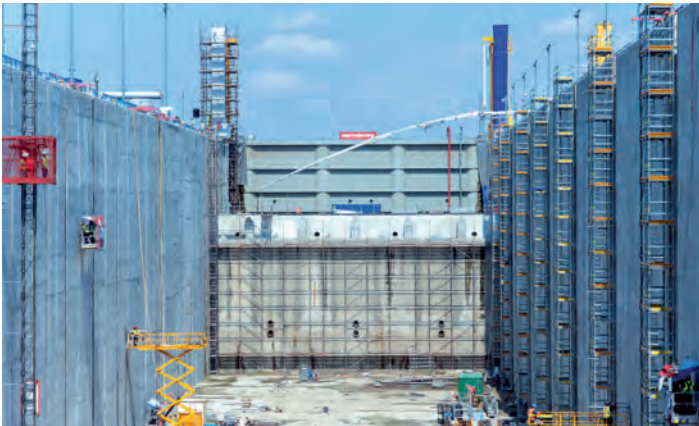
Sanace dilatačních spár, montáž mechanického překrytí, vybourání a příprava drážek spáry pro osazení těsnícího systému
