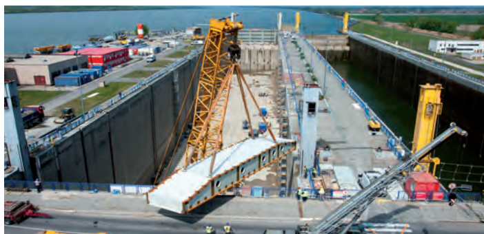
Skládání dílce AL3 do plavební komory pro následnou montáž
