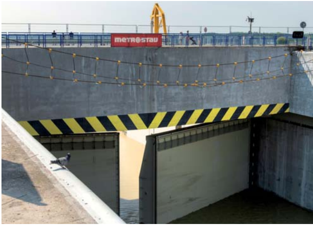
Dolní ohlavi - nová dolní vrata a modifikovaná konstrukce dynamických ochranných
