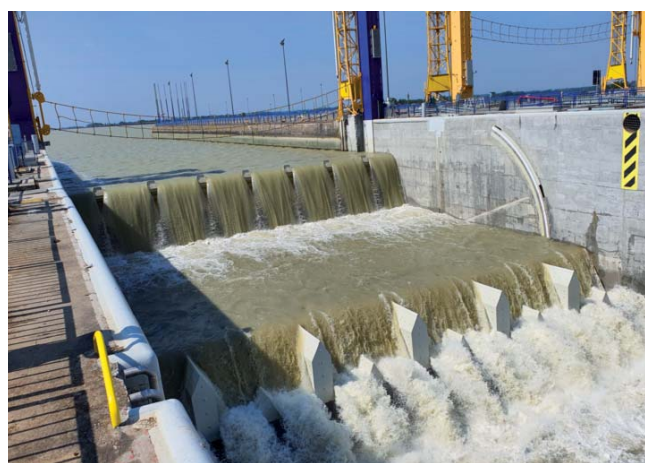
Zatěžkávací zkouška záskokové klapky v jezovém provozu
