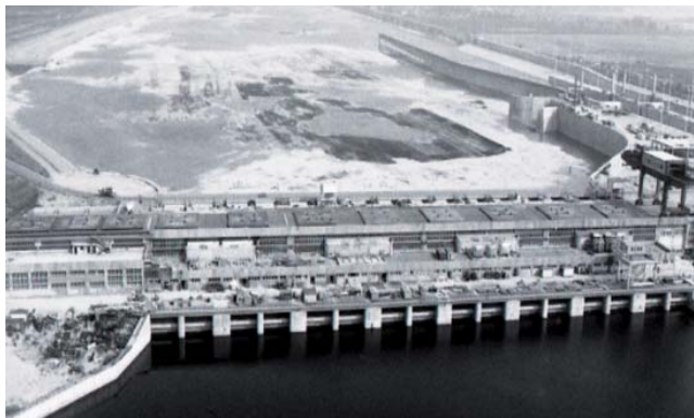
Stavba VD Gabčíkovo
