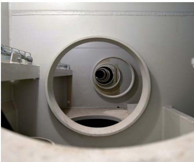
Dolní vrata - vnitřní svislé stěny vrat s otvory
