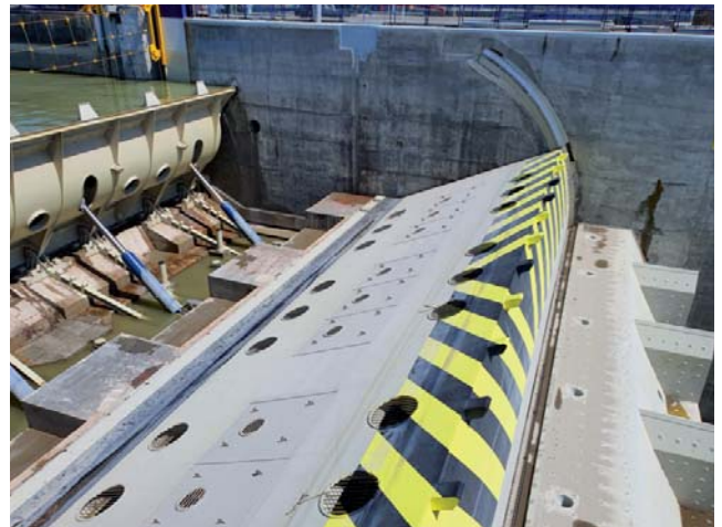
Plavební komora v režimu záskokové klapky jako náhrady horních vrat
