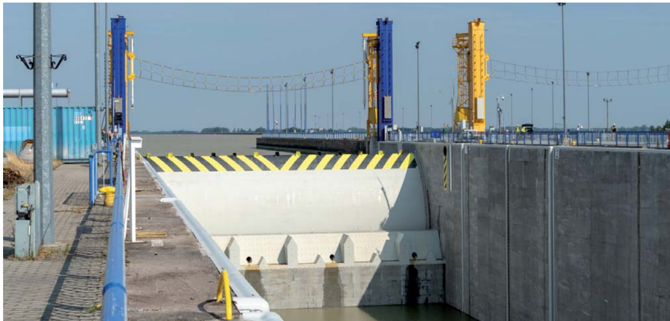
Pohled na horní ohlaví - po komplexní výměně horních vrat, opacňování rozržečů a modifikace dynamických ochran
