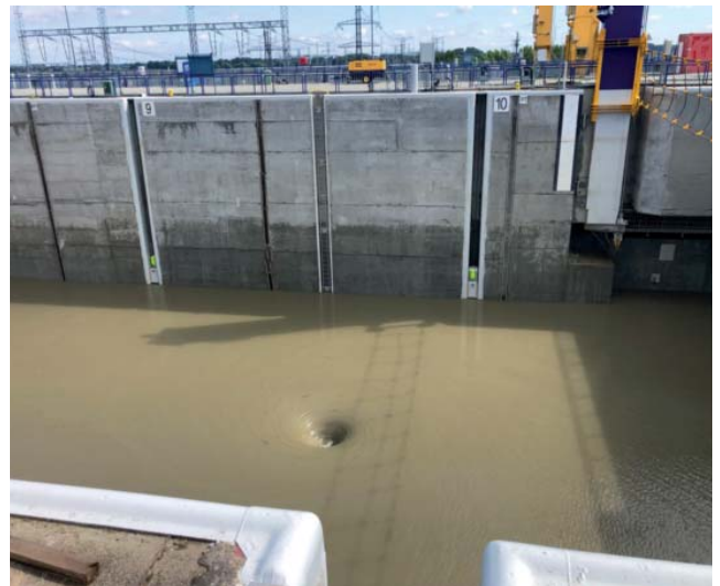
Vznik víru v plavební komoře při režimu náhrady průtoku za vodní elektrárnu
