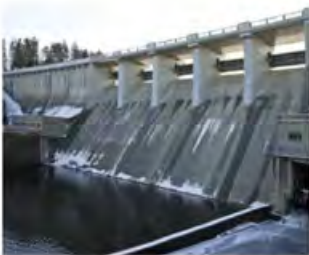
Rekonstrukce koruny a oprava návodního líce vodního díla Kružberk
