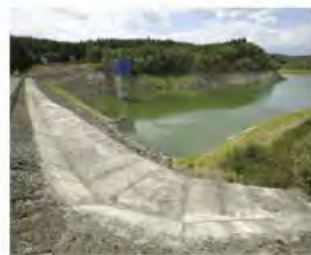
Rekonstrukce vodního díla Opatovice
