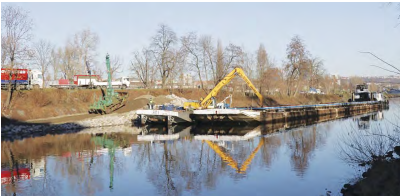
Práce na modernizaci dolní rejd plavební komory Štvanice
