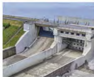
Rekonstrukce krajních polí bezpečnost přelivu VD Nechranice
