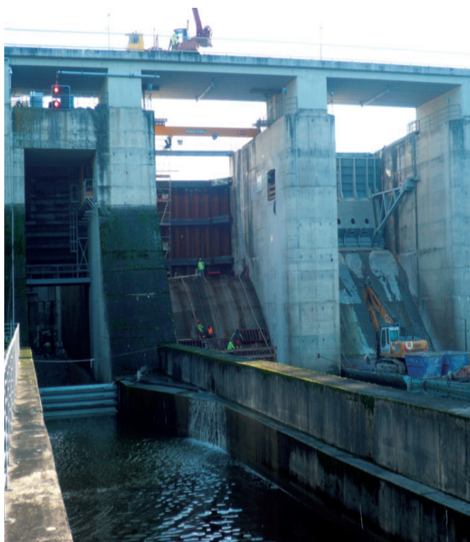
Probíhající vázání výztuže a montáže bednění na jednom z přelivů
