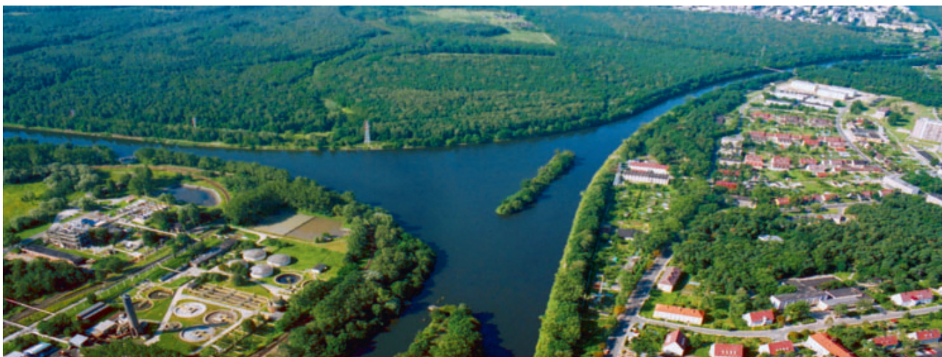
Slavnostní výkop průplavu Odra–Dunaj se uskutečnil 8. prosince 1939 u obce Nowa Wieś v blízkosti města Kędzierzyn-Koźle
