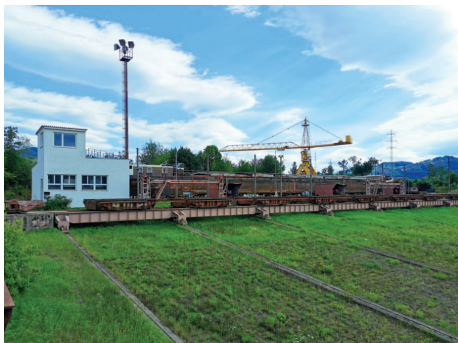
Modernizovaný lodní výtah pro spouštění hotových plavidel na hladinu Labe
