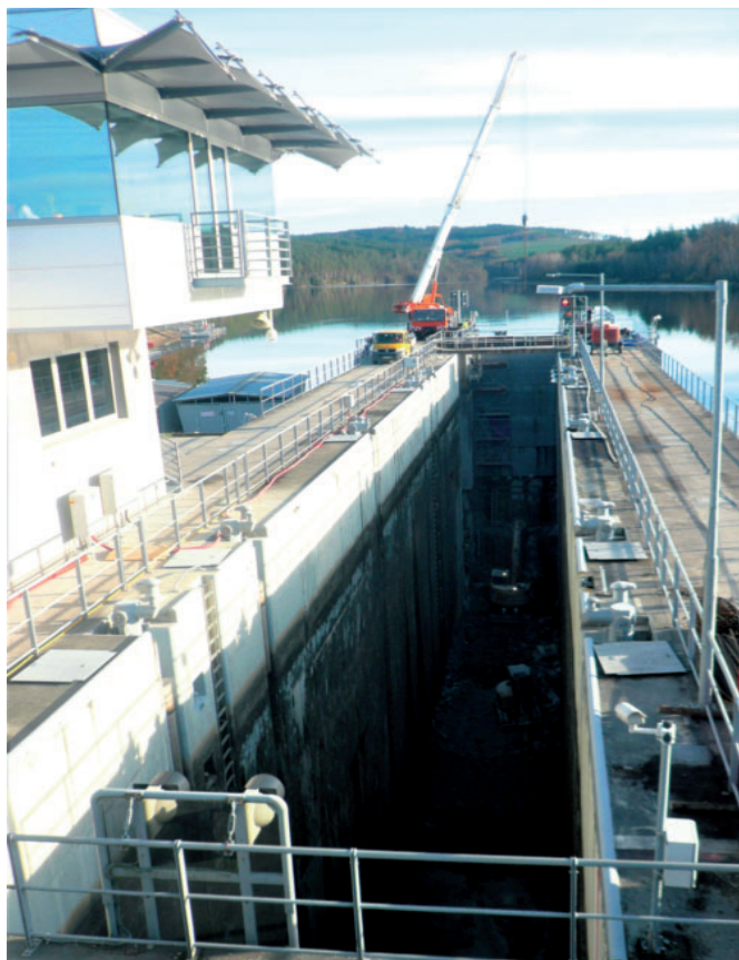
Pohled na plavební komoru – bourání dna plavební komory
