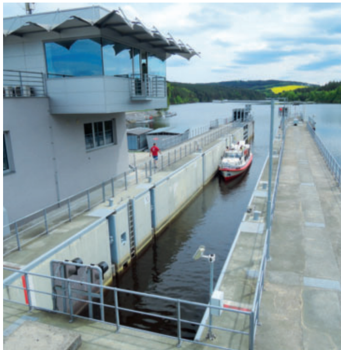
Plavební komora Hněvkovice prochází v současné době spolu s celým vodním dílem rozsáhlou modernizací pro lepší ochranu před velkými vodami
