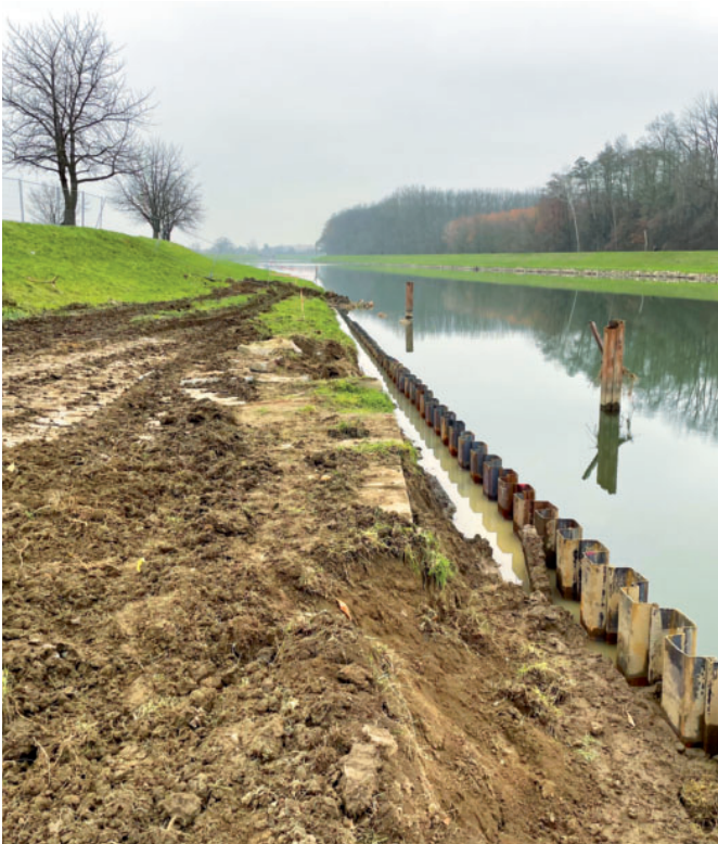
Výstavba přístaviště Kunovský les
