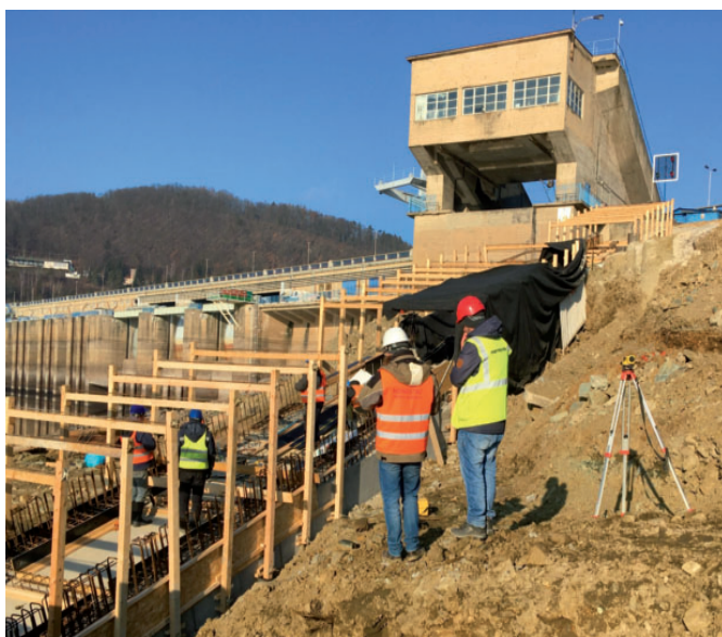
Práce na modernizaci lodního výtahu na přehradě Orlík
