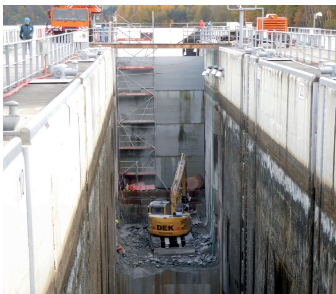
Bourání betonů dolního záporníku horních vrat
