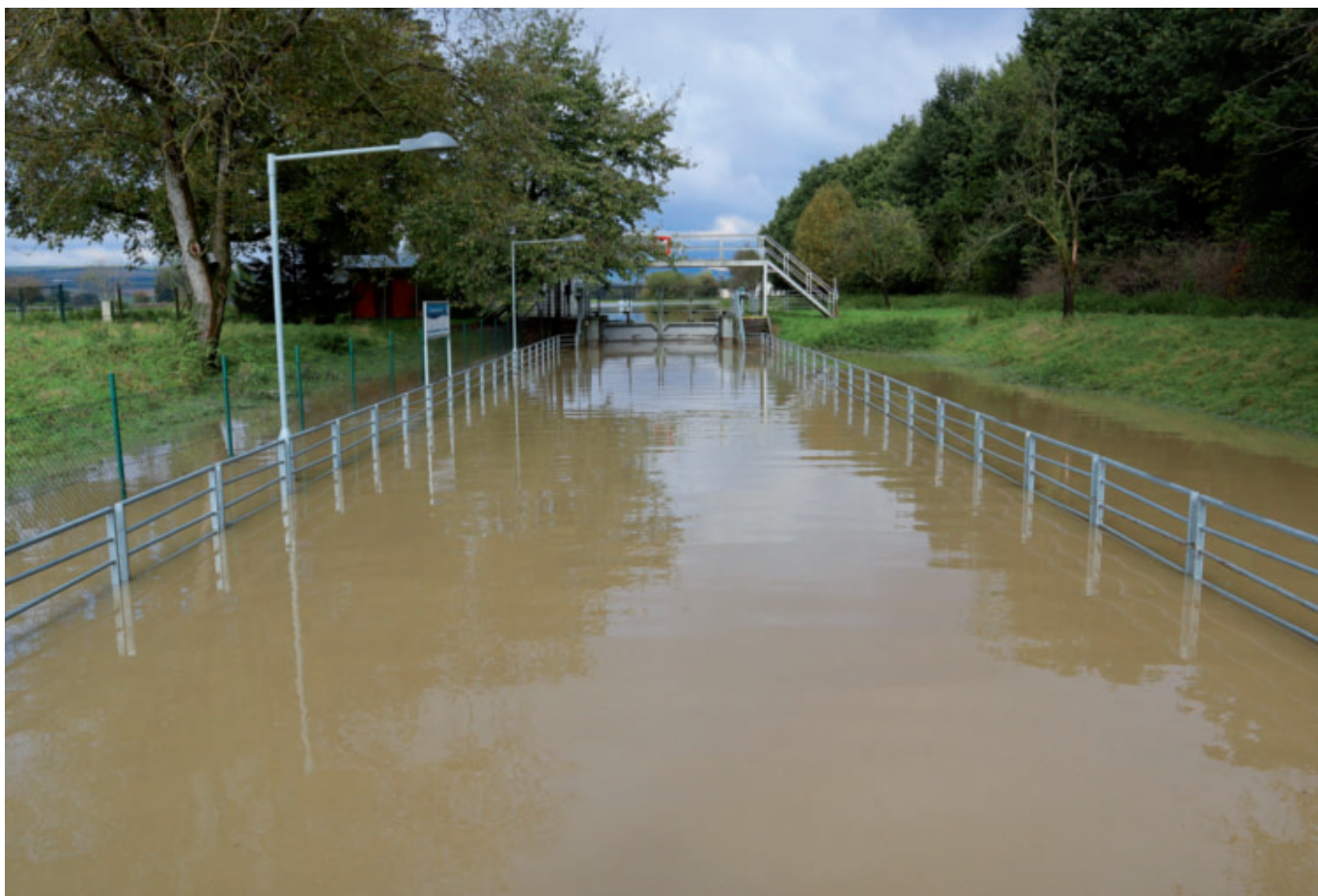
Plavební komora Nedakonice pod vodou
