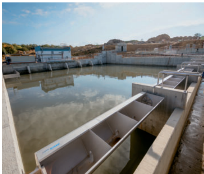
Nová retenční nádrž včetně čerpací stanice a sorpčního filtru
