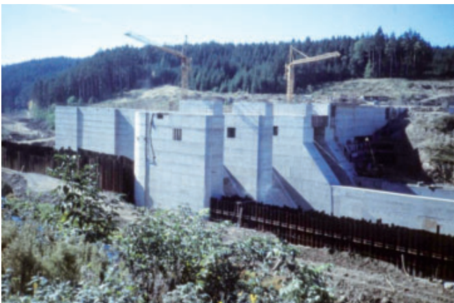
Pohled na stavbu hráze VD Hněvkovice z pravého břehu dolní vody v roce 1987
