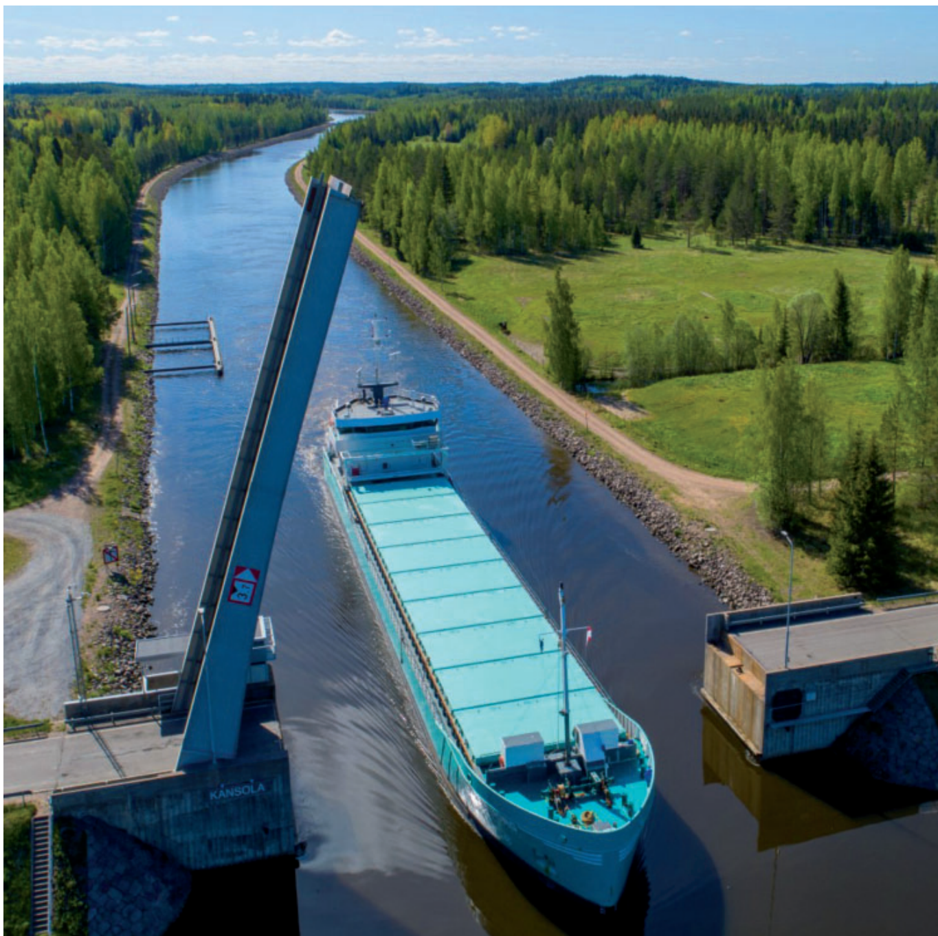
Průplav Saimaa o délce 43 km s 8 plavebními komorami spojuje Baltské moře s vnitrozemím Finska
