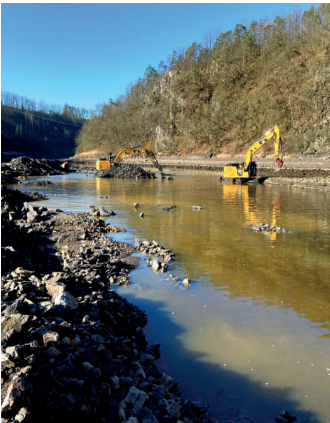
Práce na prohloubení plavební dráhy pod PK Kořensko
