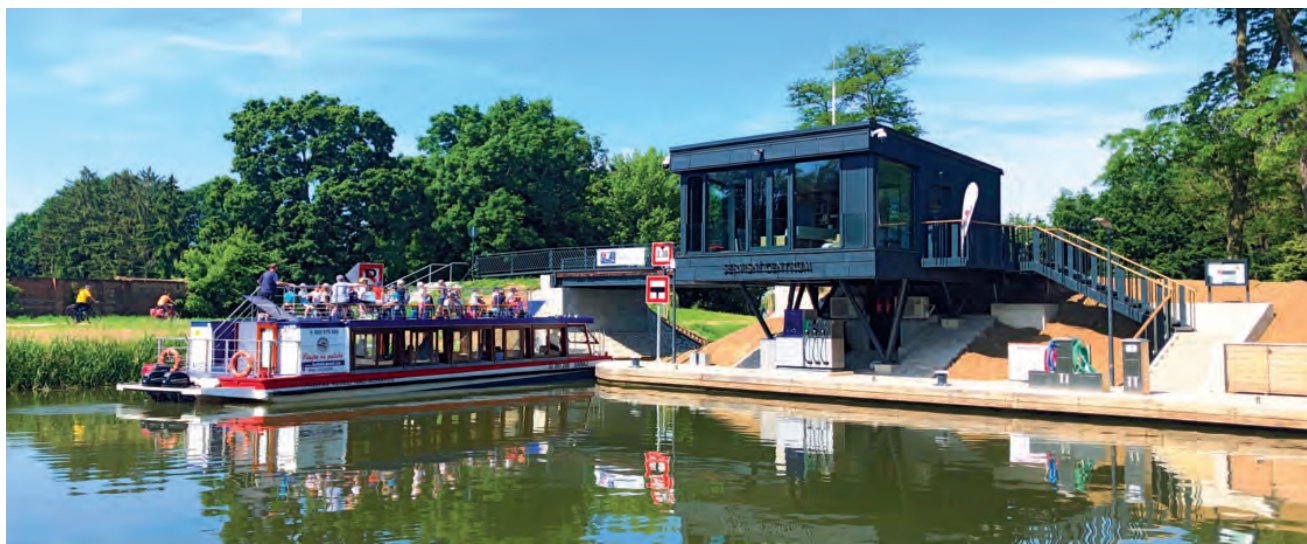
Velín nového servisního centra rekreačního přístavu Veselí nad Moravou
