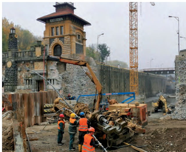
Demontáž a rozšiřování dolního ohlavi velké plavební komory
