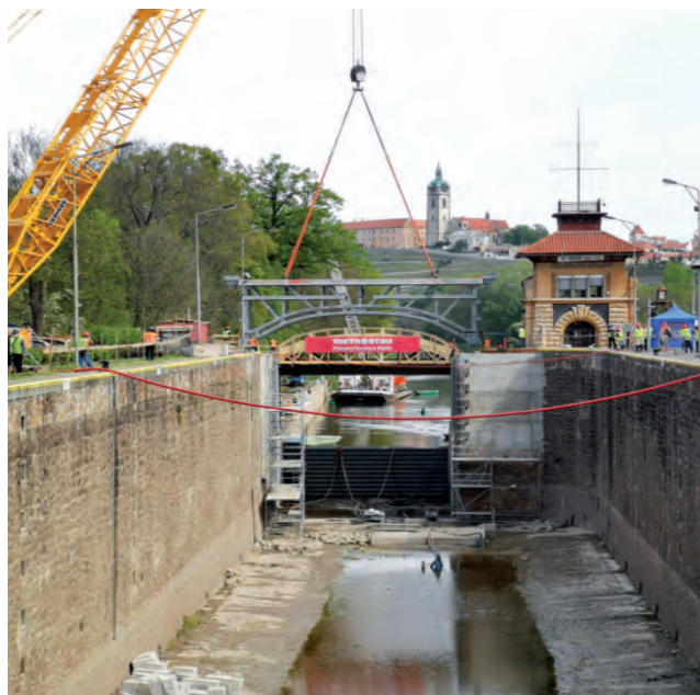
Osazování mostovky největším mobilním jeřábem v ČR
