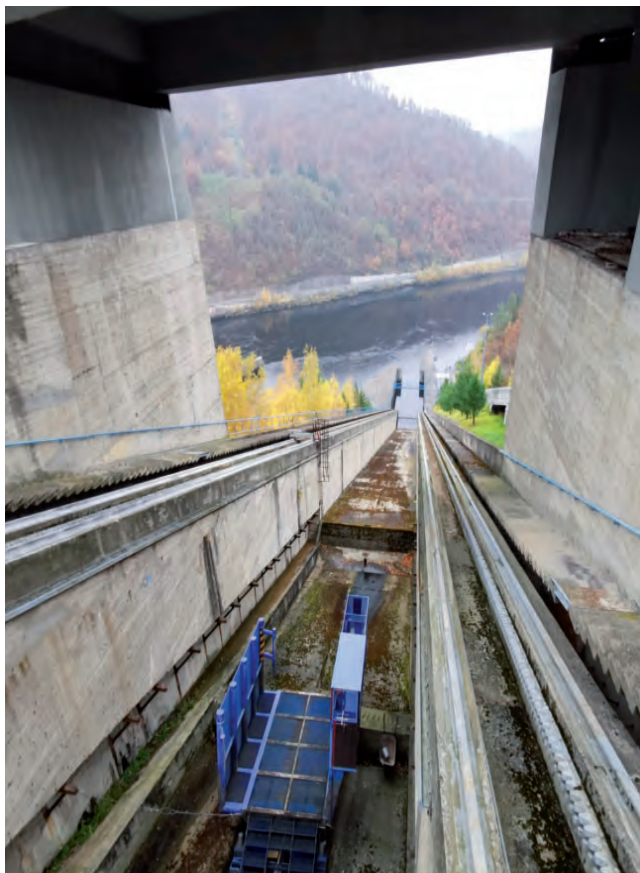
Pohled na kolejovou dráhu lodního zdvihadla Orlík
