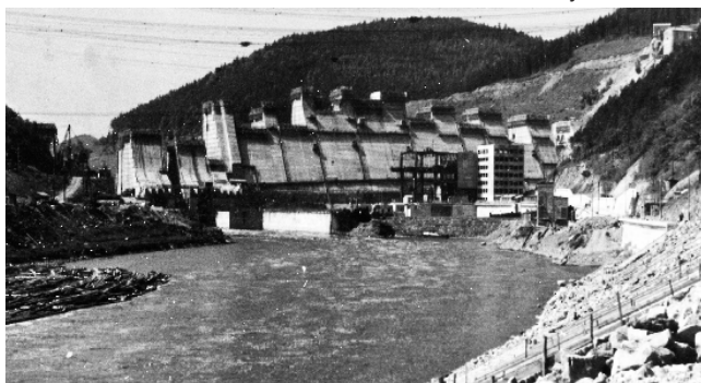
Stavba přehrady Orlík si vyžádala obrovské pracovní nasazení (postup prací v květnu 1960)
