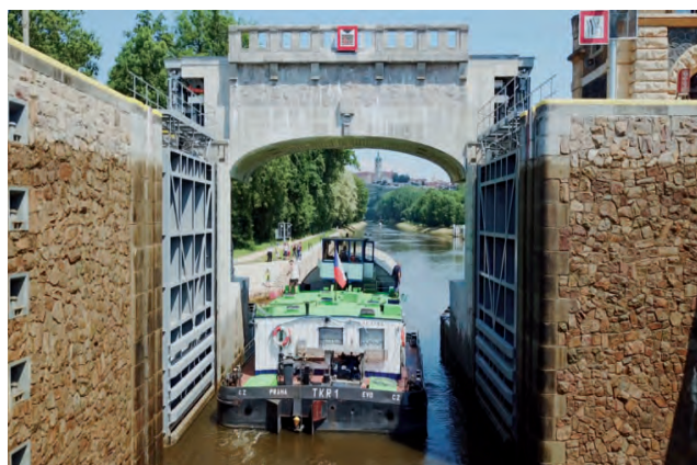
Pohled na rozšířené dolní ohlavi velké plavební komory
