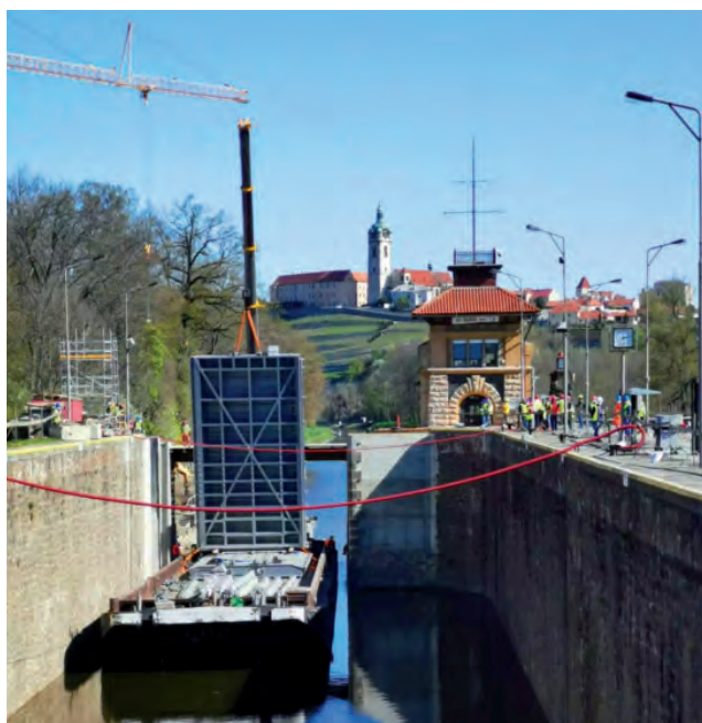
Montáž dolních vrat velké plavební komory o šířce 12 m
