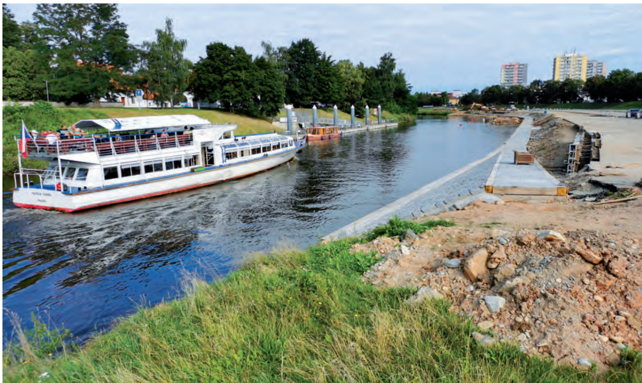
Konference Lodě na vltavské vodě se odehrála nedaleko staveniště nového pravobřežního přístaviště v centru Českých Budějovic
