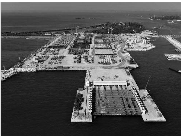
Výstavba kesonů u úžiny Malamocco.
