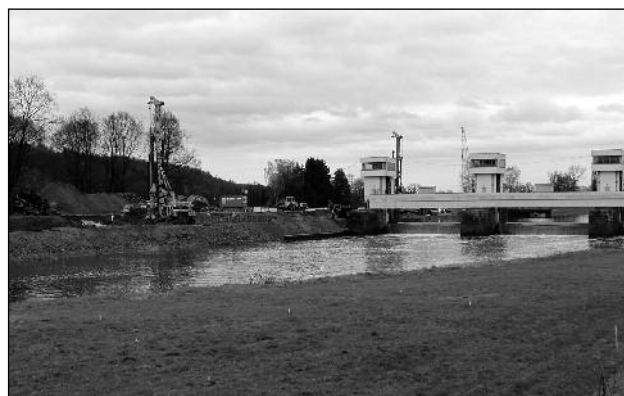
Výstavba plavební komory u jezu Hluboká nad Vltavou.
