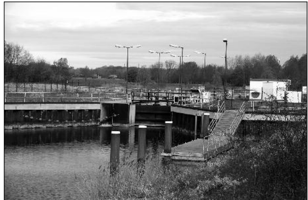
Plavební komora u jezera Cospudener See.
