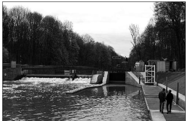
Plavební komora Connewitz byla dokončena před několika týdny a letos poprvé umožní spojení centra města Lipska vodní cestou s jezerem Cospudener See.
