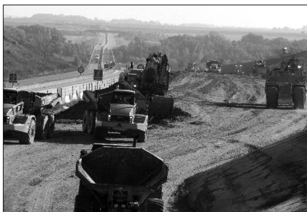
Přípravné práce na dálnici A 29 u obce Licourt. V těchto místech bude dálnici překračovat viadukt průplavu Seina - severní Evropa.
