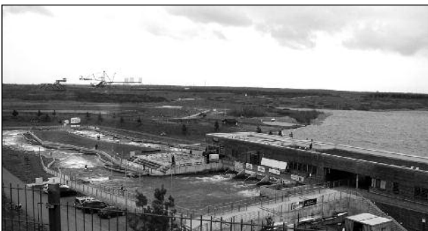
U jezera Markkleeberg See stojí moderní areál pro kanoisty a raftaře. Protože nejsou v okolí žádné řeky, na kterých by bylo možné takový areál zřídit, je voda do horní části divoké vody přečerpávána z jezera.
