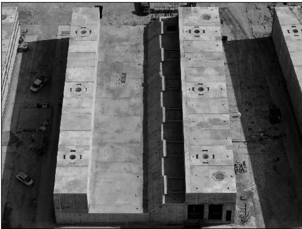
Dokončený keson v ochranném přístavu před transportem na dno úžiny Lido.
