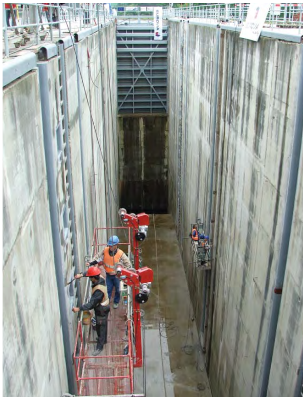
Práce na plavební komoře na přehradě Hněvkovice byly vzhledem k její hloubce náročné (2010)
