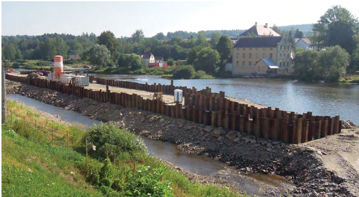
Výstavba plavební komory na jezu Hněvkovice – srpen 2015
