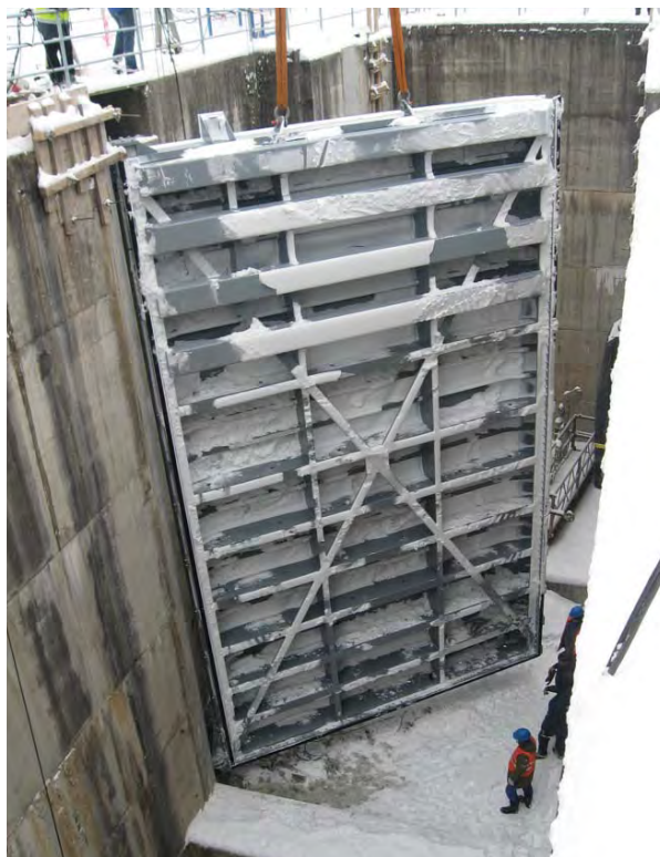
Osazování atypických horních deskových vrat plavební komory na přehradě Hněvkovice
