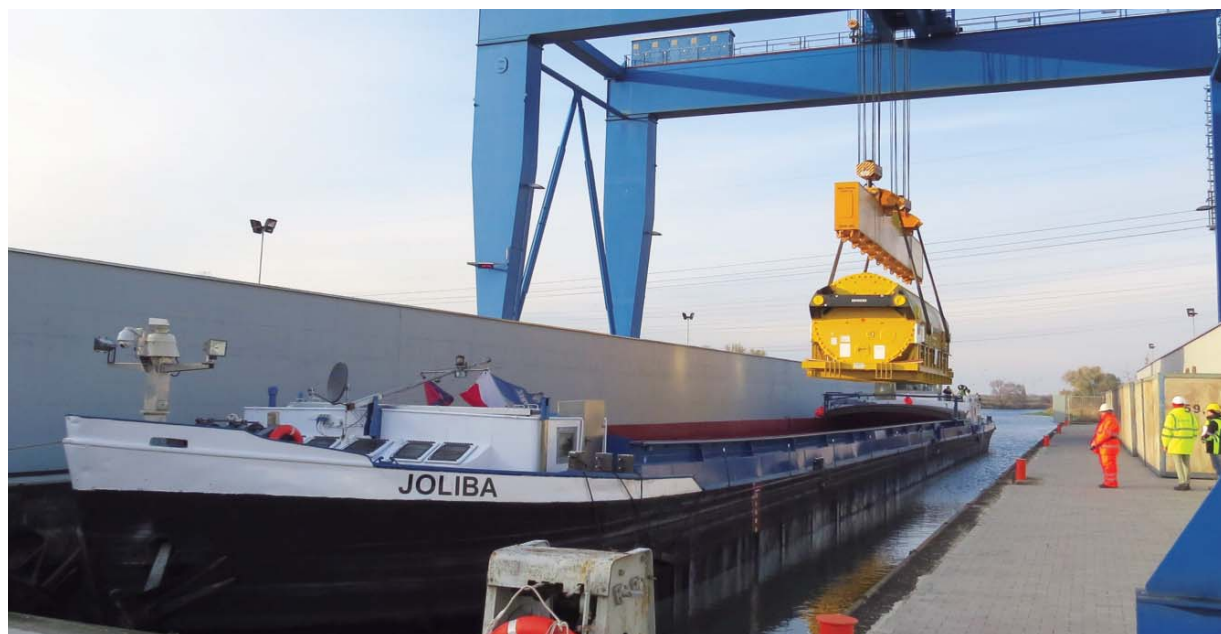
Překládka 476tunového generátoru v přístavu FAMET Opole
