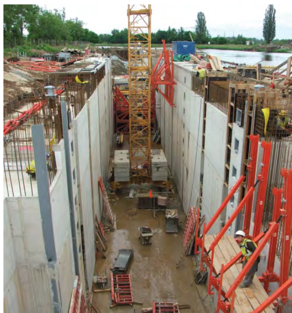
Plavební komora České Vrbné ve výstavbě v roce 2010
