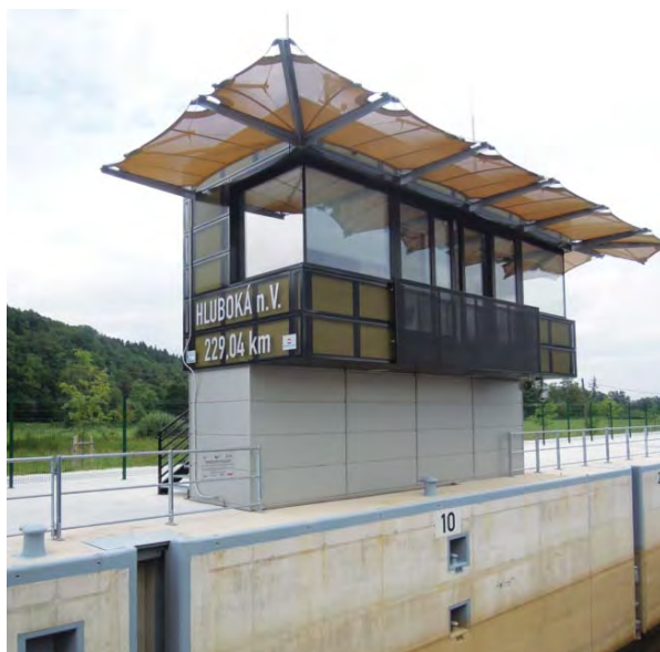
Architekti se podíleli na architektuře objektů vodní cesty
