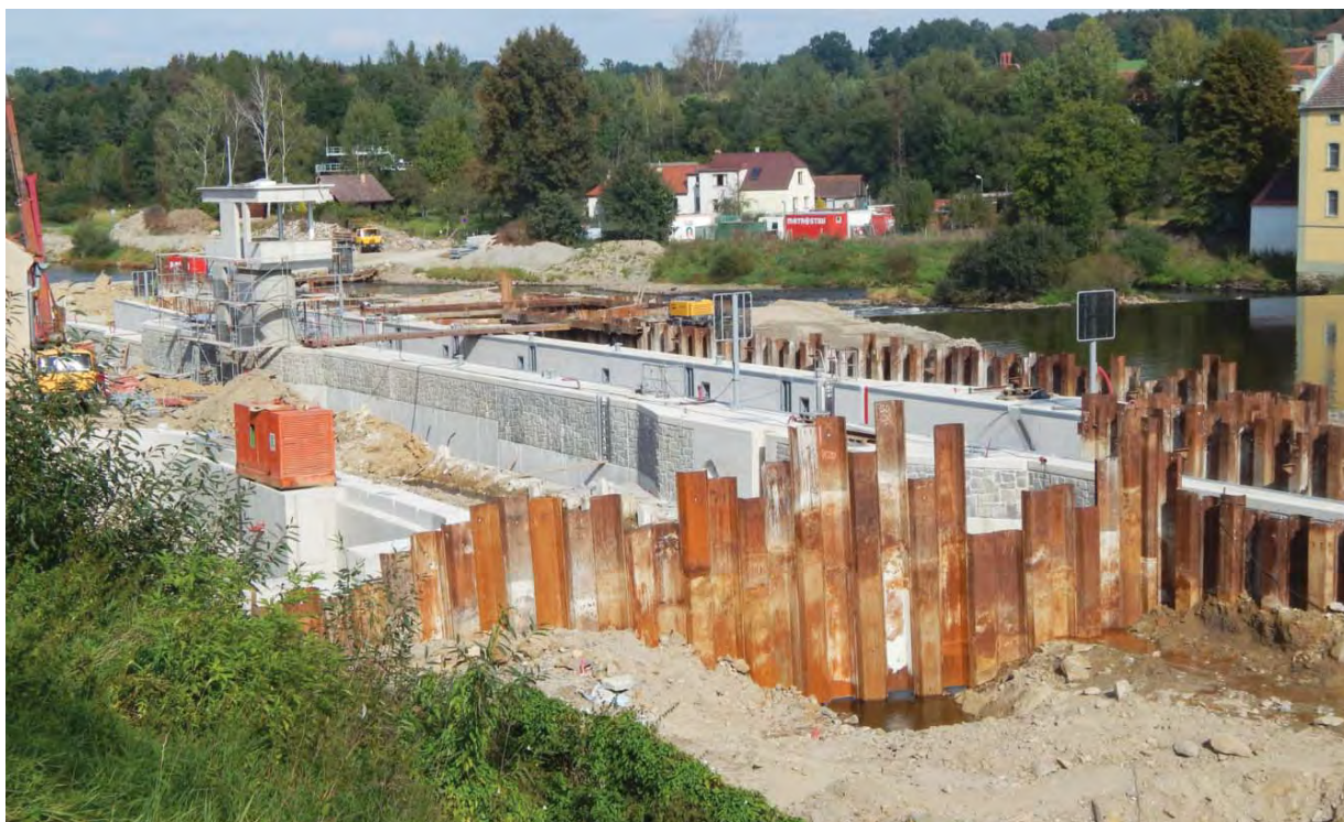
Výstavba plavební komory na jezu Hněvkovice – září 2016
