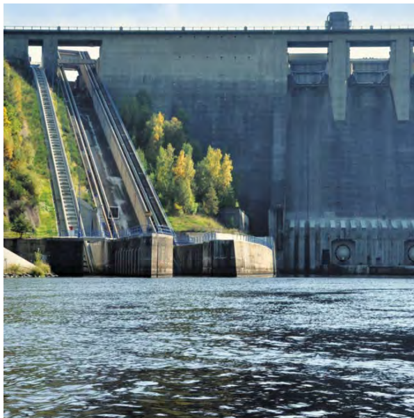
Fotografie stávajícího stavu na vodním díle Orlík. Vpravo od funkčního lodního zdvihadla pro malá plavidla stojí kolejová dráha bez osazené vany velkého lodního zdvihadla
