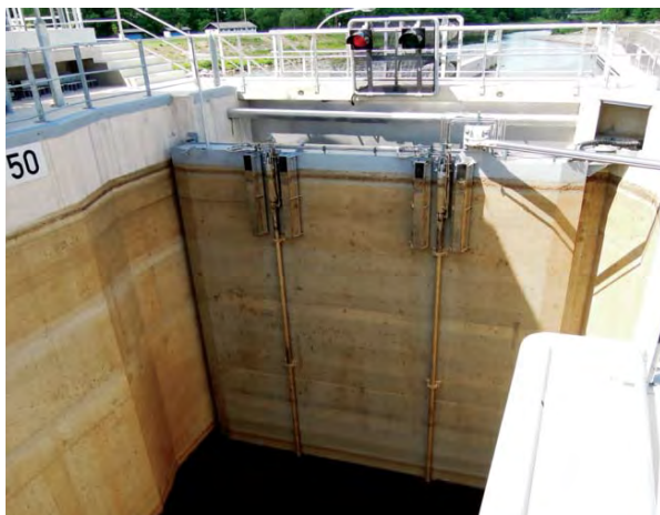
Dolní desková vrata plavební komory České Vrbné
