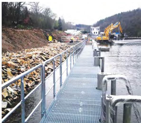
Modernizace rejd plavební komory Kořensko
