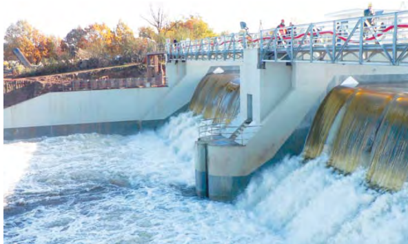
Zmodernizovaný jez České Vrbné dokáže lépe převádět povodně
