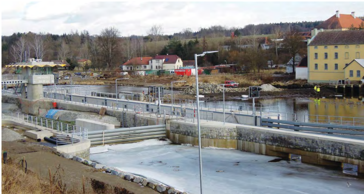
Práce na plavební komoře u jezu Hněvkovice v březnu 2017
