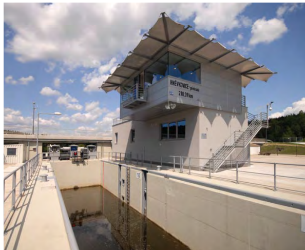
Velín plavební komory na přehradě Hněvkovice
