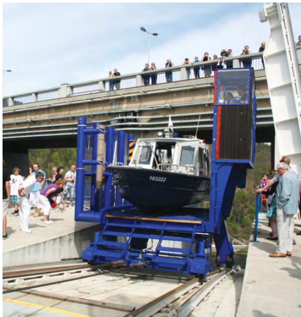
Lodní zdvihadlo pro malá plavidla na Orlíku bylo v roce 2013 rozšířeno investicí Ředitelství vodních cest ČR
