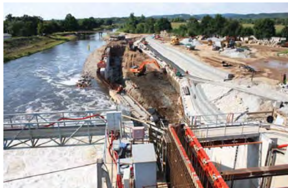
Výstavba dolní rejdy plavební komory České Vrbné v roce 2010
