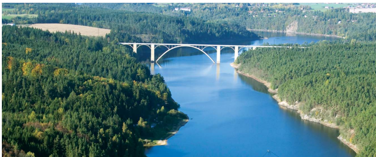
510 metrů dlouhý Podolský most byl postaven v letech 1939-1943
