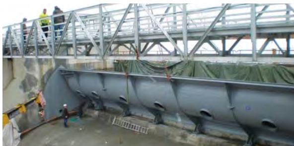
Modernizace jezu České Vrbné (2009)
