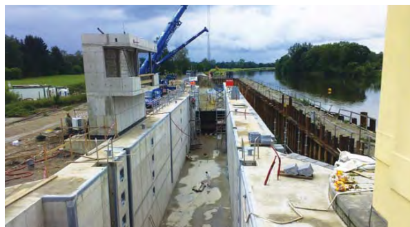
Výstavba plavební komory Hluboká nad Vltavou (2012)
