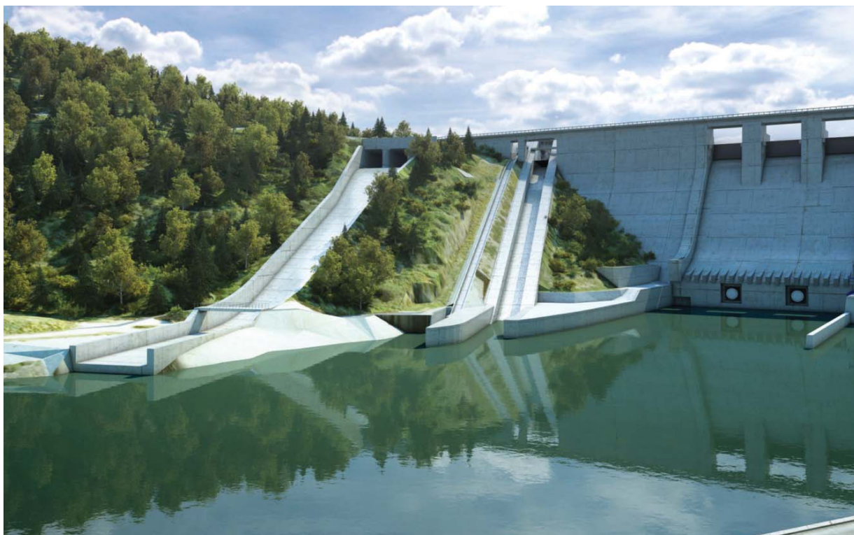
Vizualizace nového bezpečnostního přepadu vodního díla Orlík (vlevo) a nedokončené lodní zdvihadlo (vpravo)
