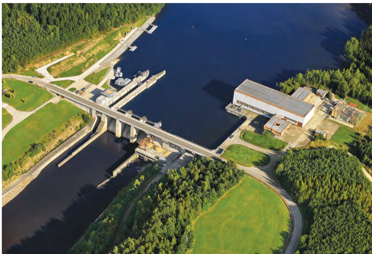
Celkový pohled na VD Hněvkovice s dokončenou plavební komorou
