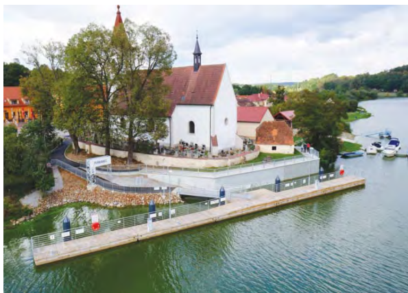
Přístaviště Purkarec dokončené v roce 2016
