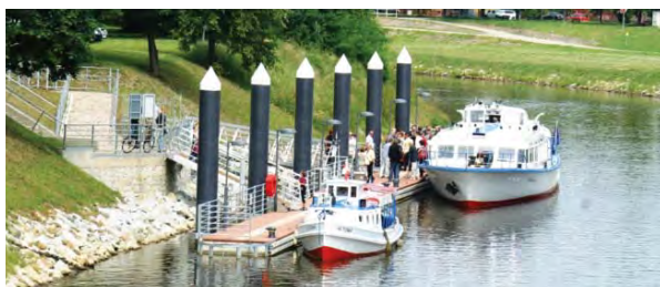
Přístaviště Lannova loděnice na levém břehu Vltavy v Českých Budějovicích
