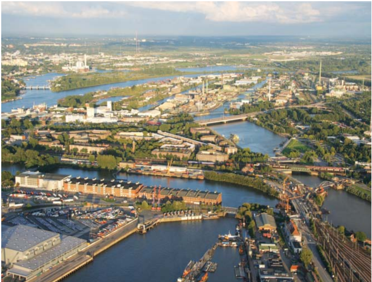
Česká přístavní území Saalehafen Peutehafen se nacházejí na pomezí námořní a říční části hamburského přístavu
