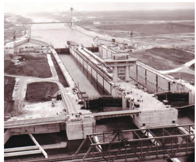
Zahájení stavby vodní cesty z Dunaje do hlavního města následovalo po dokončení průplavu Dunaj-Černé Moře, který byl uveden do provozu v květnu 1984
