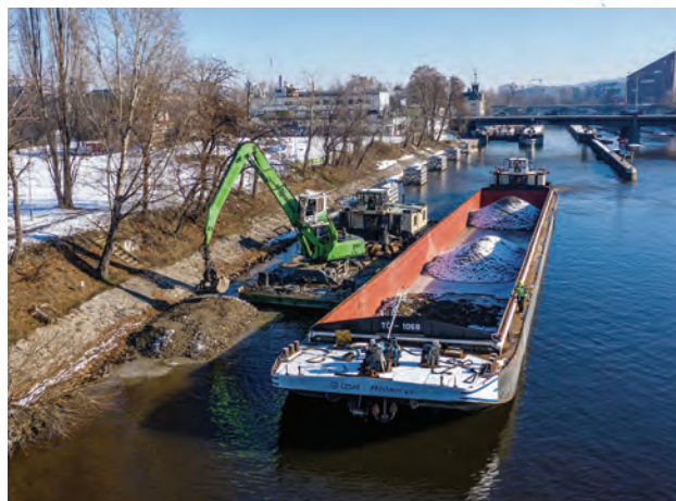
Přípravné práce v horní rejdě
