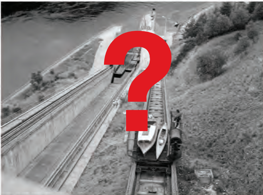
Šikmé lodní zdvihadlo pro sportovní lodě o hmotnosti 3,5 tun na VD Orlík překonává spád 71,5 m. Vlevo 40 let nedokončené lodní zdvihadlo pro lodě 300 tun
