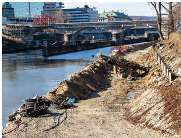
Dočasné zemní kotvy
