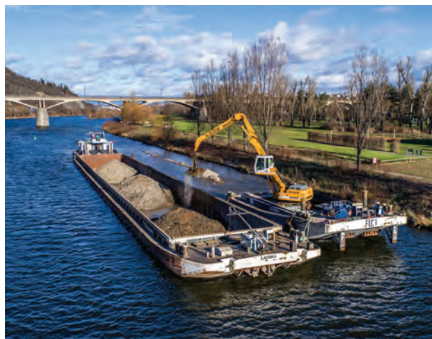
Nakládání vytěženého sedimentu
