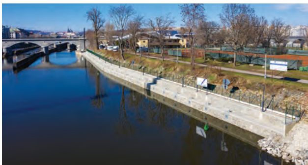
Dokončené nové dolní ohlavi plavební komory Štvanice
