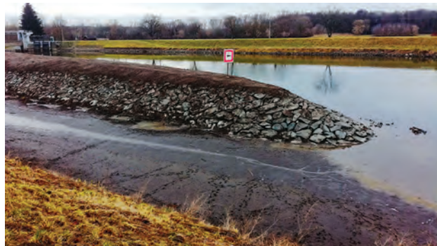
Oprava opevnění horní rejdy plavební komory Nedakonice
