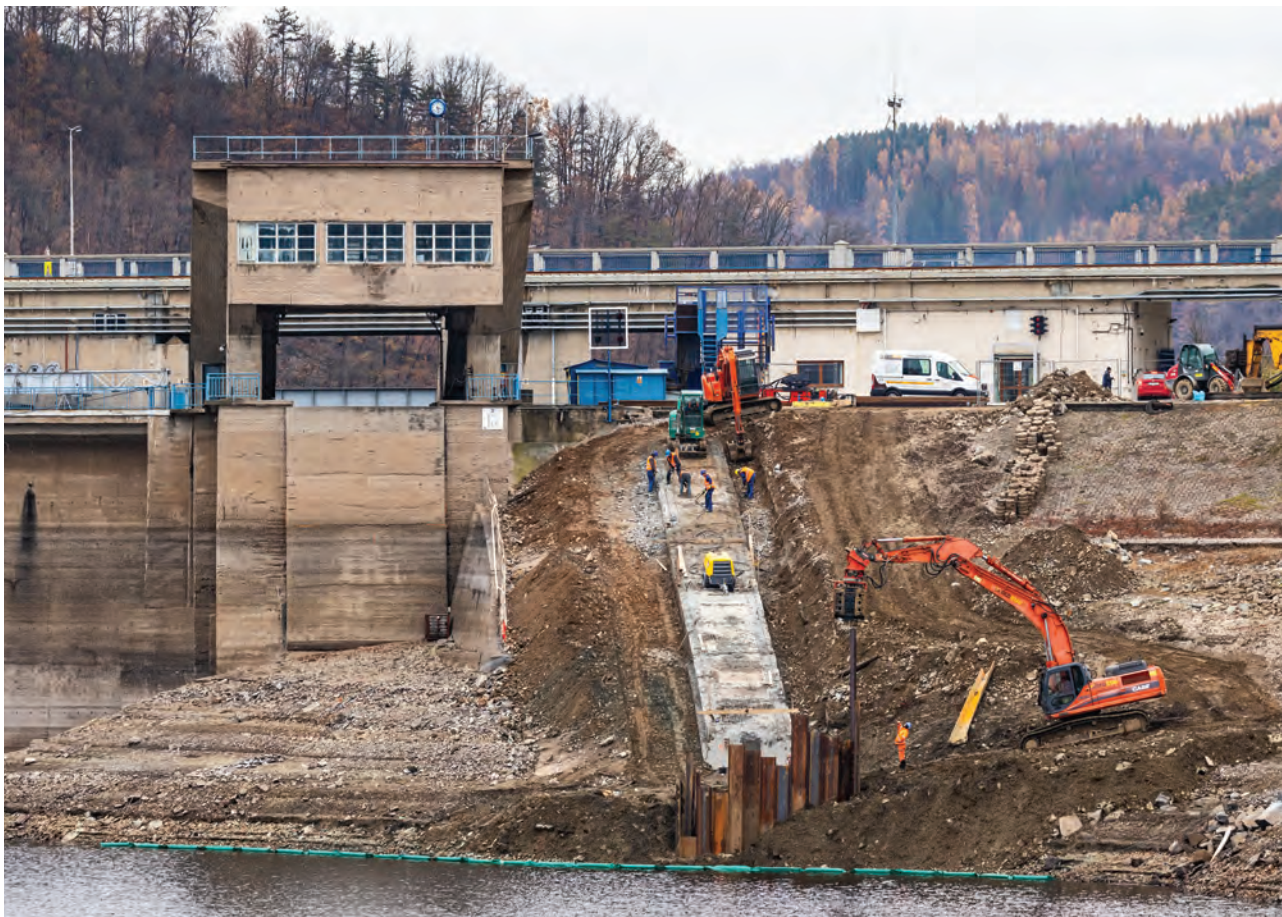
Dokončovací práce na modernizaci kolejové dráhy lodního výtahu Orlík pro sportovní plavbu
