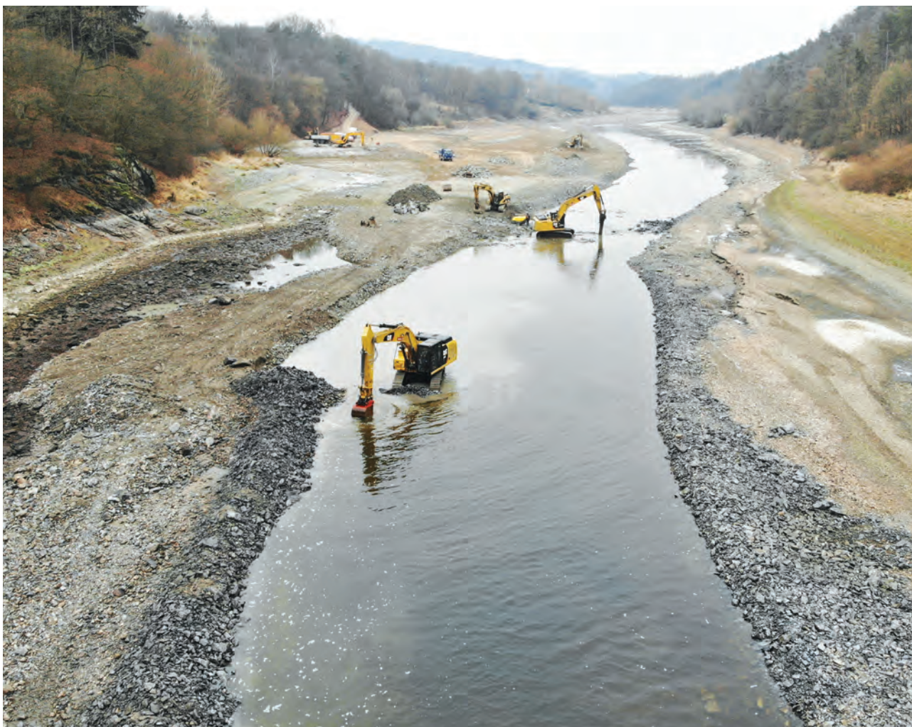
Provádění těžby v korytě - pohled po proudu
