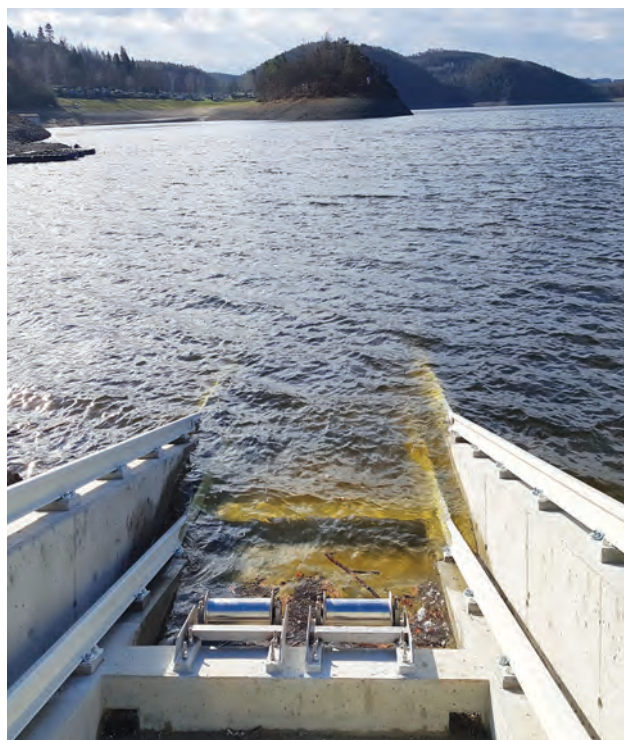
Dokončovací práce pro usazení nové kolejové dráhy lodního výtahu
