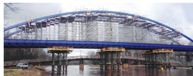
Pohled na montáž mostního oblouku z řeky
