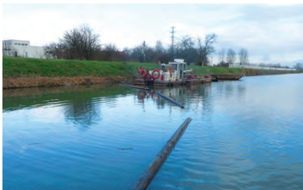
Obnova plavebních hloubek rejd PK Veselí nad Moravou
