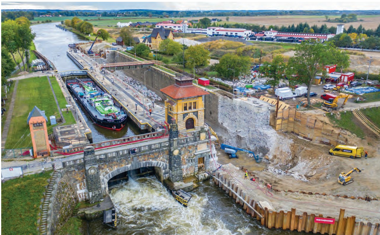
Staveniště modernizace plavební komory Hořín
