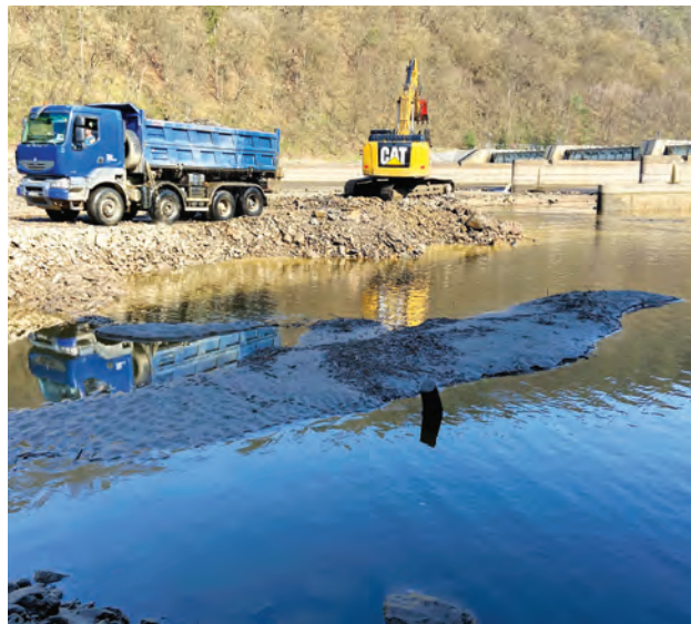
Dočasná příjezdová komunikace pod vodním dílem
