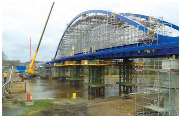
Dokončování horního oblouku nového mostu
