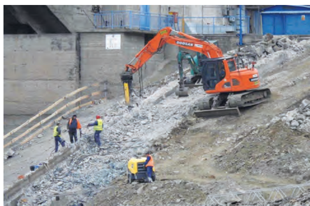
Bourací práce původní kolejové dráhy lodního výtahu
