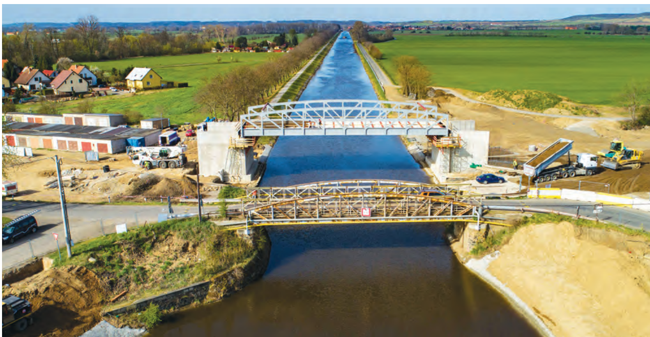
Starý a nový silniční most v Lužci nad Vltavou
