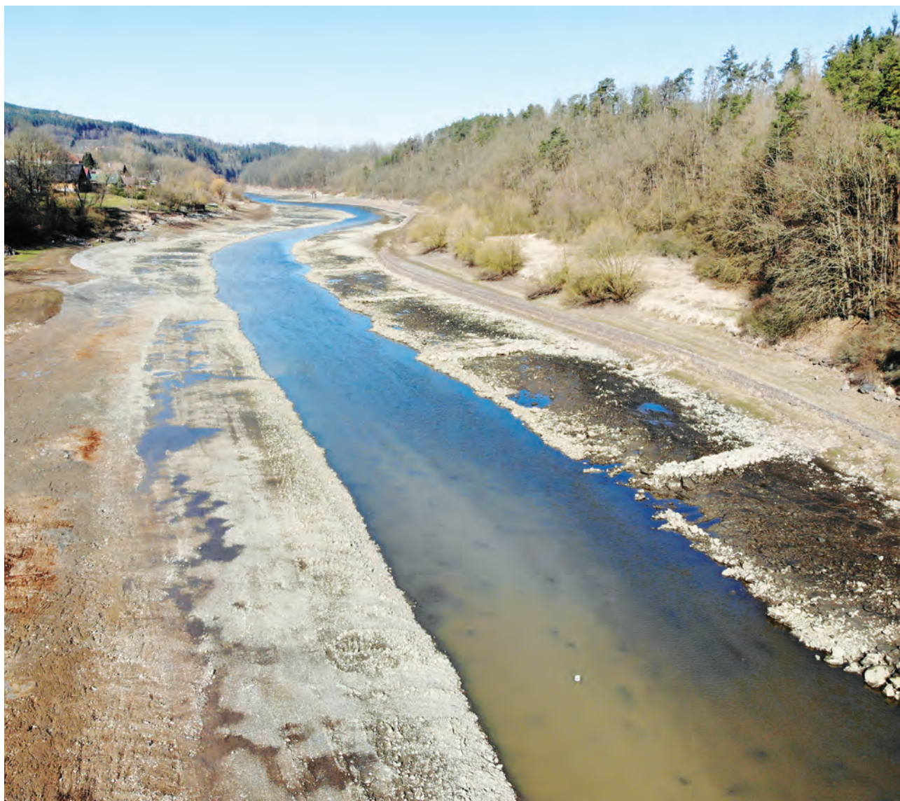
Pohled na dokončenou část úseku s výhony - pohled po proudu
