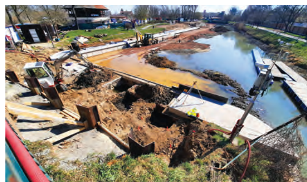
Dokončovací práce 1. etapy modernizace rekreačního přístavu před zahájením plavební sezóny
