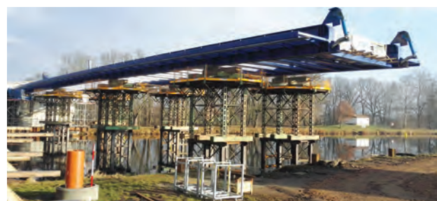
1. a 2. výsun mostovky
