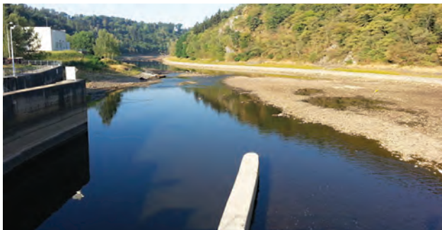
Nedostatečné plavební podmínky byly patrné i při pohledu pouhým okem. Foto: Radek Zidek
