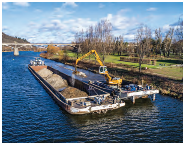
Prohrábký plavební dráhy na Vltavě v Praze u Branického mostu
