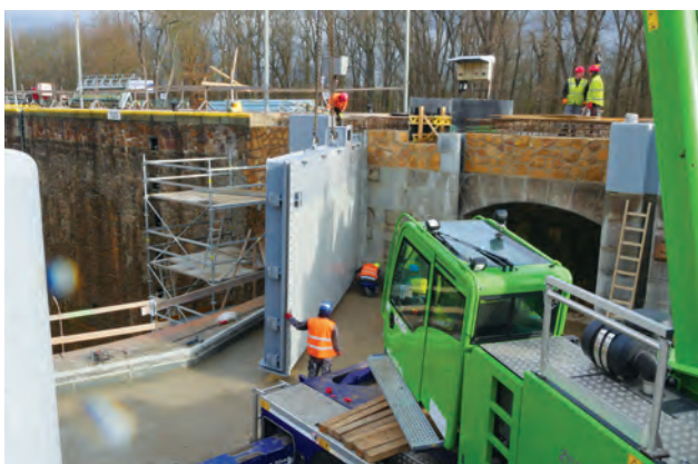
Osazení horních vrat plavební komory Hořín
