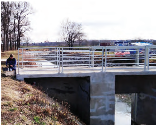
Stavební objekt regulačních stavidel
