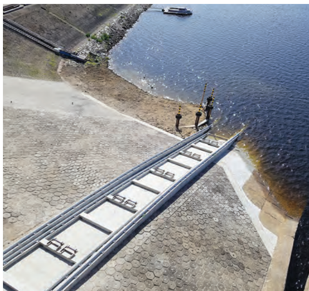
Dokončovací práce pro usazení nové kolejové dráhy lodního výtahu
