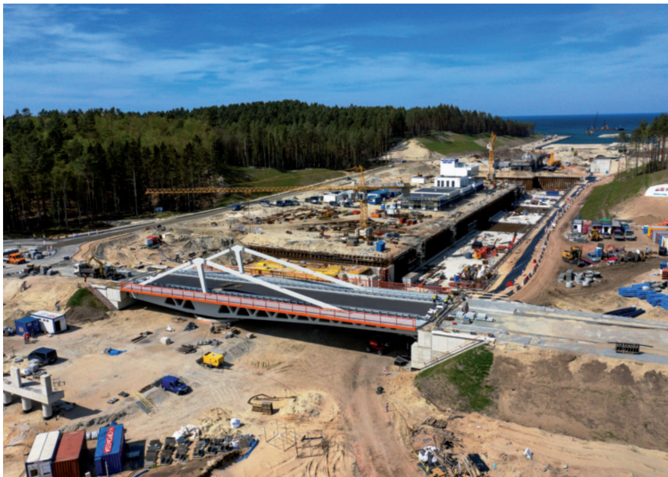
Výstavba otočného mostu a plavební komory na průplavu do Viselského zálivu
