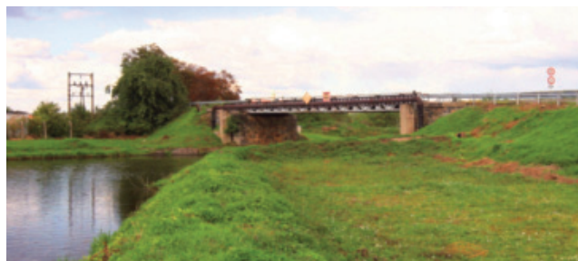
Původní mostní konstrukce přes plavební kanál
