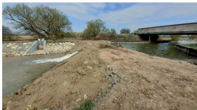
Napouštění opraveného kanálového úseku mezi Veselím nad Moravou a Vnorovy
