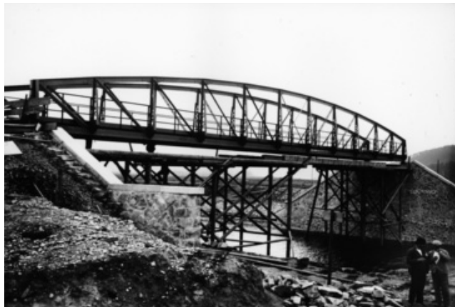
Původní mostní konstrukce přes plavební kanál
