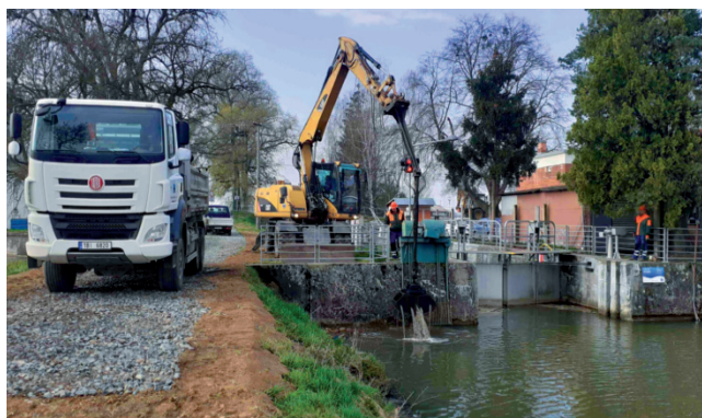
Čištění rejd plavební komory Spytihněv
