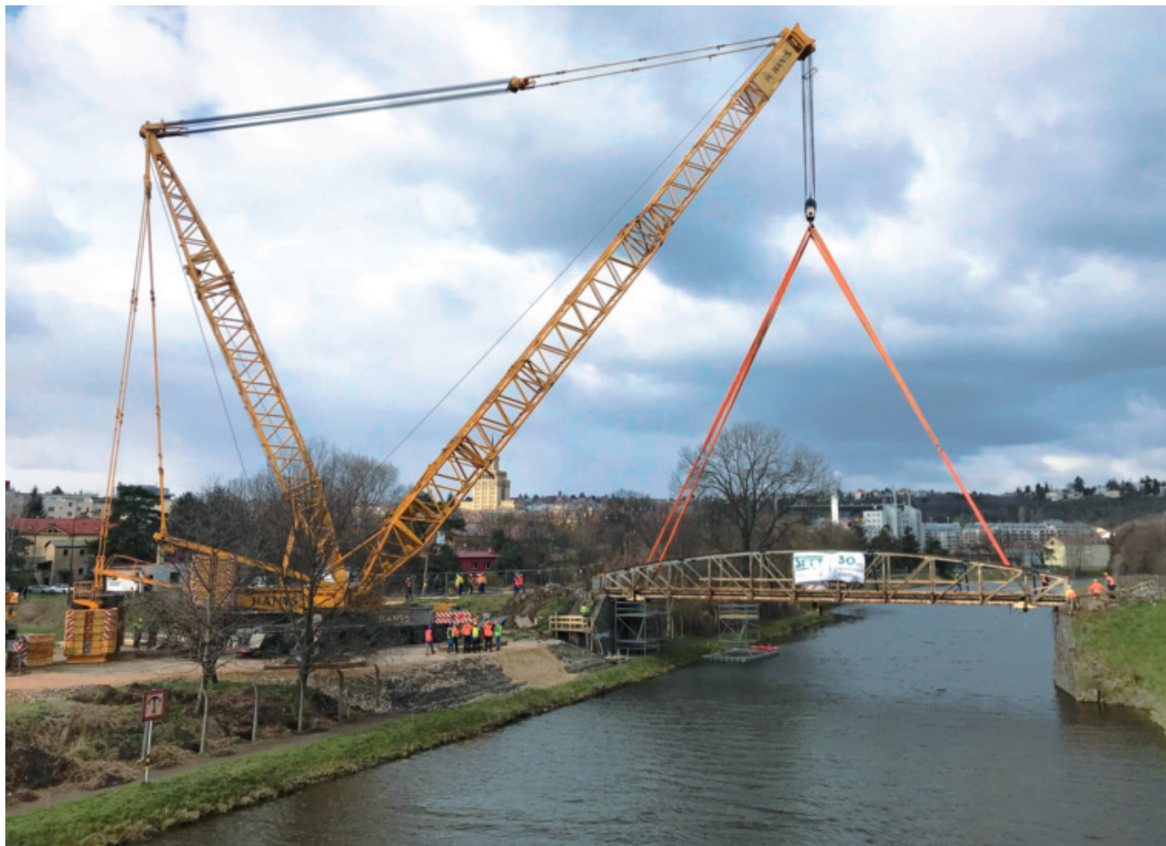
Největší mobilní jeřáb v Česku demontoval historický most u čistírny v Praze Bubeneč
