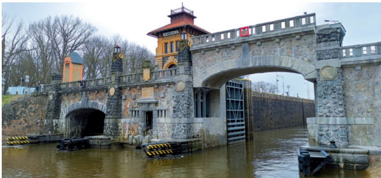
Celkový pohled na zdymadlo Hořín – nová mostovka ve zdvižené poloze
