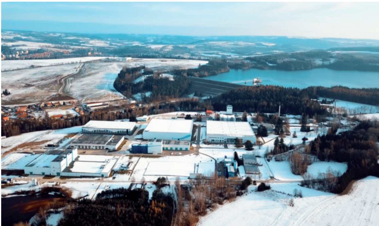
Pohled na Úpravnu vody Želivka a vodní nádrž Švihov. První objekt zleva vzadu, s motivem vlny na opláštění, je nově zbudovaná hala GAU
