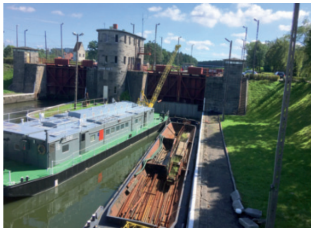
Práce na modernizaci plavební komory Nowa Wieś na Gliwickém průplavu
