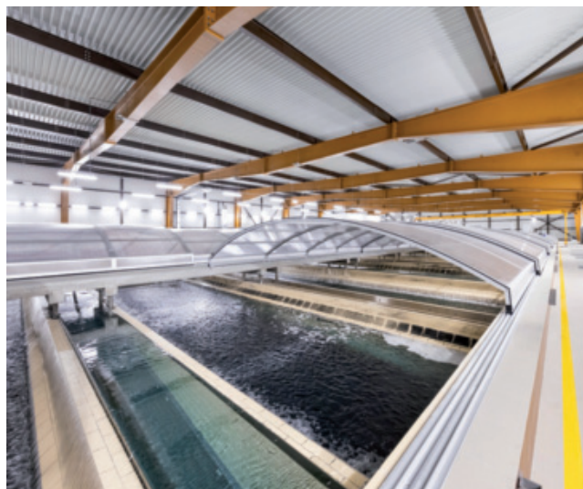
Hala GAU, 2. NP. Pohled na otevřený filtr – filtrování upravované vody
