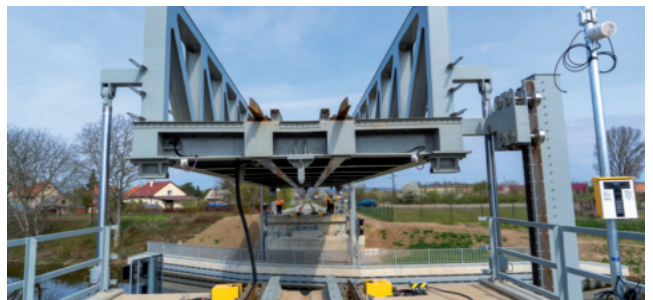
Zkušební zdvih nového železničního mostu v Lužci nad Vltavou
