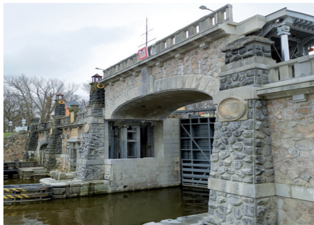
Detail nové mostovky velké plavební komory Hořín ve zdvižené poloze
