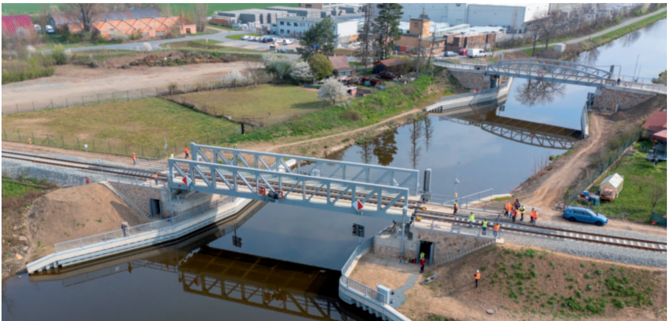
Zkušební zdvih nového železničního mostu v Lužci nad Vltavou
