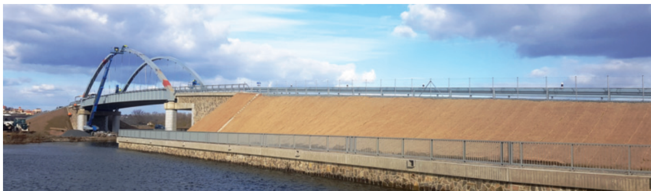
Nový silniční most zprovozněný v březnu 2021
