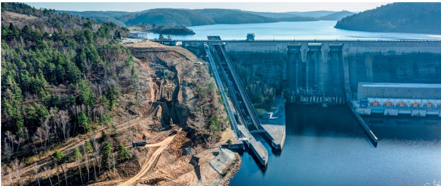
Zemní práce na otevřené části skluzu, březen 2022
