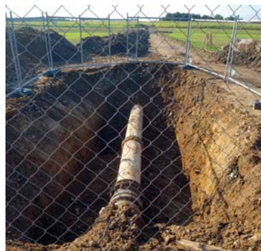
Na rovných úsecích vznikaly stavební jámy každých 136 metrů.
