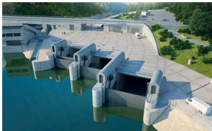
Vizualizace vtoků do přelivu na horní vodě
