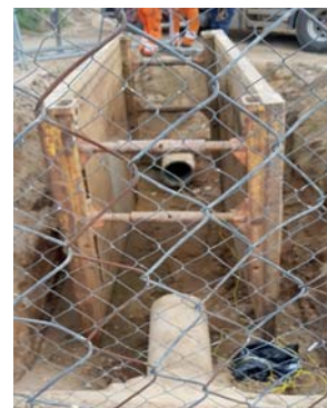
Pro vstup se odstraní část původního potrubí.
