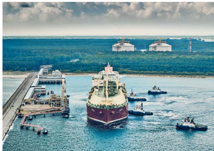
Námořní LNG terminál v polském Svinoúšti prochází rozsáhlou modernizací a navyšuje kapacitu, takže dále sníží závislost na ruském plynu
