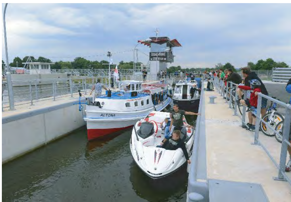
Kontrola Evropského účetního dvora se týkala reálných staveb, které dnes již slouží plavbě. O jejich užitečnosti se také přesvědčují návštěvníci a uživatelé vodních cest, jako např. na plavební komoře České Vrbné, kterou již navštívily tisíce lidí.
