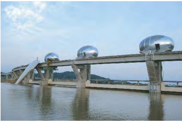
Jez Ipo na řece Han v červnu 2011. Vejcovité struktury na pilířích byly již instalovány. Jez Ipo, který představuje „volavku“ (maskota kraje Yeosu), ukazuje zrození života tím, že kryty strojoven byly navrženy ve tvaru vejce
