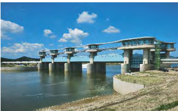
Jez Juksan na řece Yeongsan. Na obr. je vidět příprava na povodeň, byla zdvižena všechna jezová pole. Červen 2011
