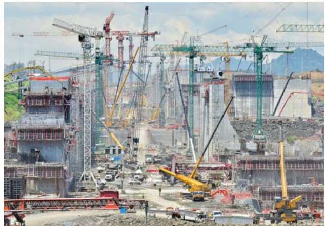
Výstavba nových plavebních komora na Panamském průplavu
