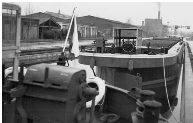
Plavební kanál v přístavu Bašov v době plného provozu
