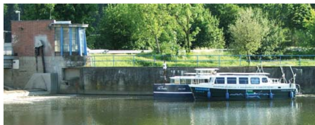
Lodě zakotvily u jezu Bělov v místech připravované plavební komory
