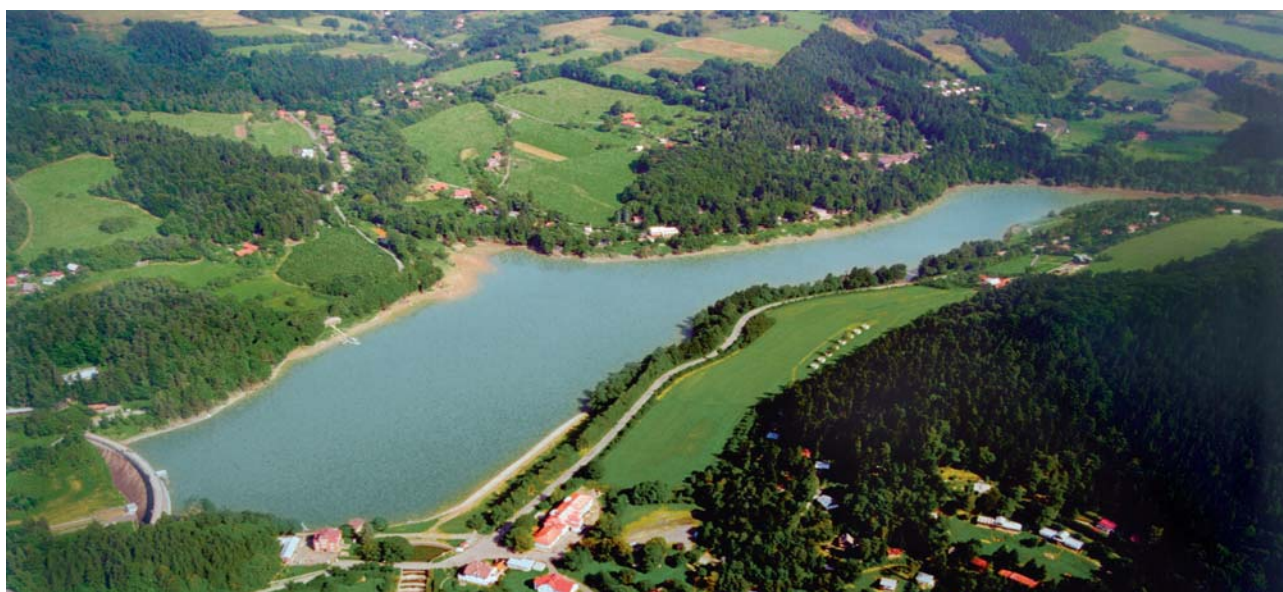
... na samotném průplavu Dunaj-Odra byla dokončena pouze přehrada Bystřička (1908-1912)
