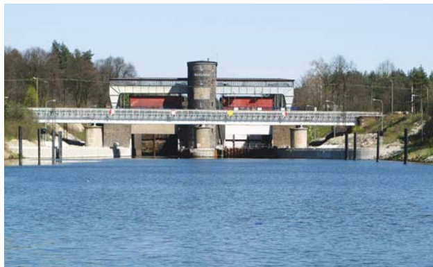
Dvojitá plavební komora č. 1 na Gliwickém průplavu měla sloužit i lodím plujícím na odersko-dunajském průplavu, který z tohoto průplavu odbočuje
