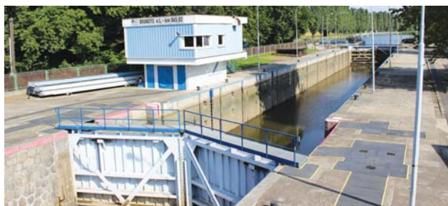
Plavební komora v Brandýse nad Labem se dočká zásadní modernizace
