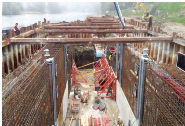
Stav výstavby Plavební komory Hněvkovice v březnu 2016
