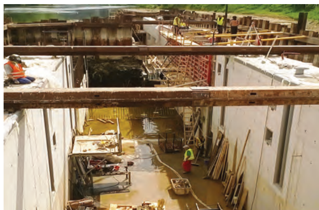
Stav výstavby Plavební komory Hněvkovice 23. května 2016
