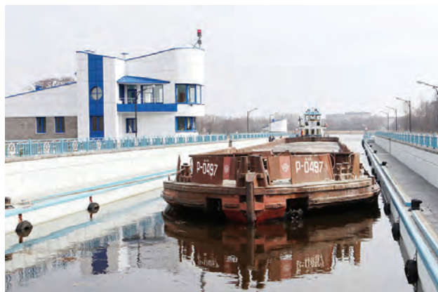
Plavební komory v západní části běloruského průplavu Dněpr-Bug již prošly kompletní přestavbou na plavební třídu Va. Na obr. nová plavební komora „Záluží“ otevřená v roce 2015
