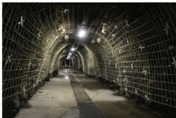
VD Šance - drenážní štola v Ostravici
