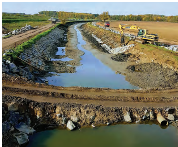
Opravy opevnění v úseku Vnorovy - Veselí nad Moravou (2017-2018)
