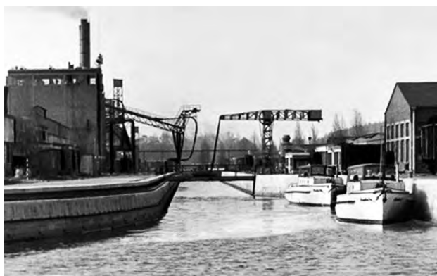
Přístav Baťov v Otrokovcích byl se svým vysavačem cílem pro přepravu uhlí po Baťově kanále. Zde bylo uhlí z lodí vysáto pro potřeby závodní teplárny (1938)
