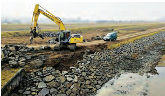
Práce na opravách opevnění Baťova kanálu
