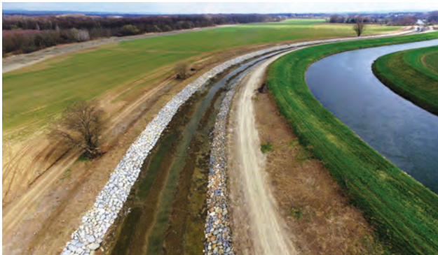
Opravený úsek Baťova kanálu mezi Vnorovy a Veselím nad Moravou před napuštěním
