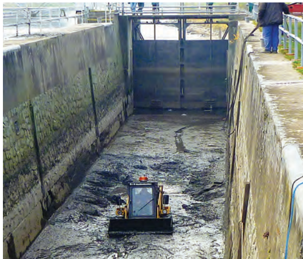
Povodí Moravy musí pravidelně čistit plavební komory od nánosů bahna (PK Kunovský Les)
