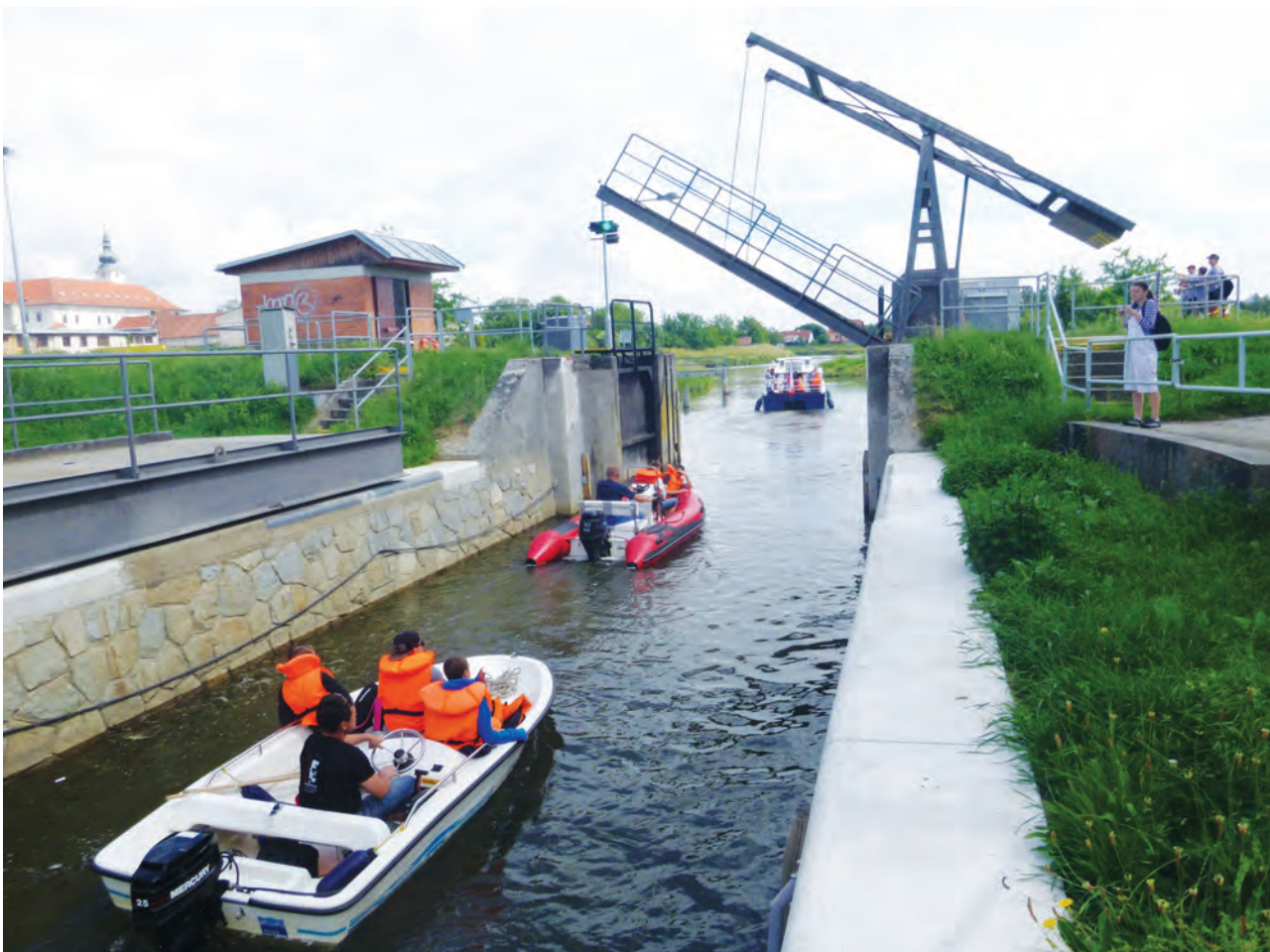
Plavební komora Uherský Ostroh se zvedací lávkou a otočným mostem (vlevo)
