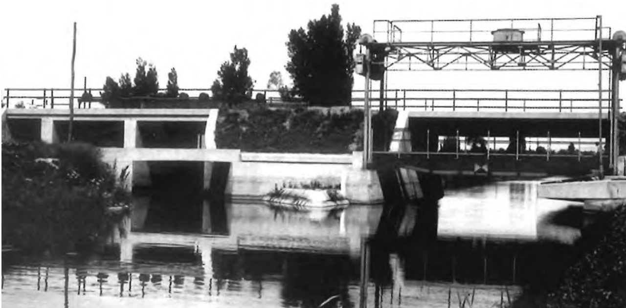
Železniční zvedací most, mostovka v dolní poloze, v pozadí silniční most, Veselí nad Moravou (1938)
