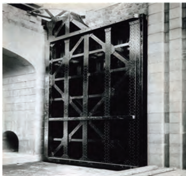
Pohled na původní vzpěrná vrata v roce 1905
