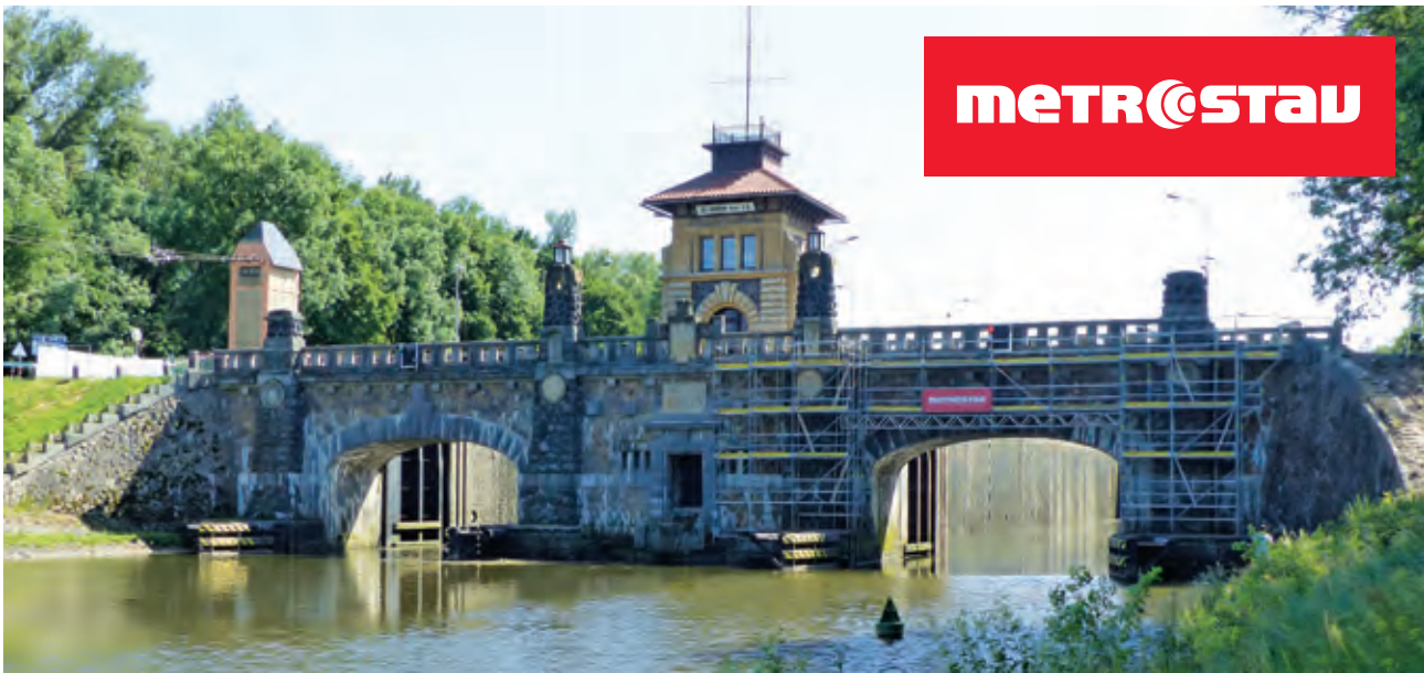
Firma METROSTAV zahájila v červnu modernizaci velké plavební komory na historickém zdymadle Hořín
