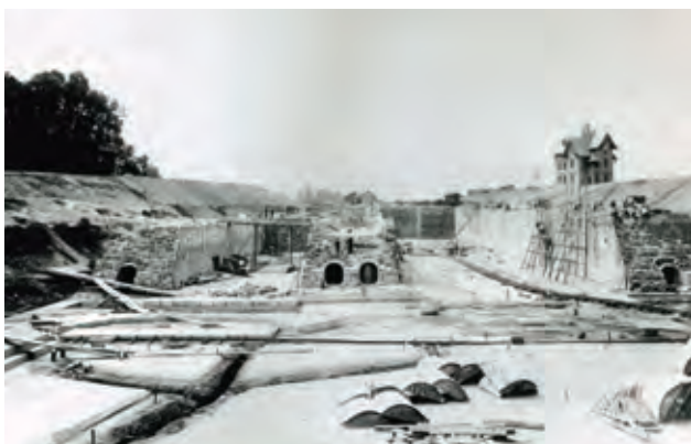
Pohled na stavbu plavebních komor v roce 1904
