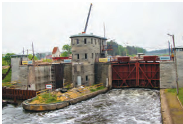
Modernizace Gliwického průplavu
