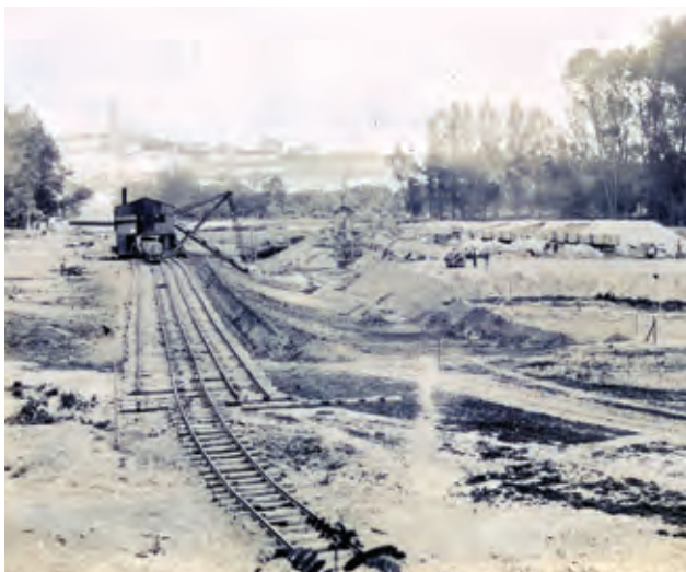
Bagrování dolního plavebního kanálu pod zdymadlem Hořín v roce 1902
