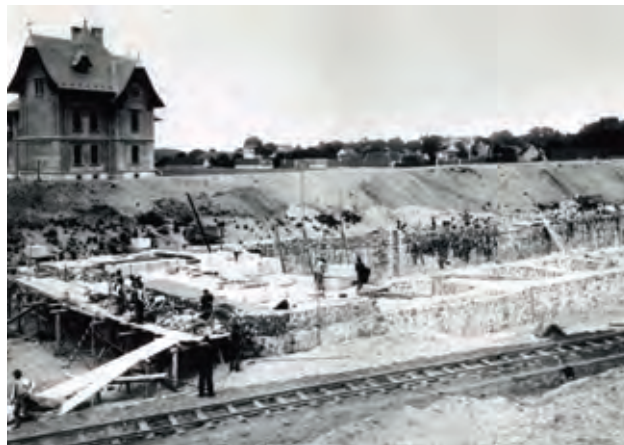
Pohled na stavbu horního ohlavi plavebních komor v roce 1904
