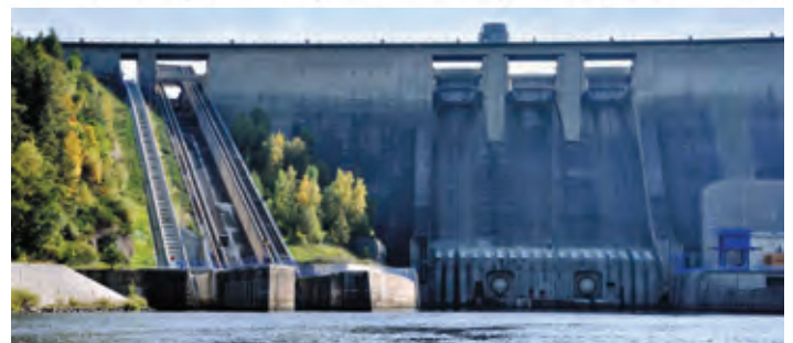
Pohled na sportovní lodní výtah (vlevo) a kolejovou dráhu velkého lodního zdvihadla o nosnosti 300 tun na přehradě Orlík. Autor: Emil Trokšiar
