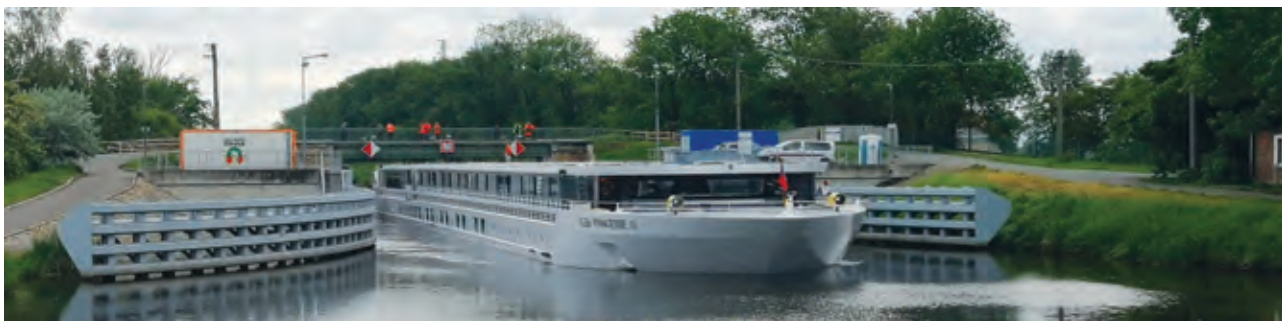
Most ve Vraňanech – příště již lodě nebudou muset demontovat nástavby – most se před nimi zdvihne
