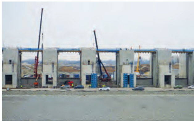
Práce na stavbě poldru Raciborz Dolny na Odře
