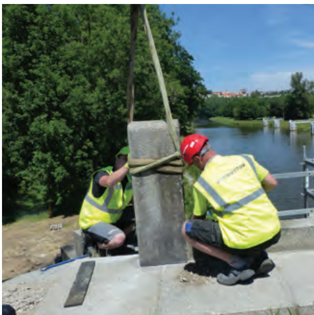
Pracovníci firmy METROSTAV začali rozebírat kamenné části plavební komory Hořín
