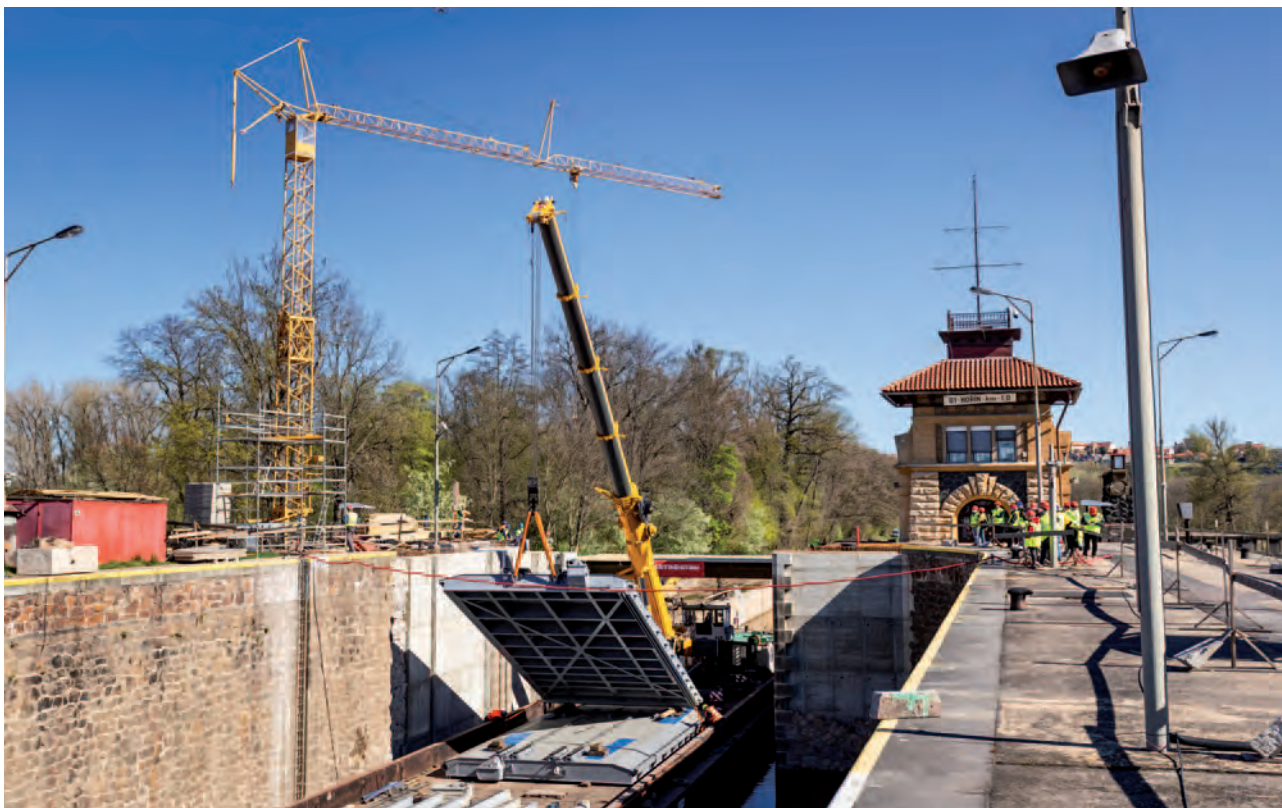
Osazování dvoukřídlých vzpěrných vrat dolního ohlavi velké plavební komory Hořín
