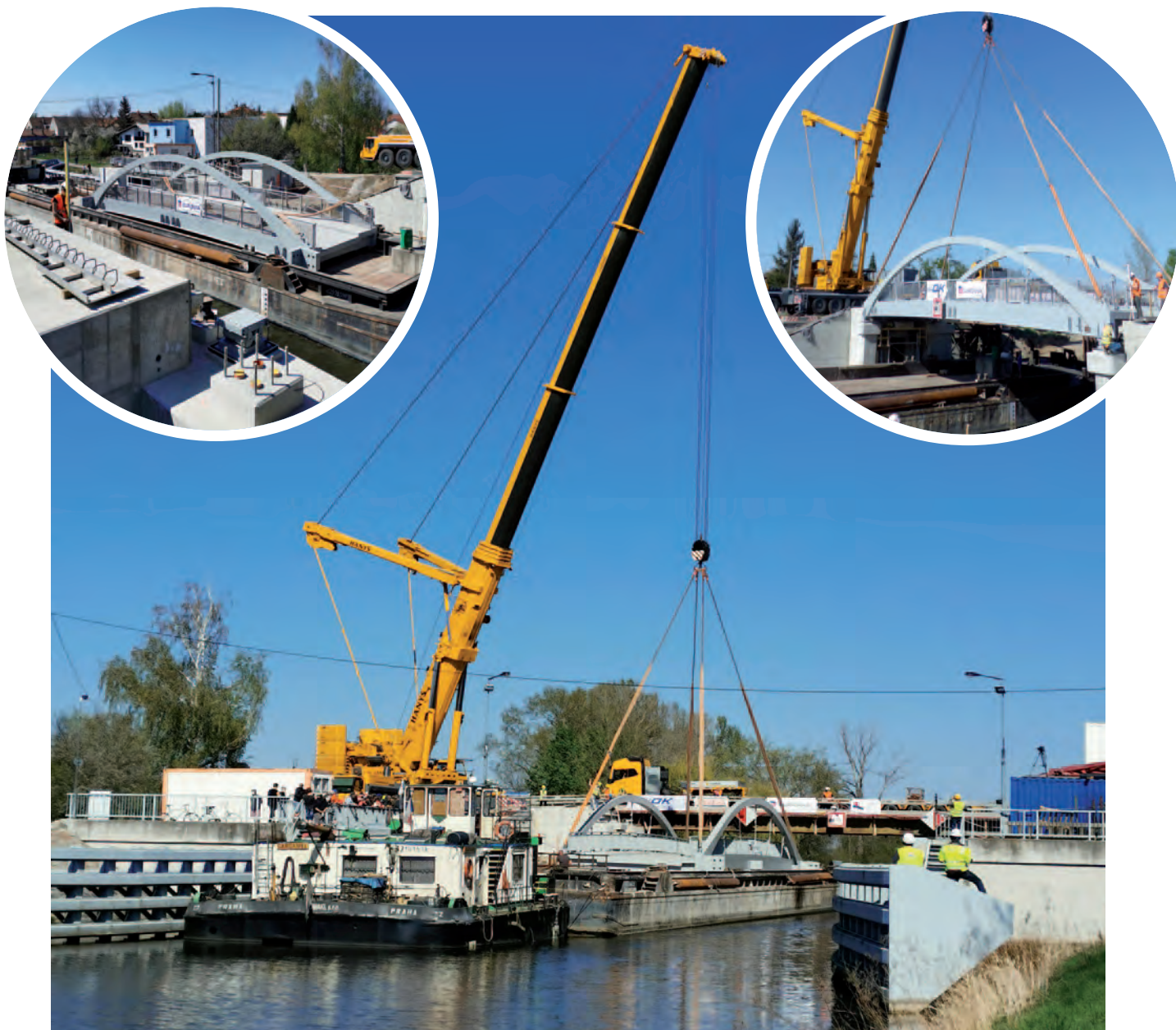
Osazování nosné konstrukce silničního mostu Vraňany 22. dubna 2020
