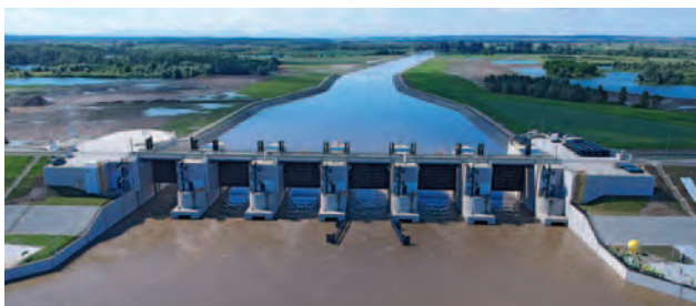
Pohled na výpustní objekt přehradu Ratiboř
