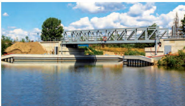
Nový železniční most v Lužci nad Vltavou
