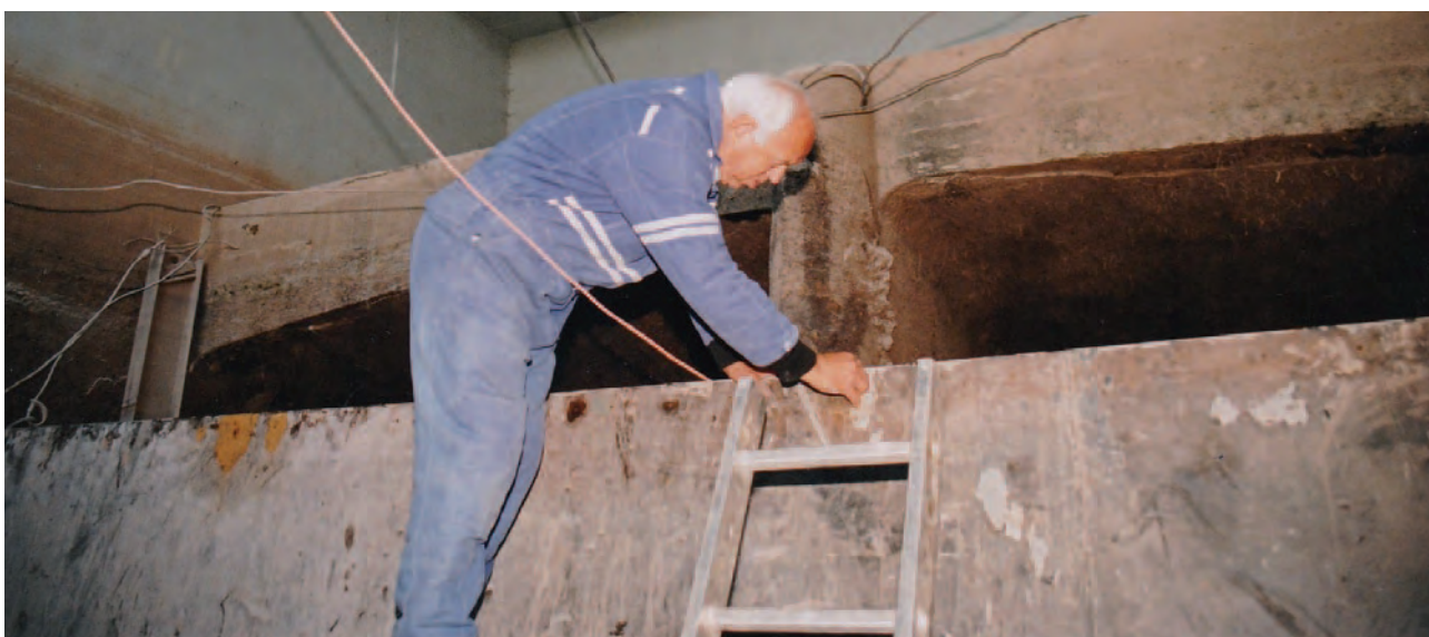
Josef Vaverka v akci při rekonstrukci vodní elektrárny Přelouč
