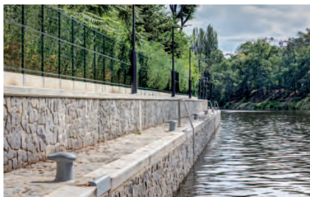
Stěna čekacího stání dolní rejdy plavební komory Štvanice je obložena lomovým kamenem
