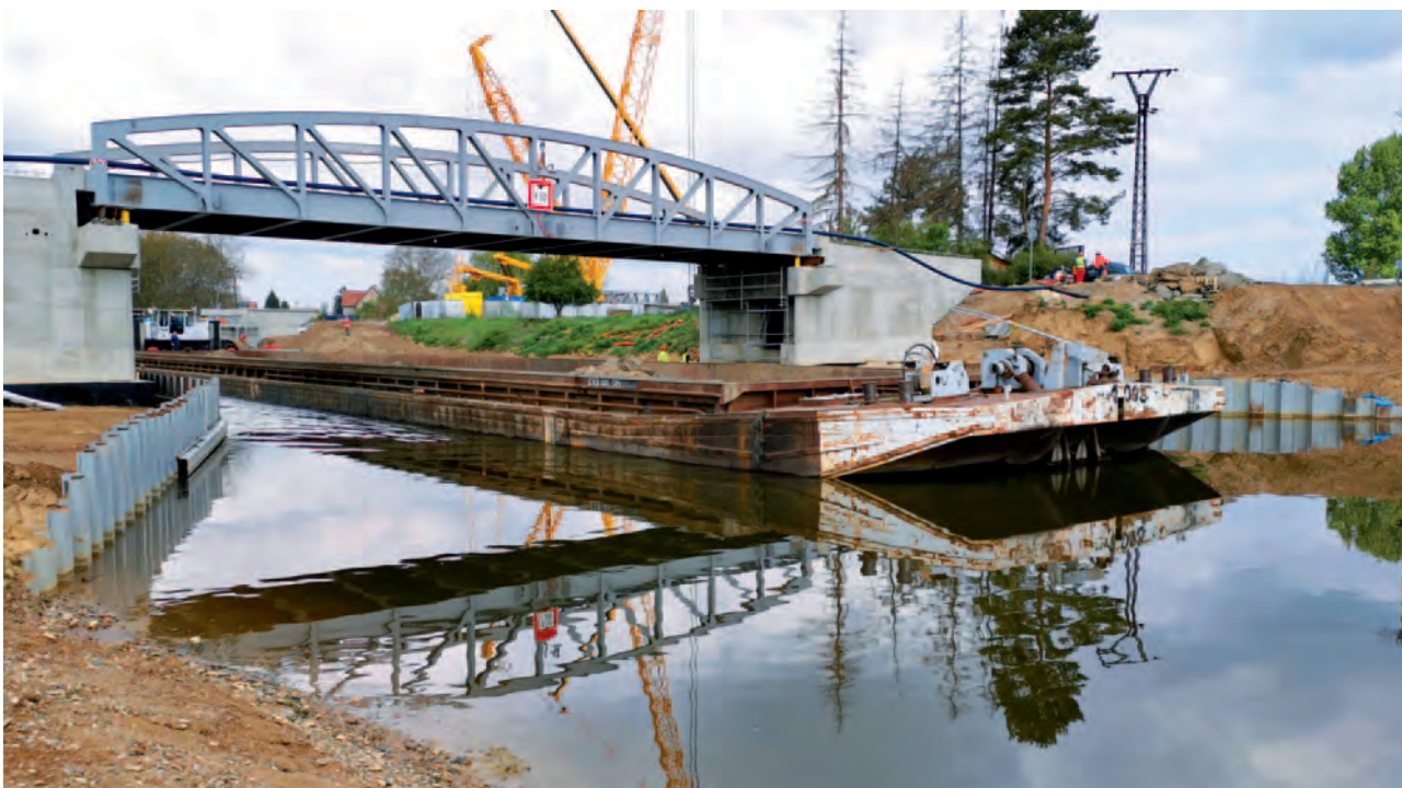
Nový silniční most na místní komunikaci 9. května v Lužci nad Vltavou je již v provozu
