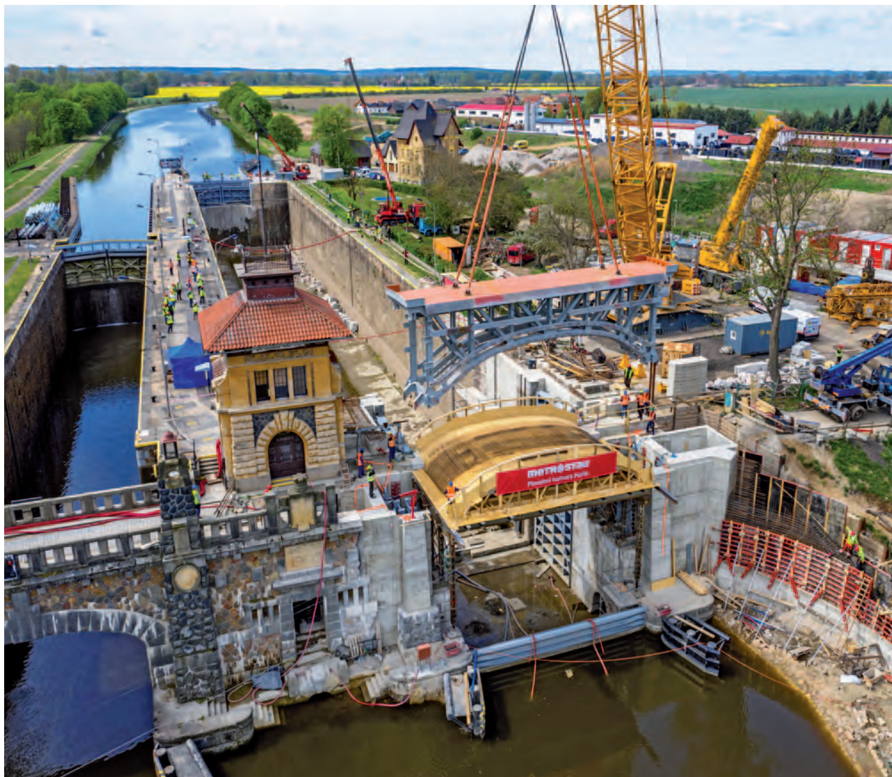
Osazování nové zdvižné mostovky velké plavební komory Hořín
