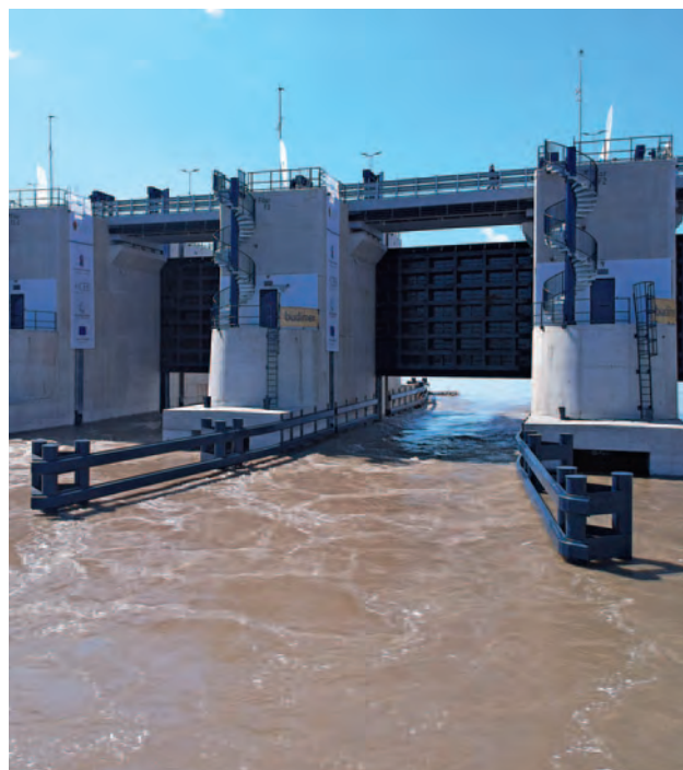
Detail výpustního objektu, který umožňuje i průjezd plavidel do šířky 12 metrů Foto (3x): Tomáš Kolařík
