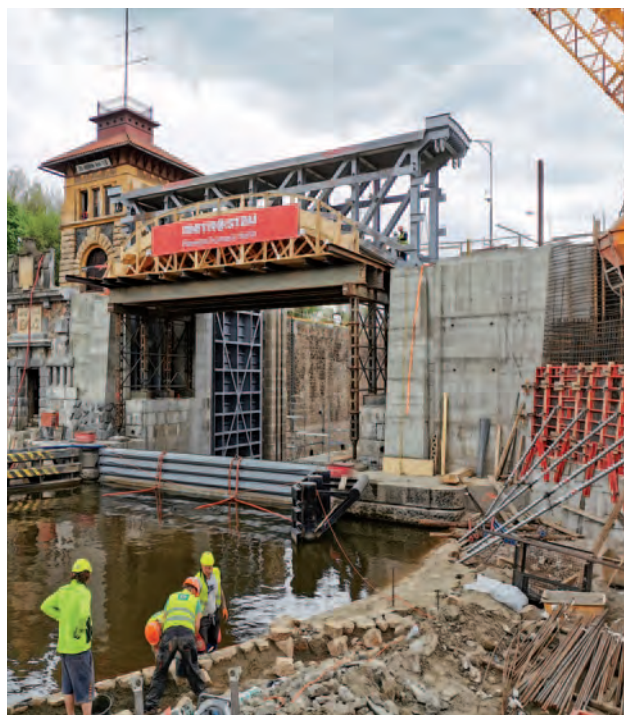
Osazování nové zdvižné mostovky velké plavební komory Hořín při pohledu z dolní vody
