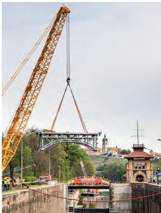
Osazování nové zdvižné mostovky velké plavební komory Hořín největším mobilním jeřábem v Česku
