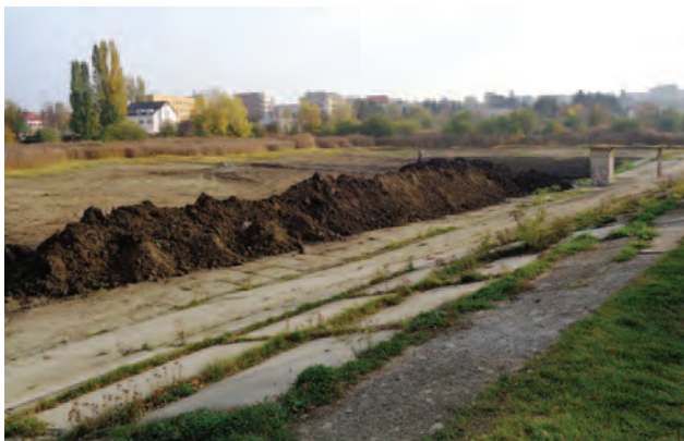
Obnova rybníku "Dolejšák" v Praze - Zličíně. Celková plocha 1,8 ha. Při čisticích pracích bylo vytěženo kolem 13000 m.cub. sedimentů. To znamená, že na 1 m*2 se v průměru usadilo kolem 720 kg bahna. ( 13000/18000=0,722 ) Za předpokladu, že spec. váha sedimentu se bude pohybovat kolem sp.váhy písku (cca 2 gr/cm*3) je výsledek 720/2 asi 360 dm*3. To znamená, že průměrná výška sedimentů se pohybovala mezi 30-40 cm.
