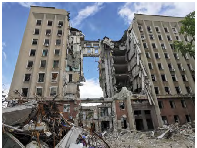
Zničená budova oblastní správy v centru Mikolajevu
