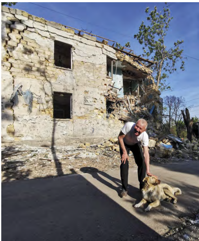
Zničené bytovky v přístavní zóně města Mykolajiv
