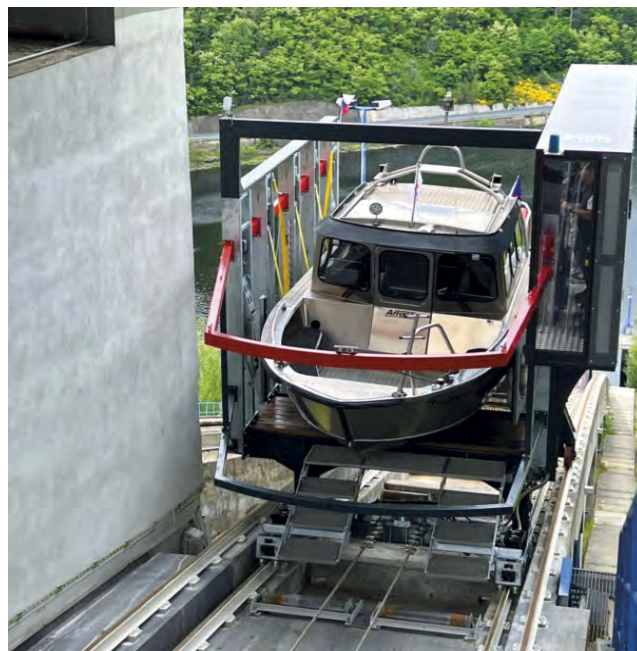
Přeprava plavidla lodním výtahem
