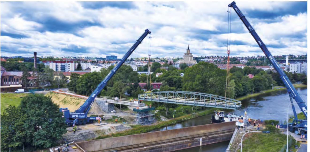
Osazování repliky mostu bývalé polní dráhy přes plavební kanál Troja-Podbaba, který připlul do Prahy po Vltavské vodní cestě
