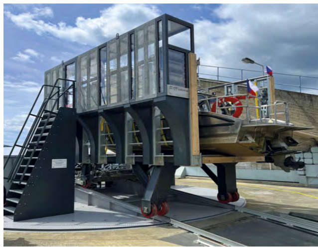
Výtah na točně při startu ostrého provozu 27. května 2022 foto M. Stašek, Metrostav a.s.
