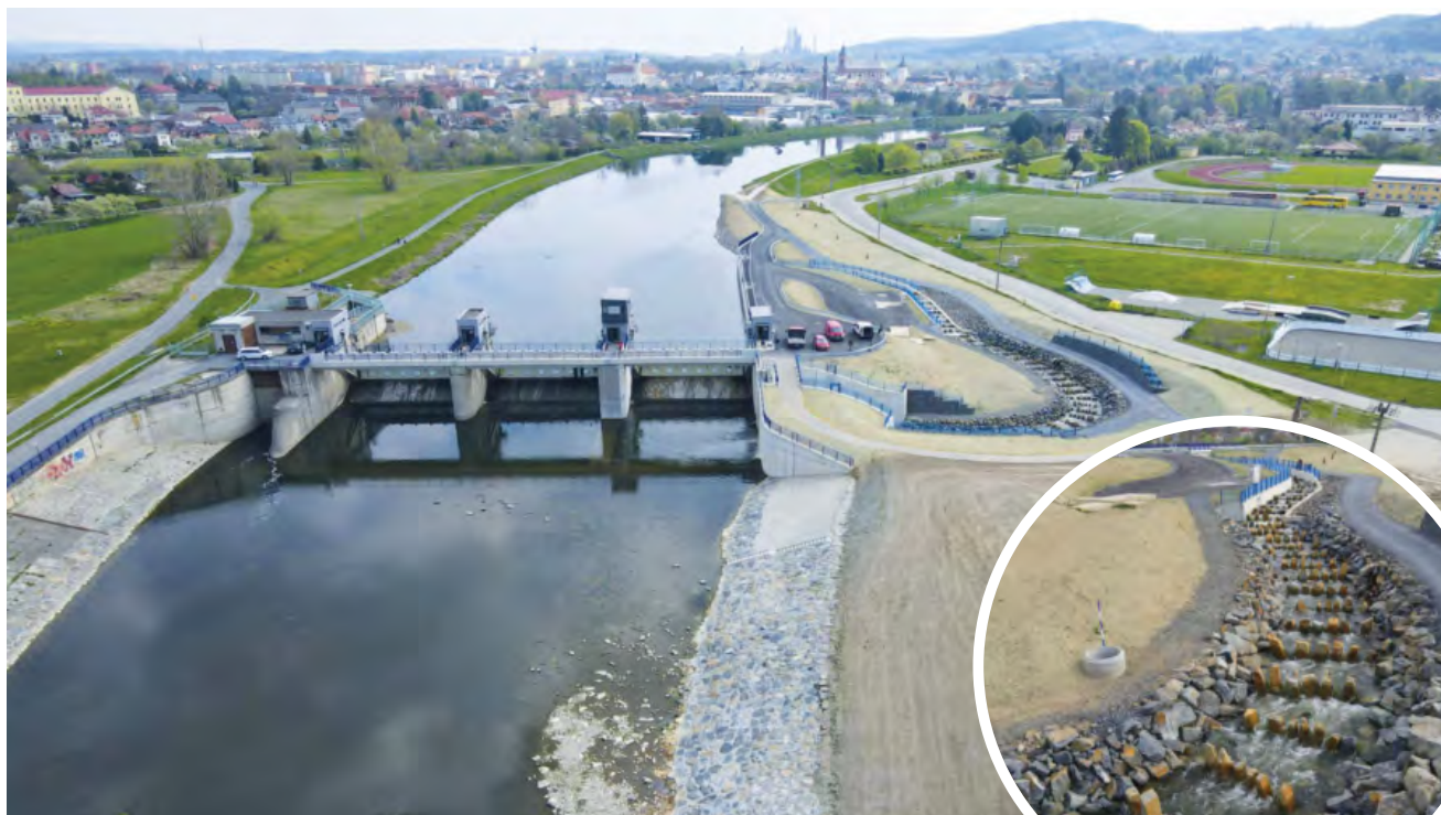
Celkový pohled na jez po dokončení
