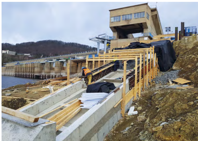
Nový dvojitý betonový U profil v části prodloužení kolejové dráhy do nádržního prostoru foto Metrostav a.s.
