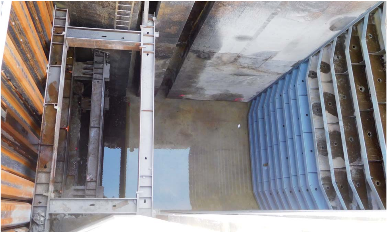
Finální osazení provizorního hrazení plavební komory
