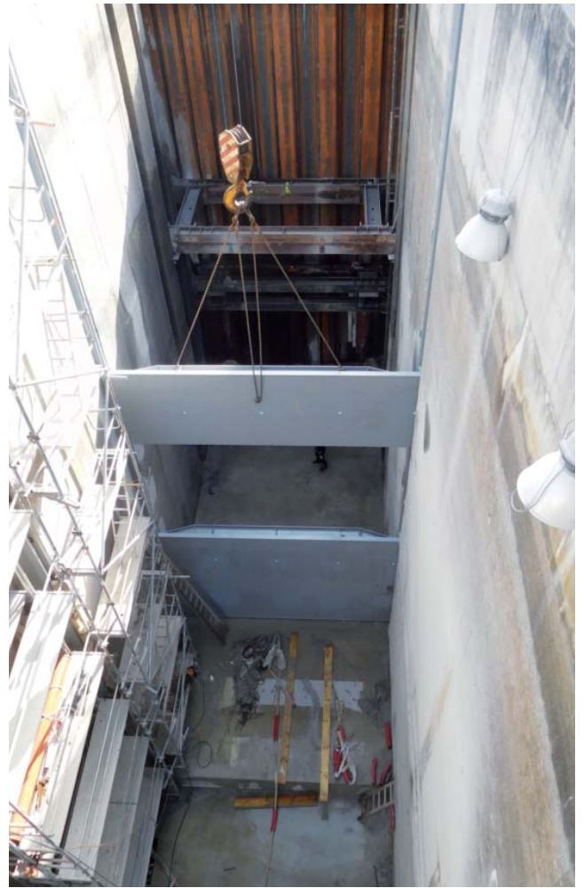
Osazení provizorního hrazení plavební komory
