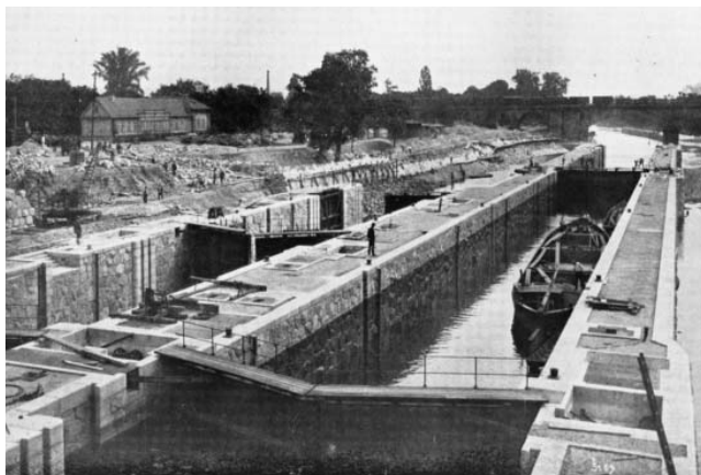
Plavební komory a stavba nábrežní zdi u Štvanice v Praze (17.6. 1911)
