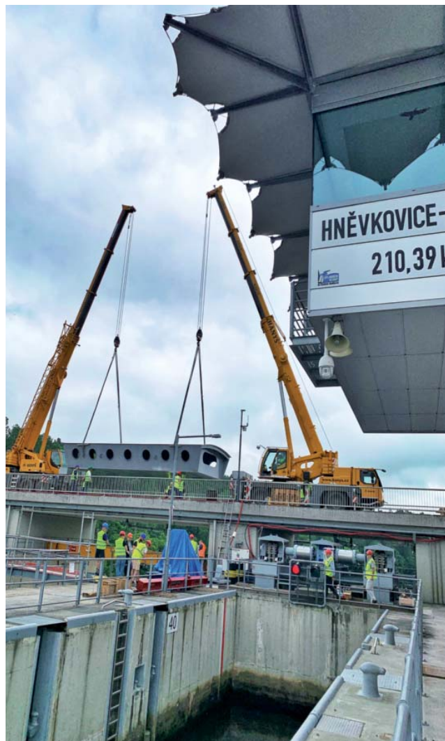
Osazování středního dílu segmentu
