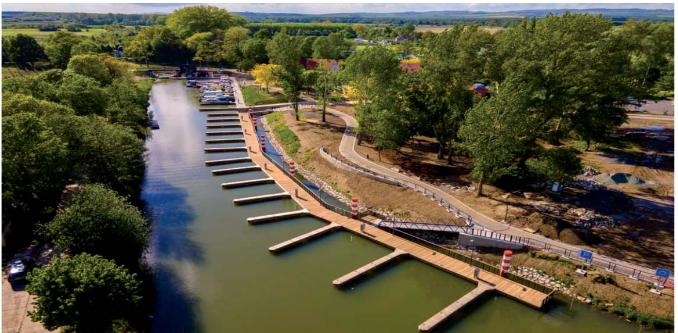
Modernizovaný přístav Veselí nad Moravou
