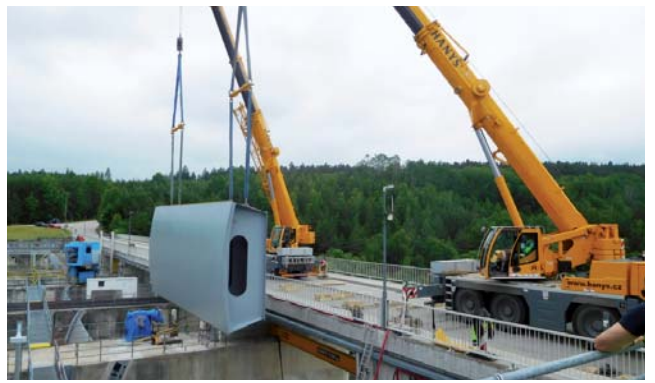
Osazování středního dílu segmentu
