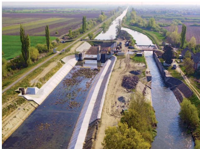
Celkový pohled na rekonstrukci jezu a plavební komory Sânmihaiu Român
