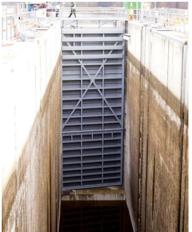
Finální osazení horních vrat plavební komory
