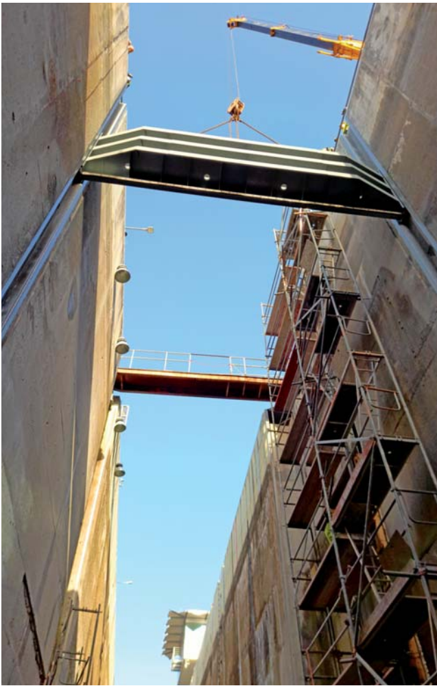
Osazení provizorního hrazení plavební komory
