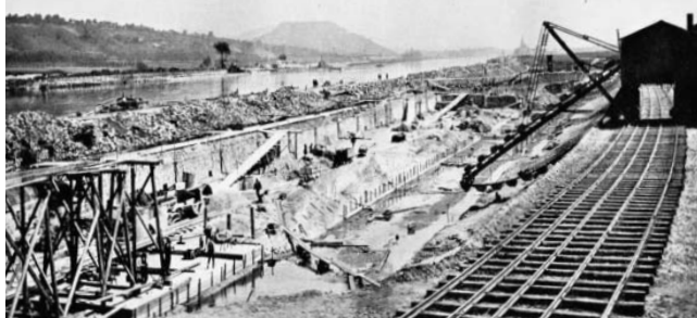
Stavba plavebních komor zdymadla č. IX u Litoměřic v Českých Kopis- tech dle stavu dne 3. srpna 1910
