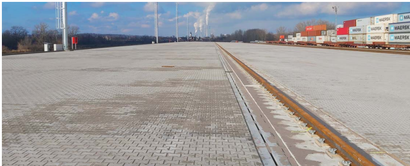
Celková plocha 3 stavby činila více než 26 tis. m 2 s finálním povrchem ze zámkové dlažby
