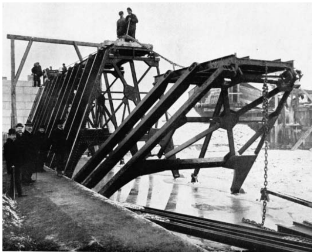
Sklápění slupicových elementů stavidlového jezu patent Schwarzer u Li- toměřic (30.1. 1912)
