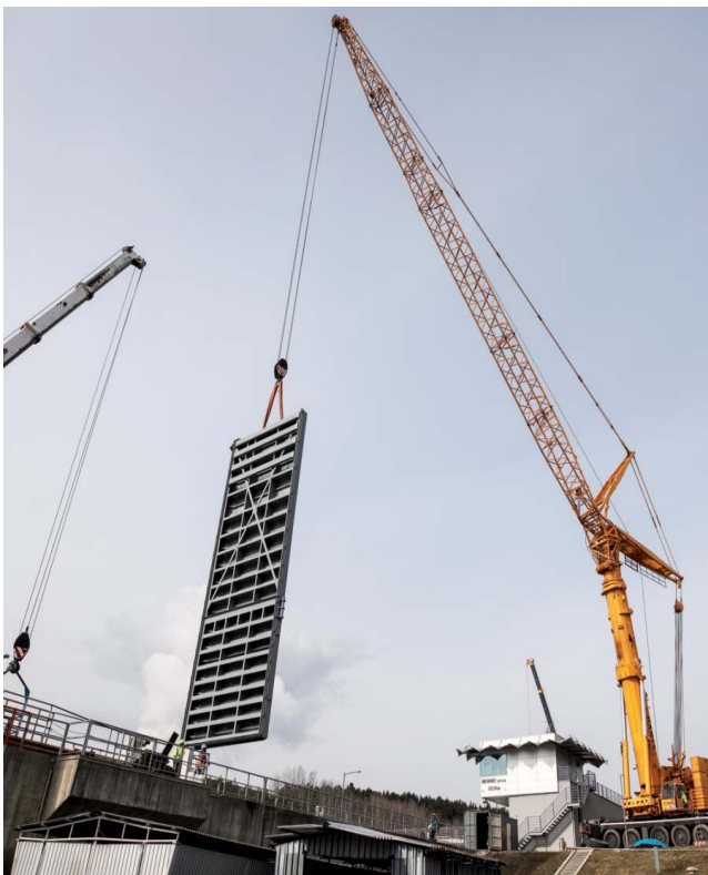
Montáž horních vrat plavební komory
