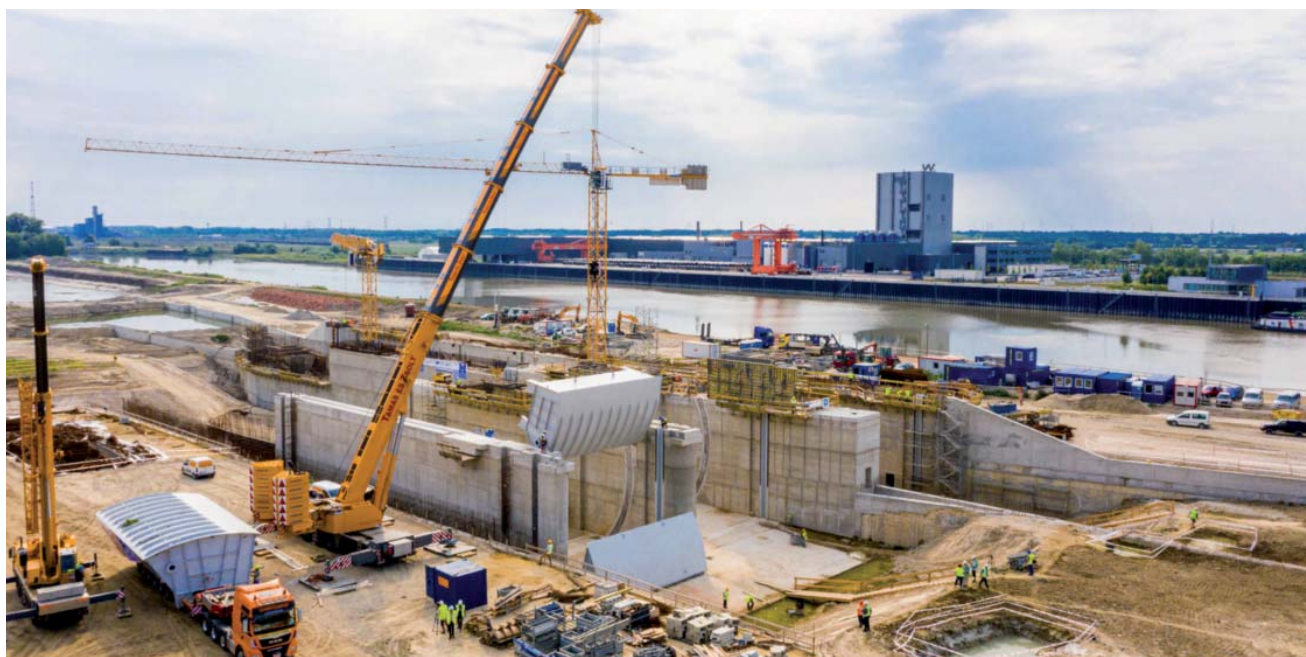
Stavba nového jezu a plavební komory na Mošonském Dunaji u přístavu Győr-Gönyű
