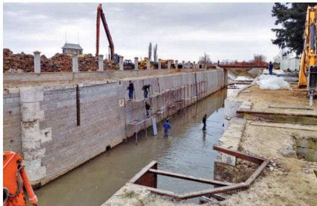
Rekonstrukce plavební komory Sânmihaiu Român
