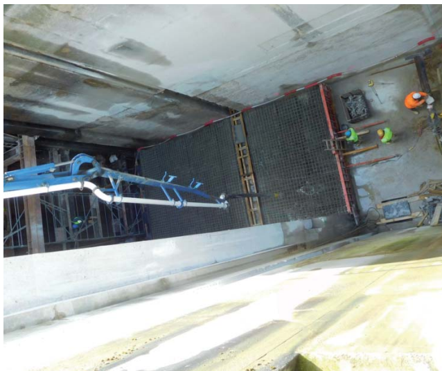
Betonáž dna horního záporníku plavební komory
