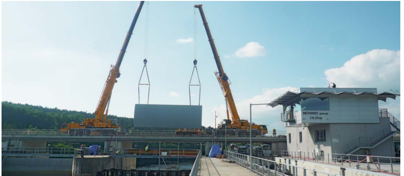
Montáž středního dílu segmentu
