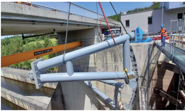
Montáž ramene segmentu
