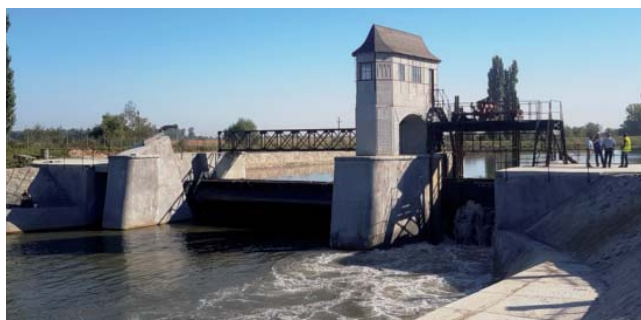
Jez s plavební komorou Sânmihaiu Român před a po rekonstrukci
