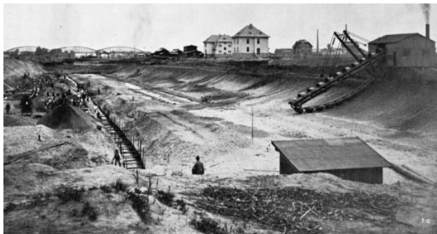
Stavební jáma pro plavidla u Lovosic dle stavu (22.5. 1912)
