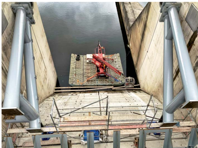
Montáž ramen segmentu
