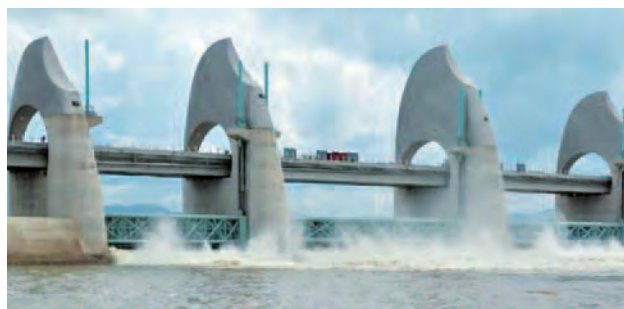
Jez Seungchon na řece Yeongsan s otevřenými jezovými poli pro průchod velké vody a pro převádění sedimentů
