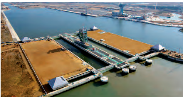
Letecký pohled na terminál Incheon a vstupní plavební komory na průplavu
