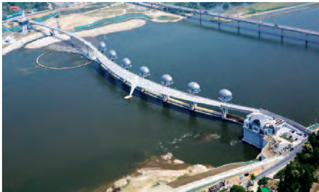
Jez Ipo na řece Han s malou vodní elektrárnou (vpravo dole)
