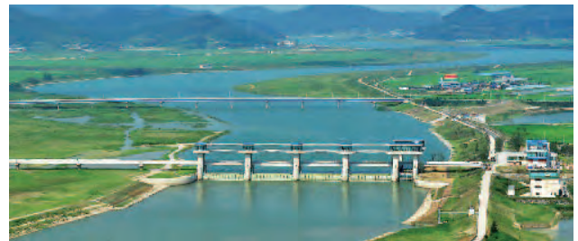
Součástí jezu Juksan na řece Yeongsan je i plavební komora pro rekreační plavbu (na obrázku vpravo)
