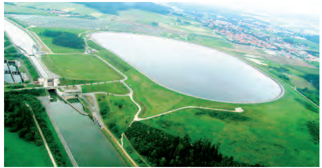
Plavební stupně sestupující z vrcholové zdrže k Dunaji jsou vybaveny čerpacími stanicemi, které zásobují vodou z Dunaje regiony v severním Bavorsku. Na obr. stupeň Bachhausen s vyrovnávacími nádržemi a nádrží pro vrcholovou zdrž
