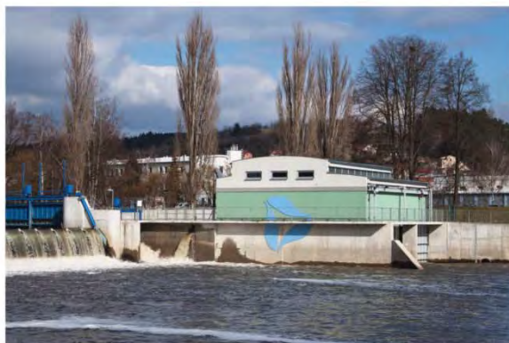
14 Malá vodní elektrárna Beroun, 2011
