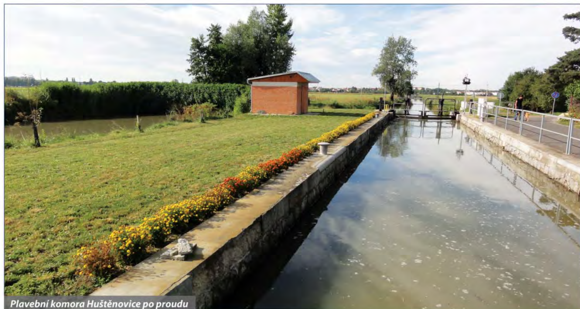
Plavební komora Huštěnovice po proudu
