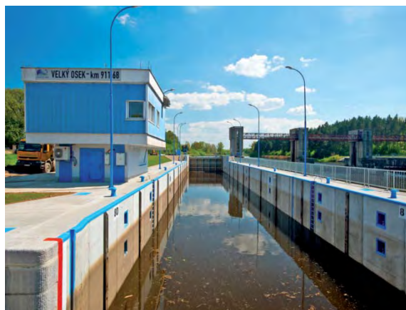
Plavební komora Velký Osek po modernizaci
