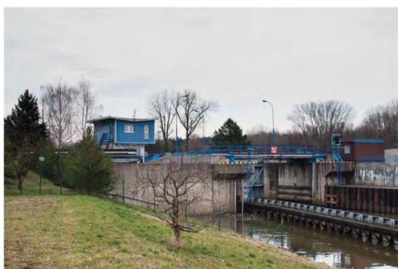
9 Plavební komora Hradištko 1975
