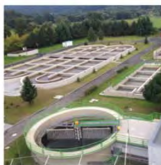
Kanalizace a čistírna odpadních vod, Ústí nad Orlicí
