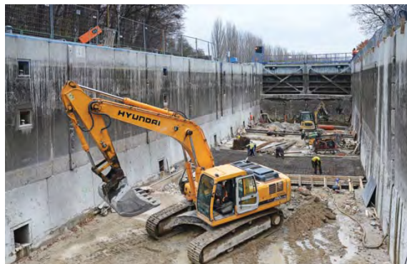
Plavební komora Brandýs nad Labem prošla náročnou rekonstrukcí, především sanací dna
