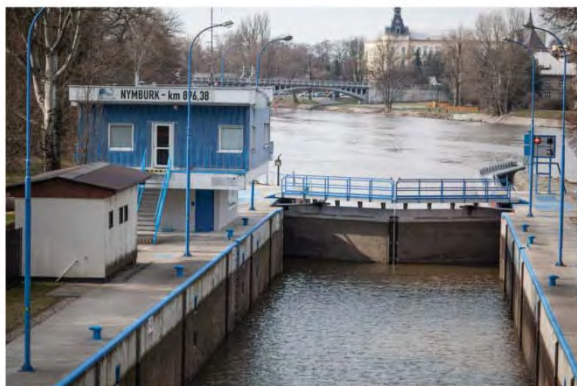
10 Plavební komora Nymburk, 1975
