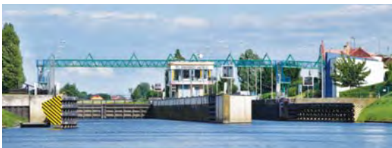
Plavební komory České Kopisty
