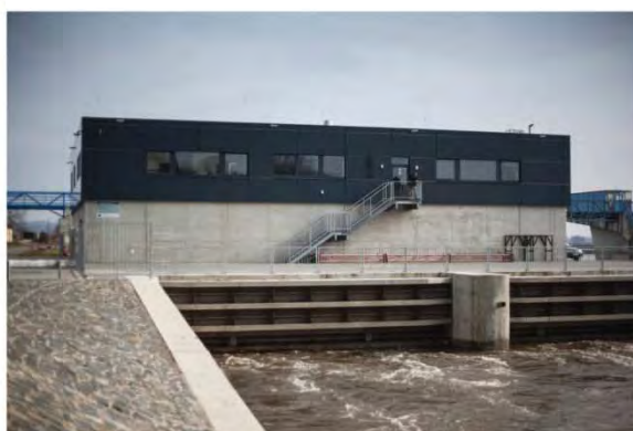
13 Malá vodní elektrárna Štětí, 2015
