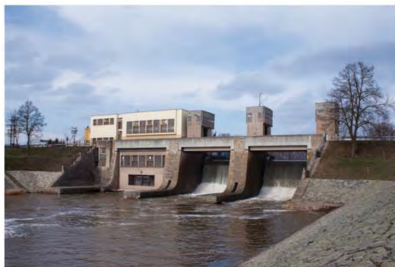
4 Jez a vodní elektrárna Předměříce, 1942–1947, arch. Josef Štěpánek
