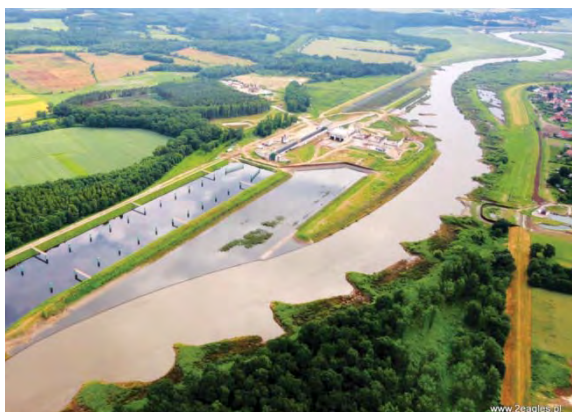
Výstavba plavebního stupně Malczyce trvá již bezmála 20 let
