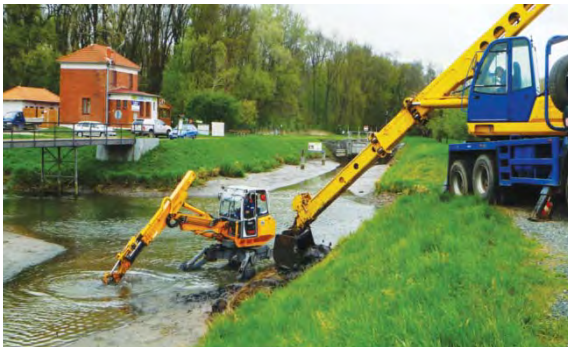
Těžení nánosů z řeky Veličky u plavebních komor Strážnice
