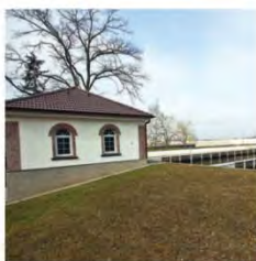
Doplnění technologie v úpravě vody, Plav
