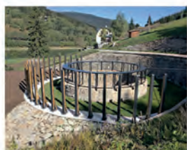
Zvýšení retenční funkce rekonstrukcí spodních výpustí v obtokovém kanálu vodního díla Labská
