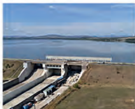
Rekonstrukce krajních polí bezpečnostního přelivu vodního díla Nechranice
