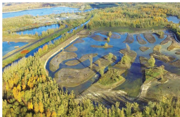
V předstihu byly zahájeny práce na výstavbě nových vodních biotopů podél vodní cesty
