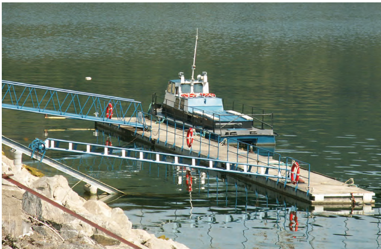
Prvé plávajúce prístavacie mólo so železobetónovými pontónmi na VD Liptovská Mara
