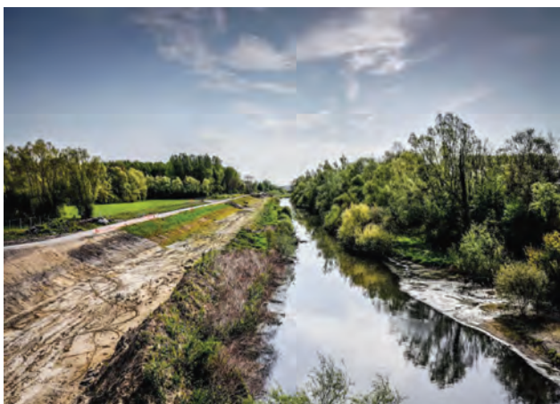
Práce na obnově vodní cesty
