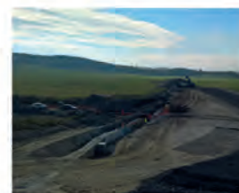
Výstavba suché nádrže na Krčelském potoce, Višňová Vlka
