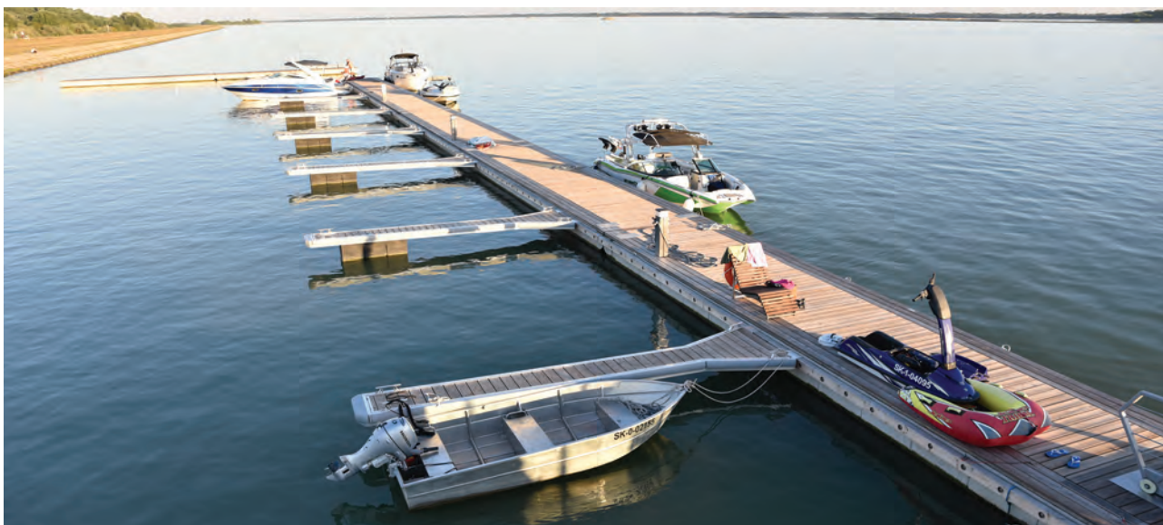
Príklad kotvenia pod vodnou hladinou – Marina Hamuliakovo, rieka Dunaj - Zdrž Hrušov
