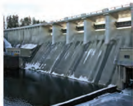
Rekonstrukce koruny a oprava návodního lince vodního díla Kružberk
