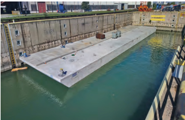
Pontón 51,0 x 12,4 x 2,7 m pre plávajúcu reštauráciu, rieka Dunaj, Bratislava
