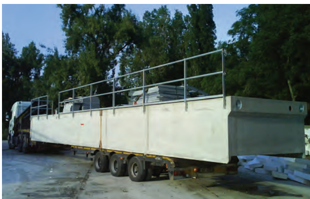
Transport jedného z pontónov pre servisné stánie v Uherskom Hradišti
