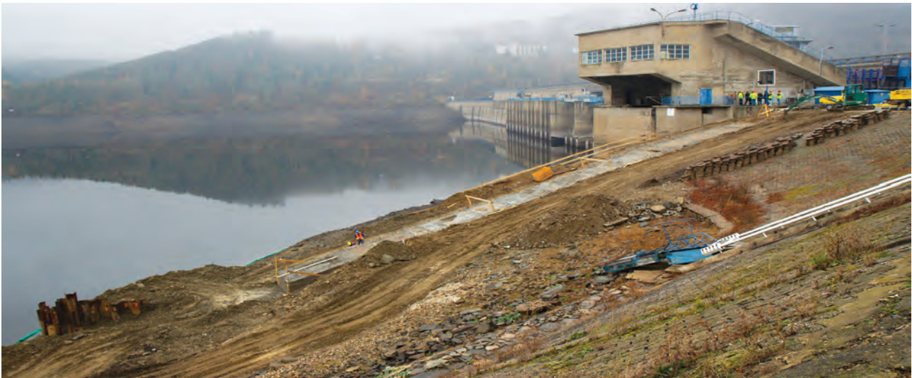
Práce na modernizaci sportovního lodního výtahu byly zahájeny
