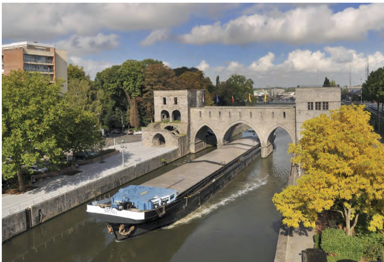
Most byl po válce obnoven, ale jeho středový oblouk se stal pro současnou plavbu příliš nízkým
