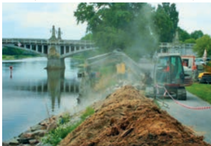
Zahájení prací na novém přístavišti v Nymburce
