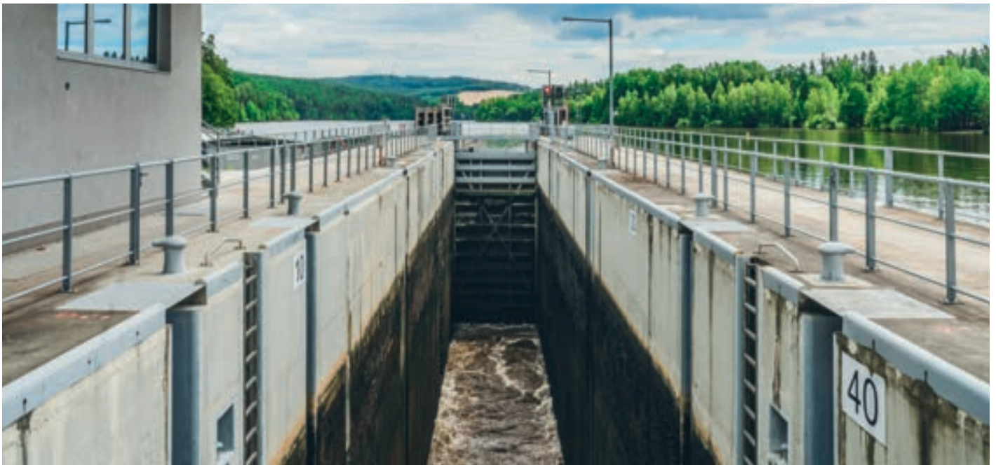
Vypuštěná plavební komora situovaná u pravého břehu. Její maximální spád je 19 m a je tak druhou nejhlubší komorou v České republice. Zdroj: Metrostav a.s.
