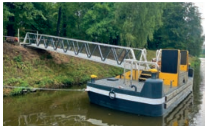
Nově instalované molo v Kolíně (září 2022)
