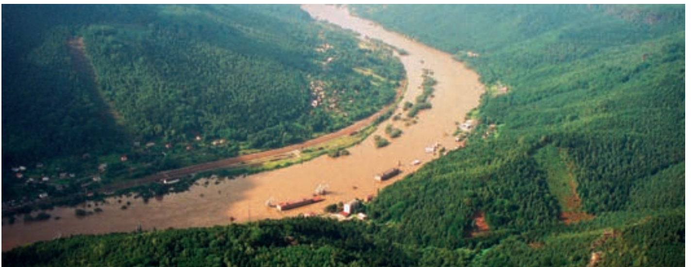
Labský kaňon v Děčíně – Loubí plný vody během srpnových povodní 2002
