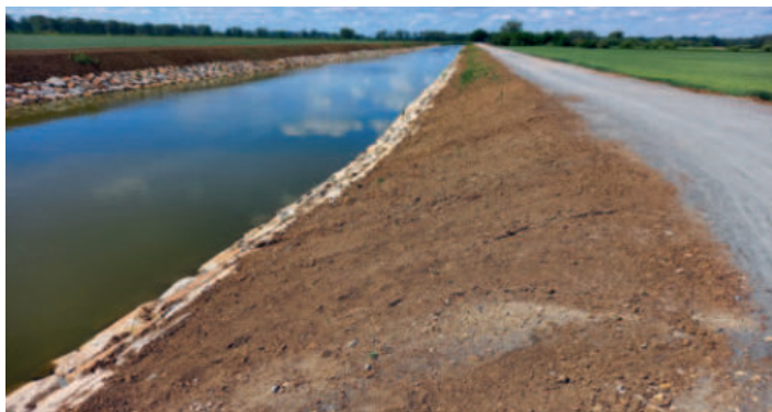
Oprava opevnění - dokončený úsek Výklopník - Jez Sudoměřice
