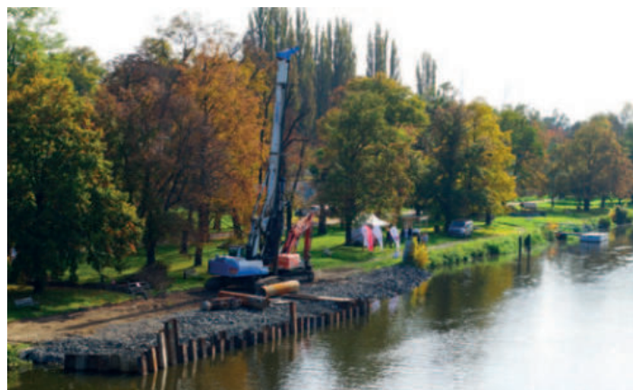
Práce na stavbě přístaviště Štětí
