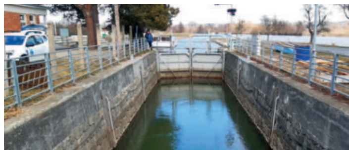
Plavební komora Spytihněv
