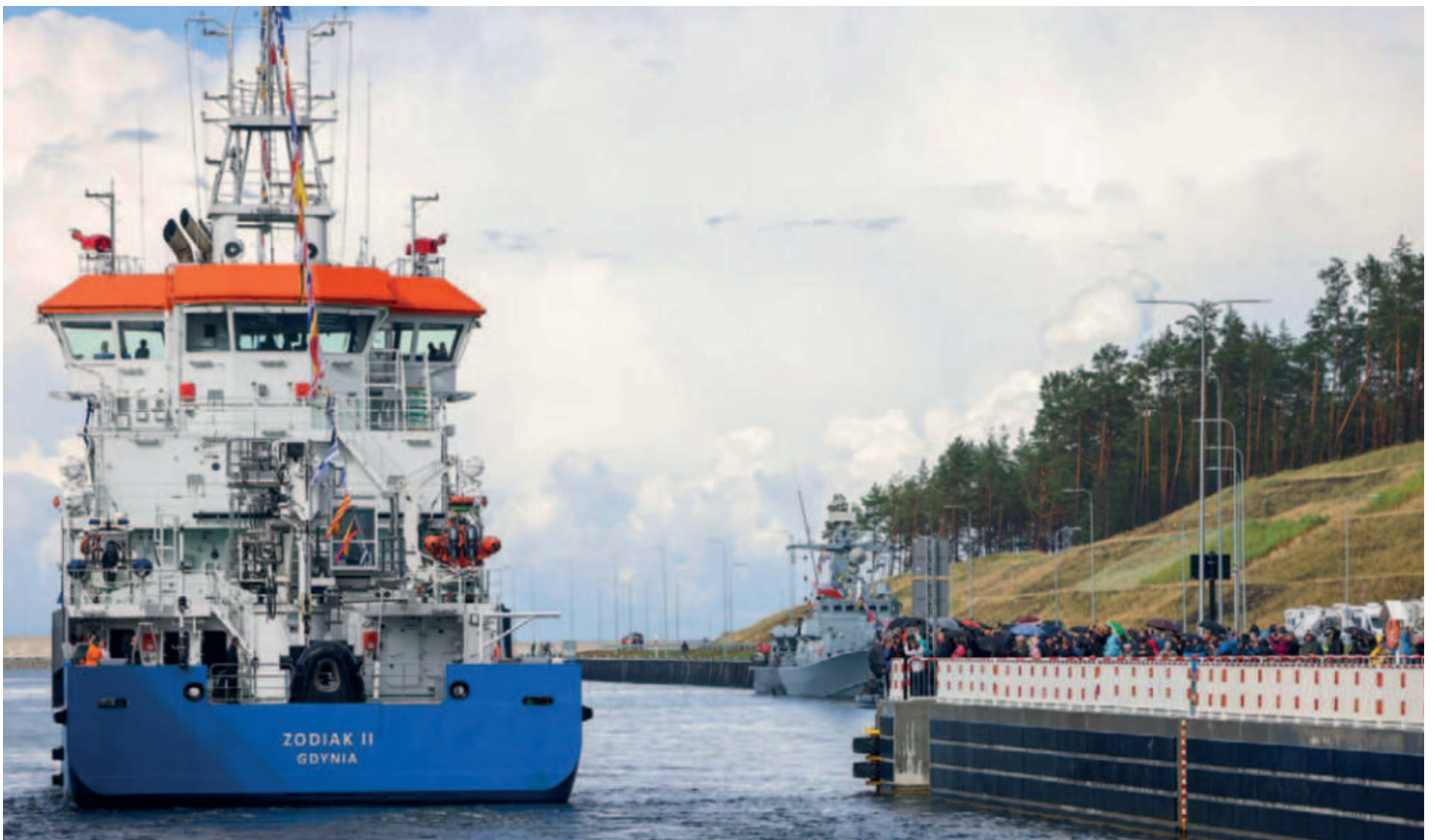
Lidé pozorují první loď proplouvající plavební komorou nového průplavu
