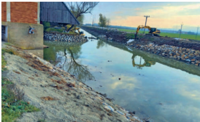
Oprava opevnění - práce na kanálu u Vyklopníku
