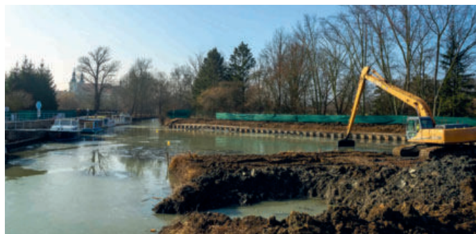
Stavební práce na rozšíření přístaviště Strážnice
