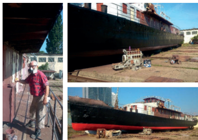
Oprava remorkéru Šturec
