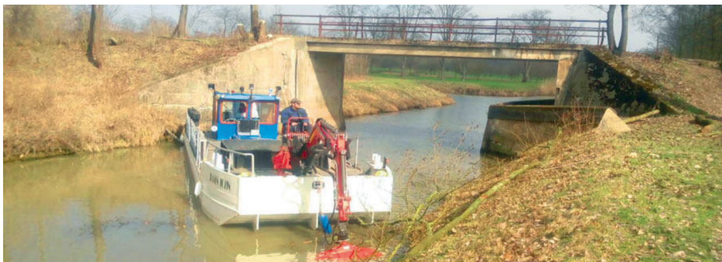
Obslužné plavidlo Jožin čistí před plavební sezónou koryto Baťova kanálu
