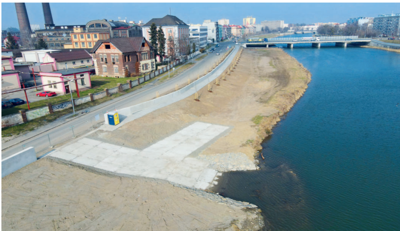
Pohled na část dokončené zdi na objektu SO 03.1 - ochrannou stěnu mezi mosty včetně nového sjezdu do Bečvy sloužícímu pro HZS a Povodí
