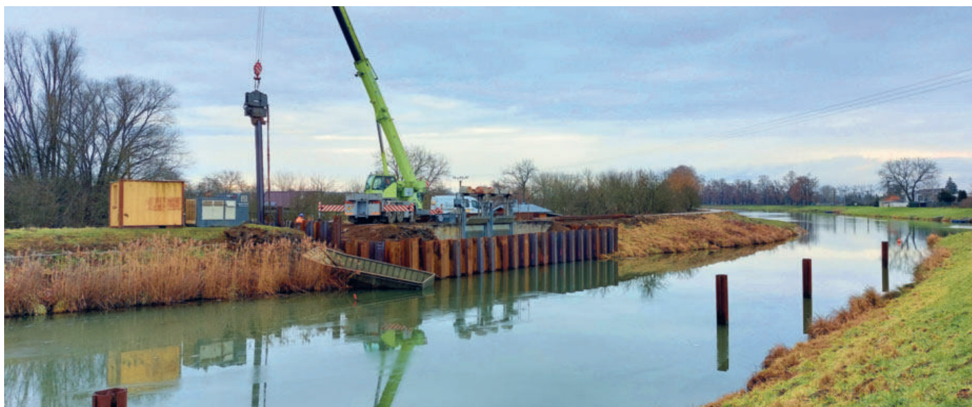
Modernizace nápuštného stavidla Veselí nad Moravou
