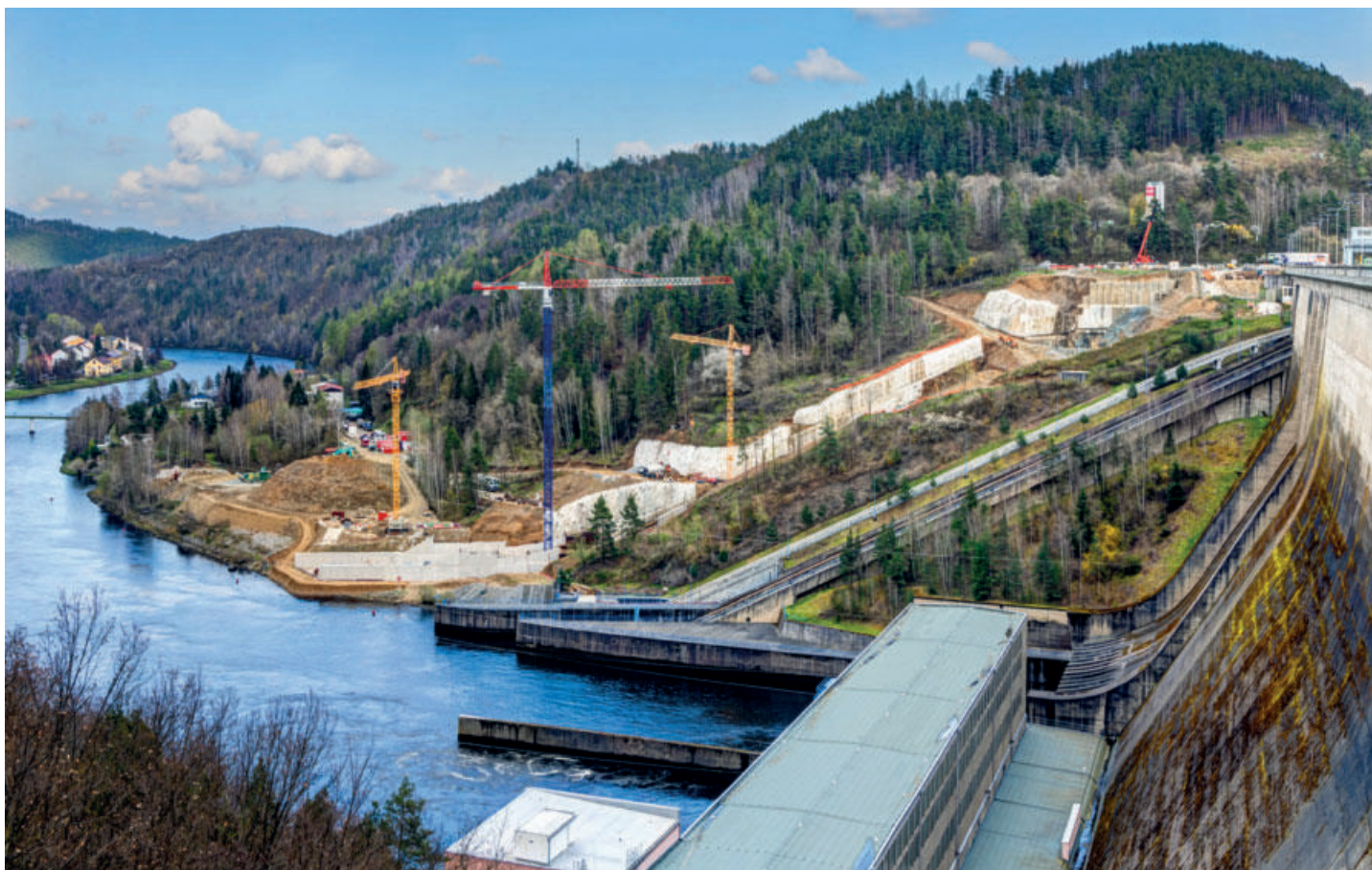
Celkový pohled na vzdušnou stranu hráze
