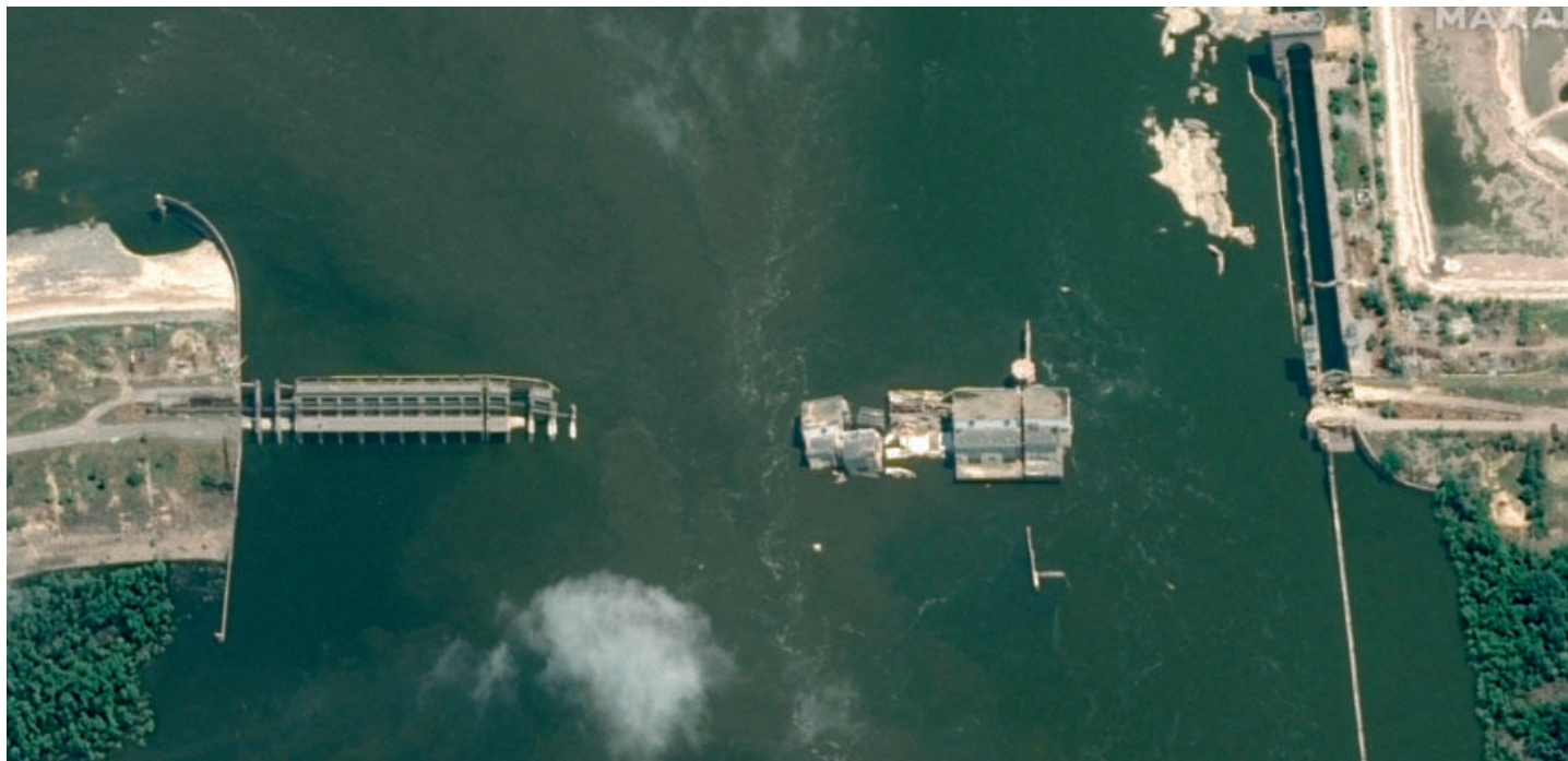
Hráz protržené přehrady Nova Kachovka po opadnutí vody
