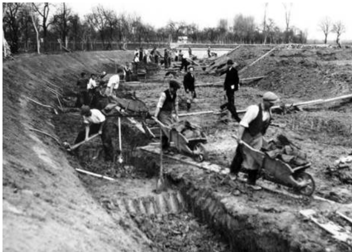
Stavba Baťova kanálu v letech 1934–1938 probíhala především ručně jako prostředek v boji proti vysoké nezaměstnanosti
