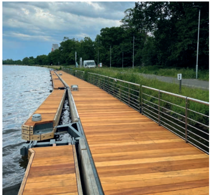
Přístaviště Roudnice nad Labem – sklopení výložníků
