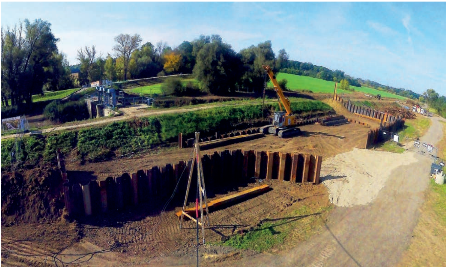
Probíhající stavební práce na plavební komoře Rohatec/Sudoměřice - hrazení stavební jímky (16. října 2023)
