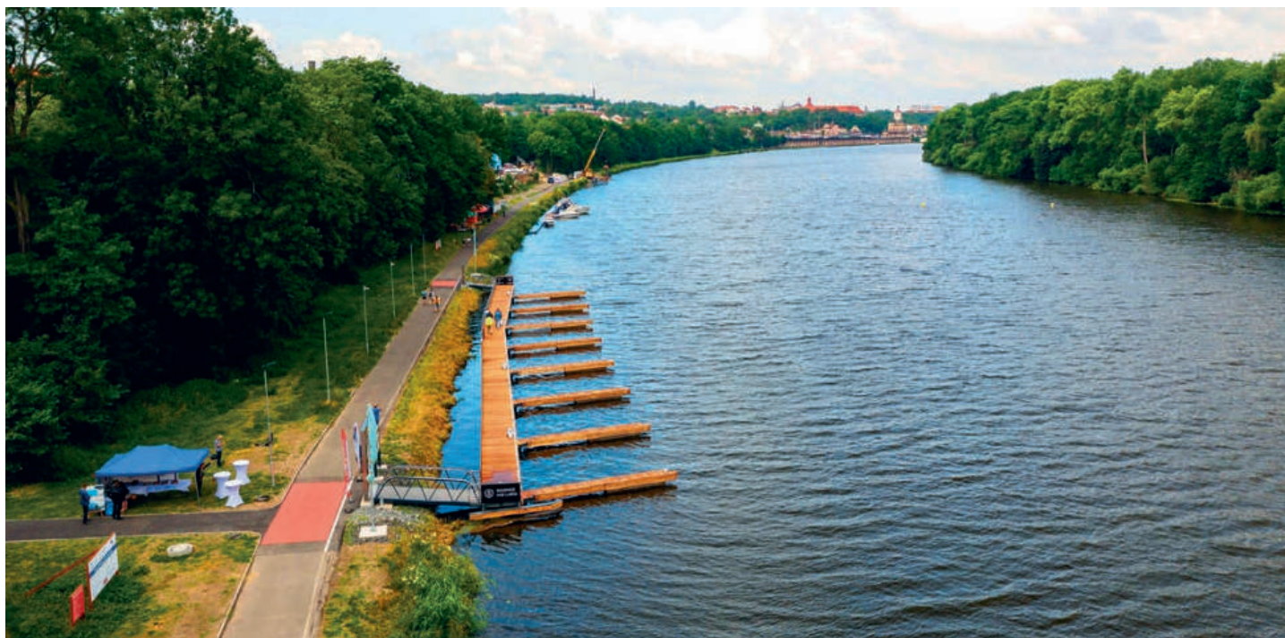
Celkový pohled na přístaviště Roudnice nad Labem
