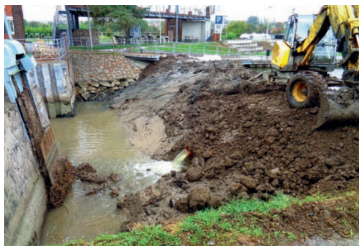
Příprava komplexní opravy plavební komory Spytihněv
