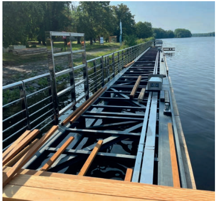
Přístaviště Štětí – nosná ocelová konstrukce
