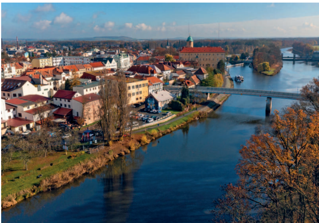
Přístaviště pro rekreační lodě a osobní lodní dopravu vzniknou v samém srdci Poděbrad
