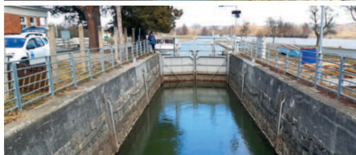
Plavební komora Spytihněv
