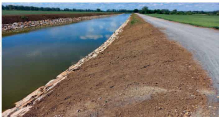
Oprava opevnění - dokončený úsek Výklopník - Jez Sudoměřice
