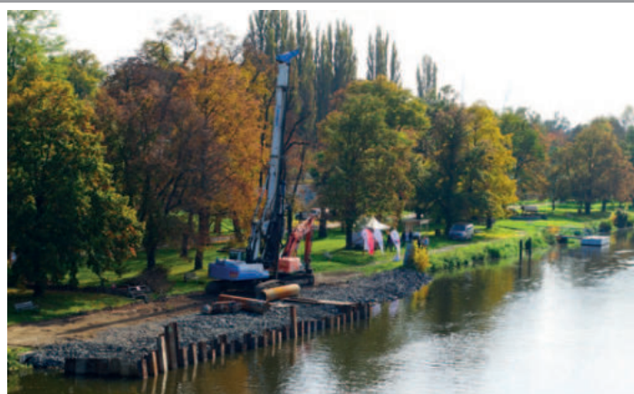
Práce na stavbě přístaviště Štětí
