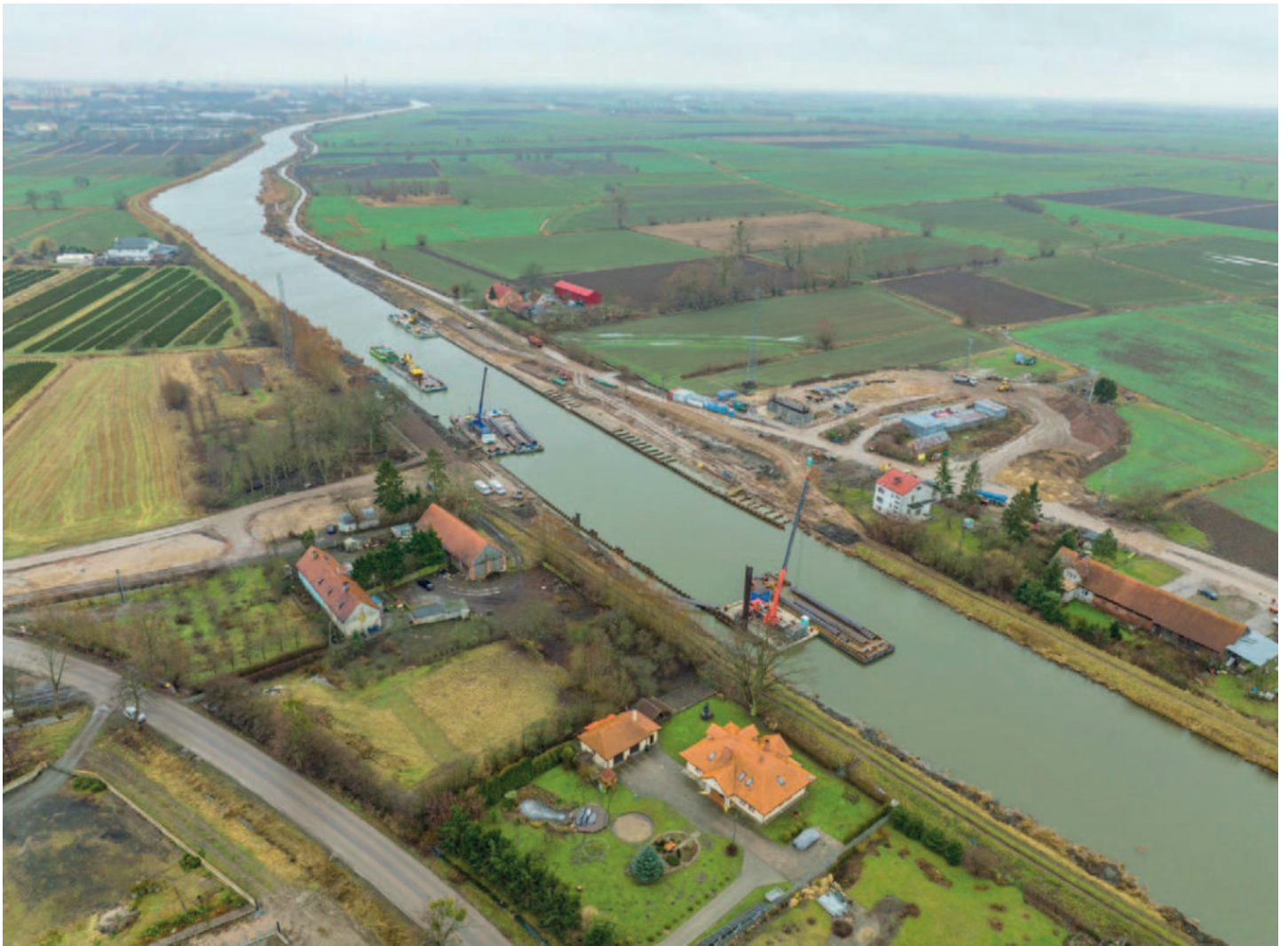
Rozšířování plavební dráhy na řece Elbląg a výstavba otočného silničního mostu Nowakovo
