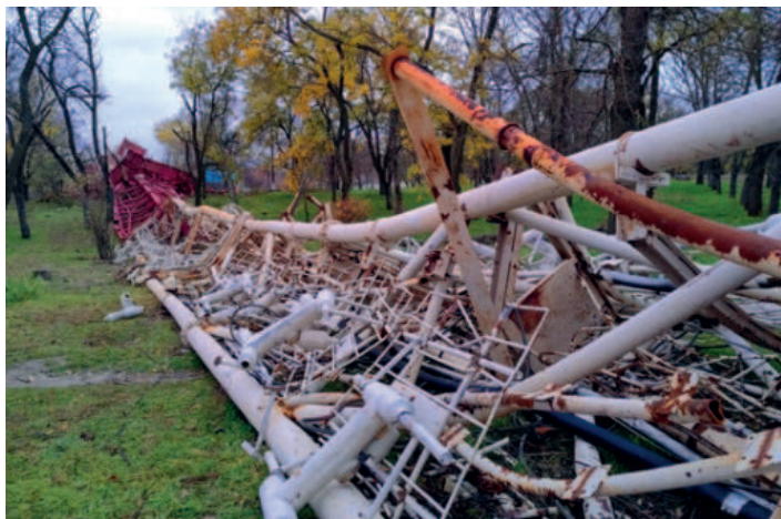
Zničený televizní vysílač v Chersonu
