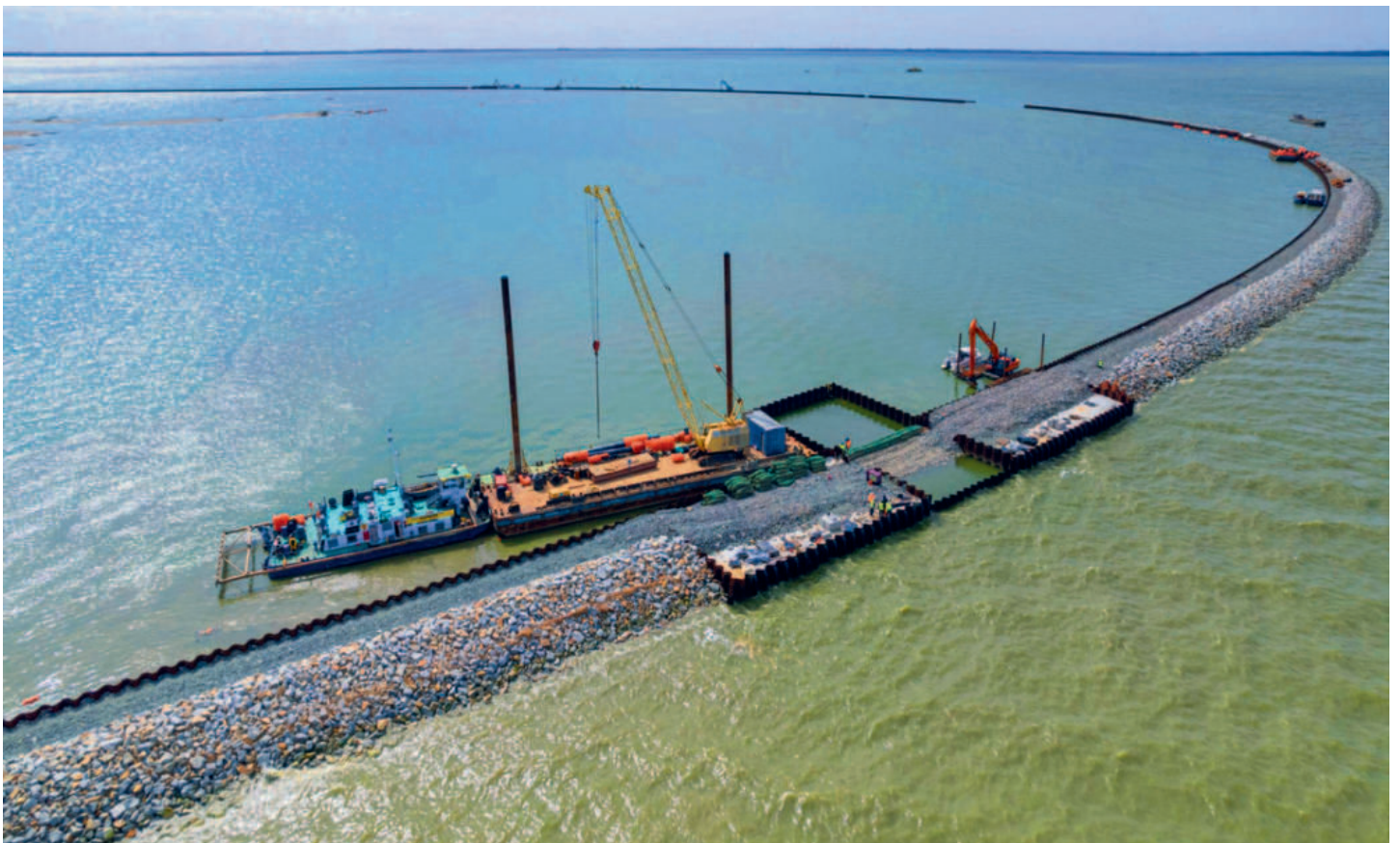
Výstavba nového ptačího ostrova ve Viselské zátocce
