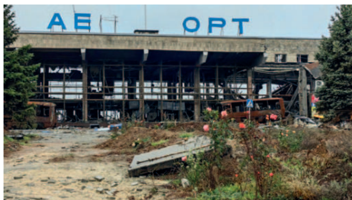
Terminál Chersonského mezinárodního letiště je zcela zničený
