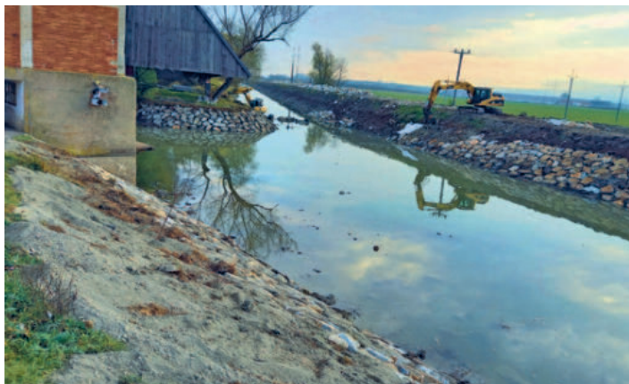
Oprava opevnění - práce na kanálu u Vyklopníku
