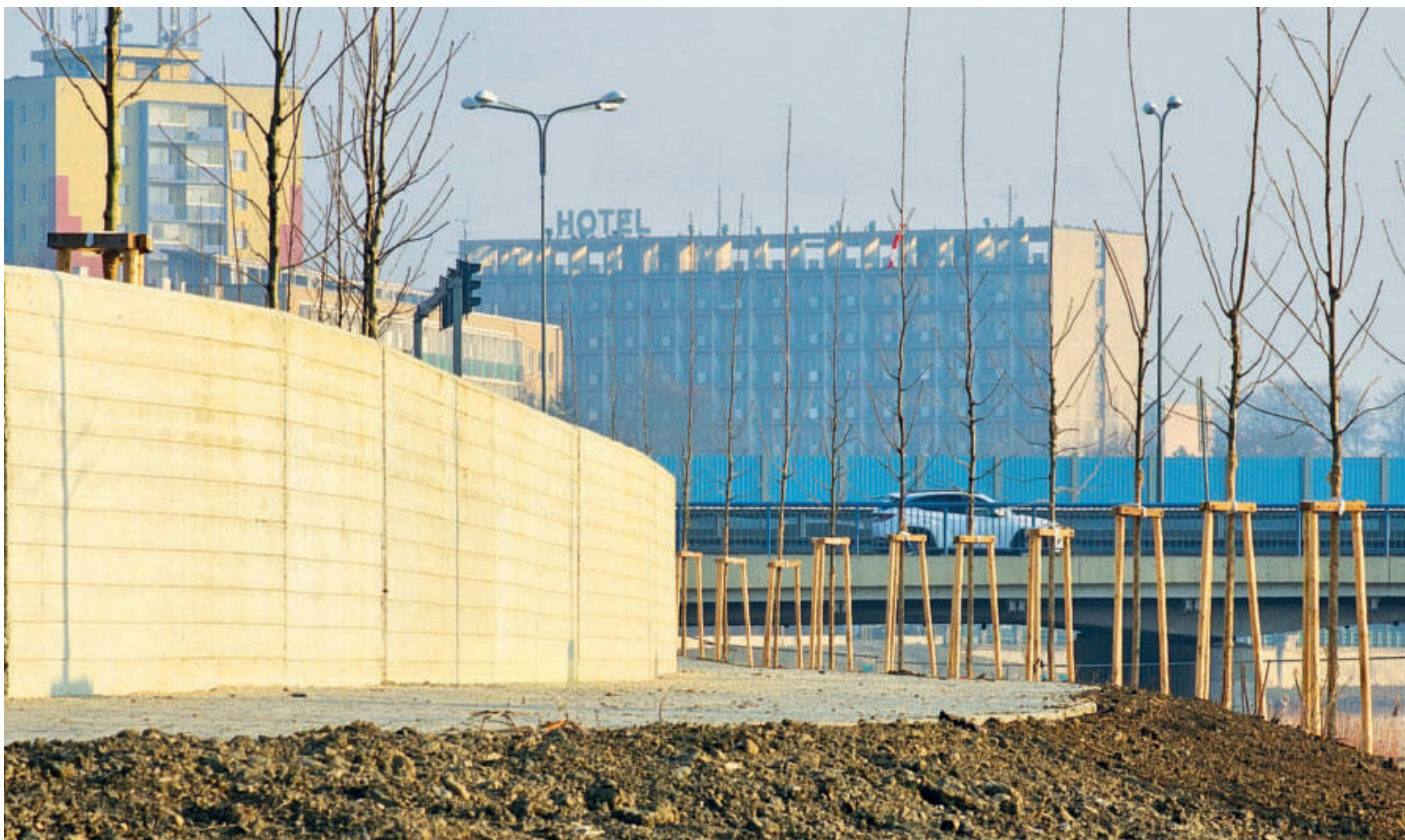
Při betonáži zídek byla do bednění vložena matrice, která má imitovat reliéf dřevěných desek
