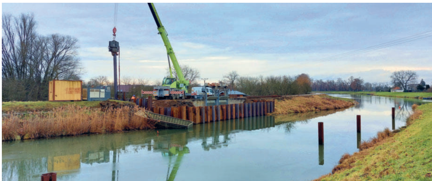
Modernizace nápuštného stavidla Veselí nad Moravou
