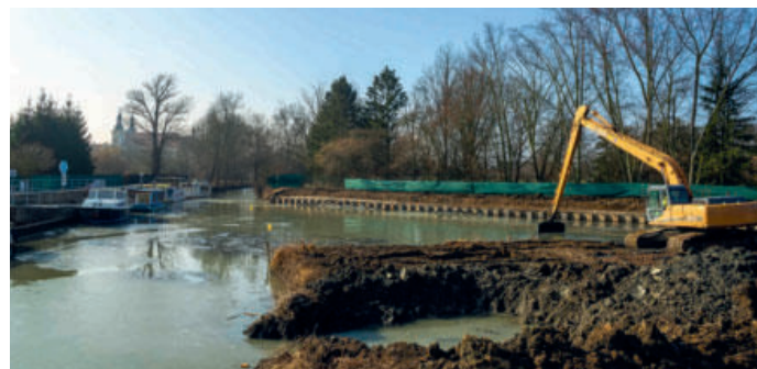
Stavební práce na rozšíření přístaviště Strážnice
