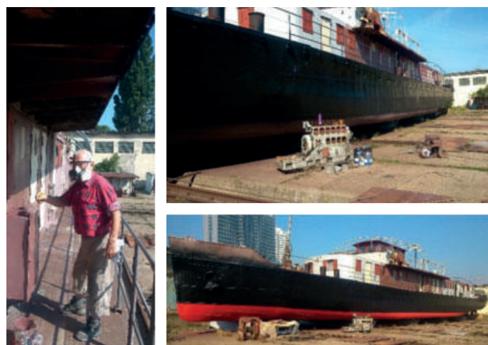
Oprava remorkéru Šturec
