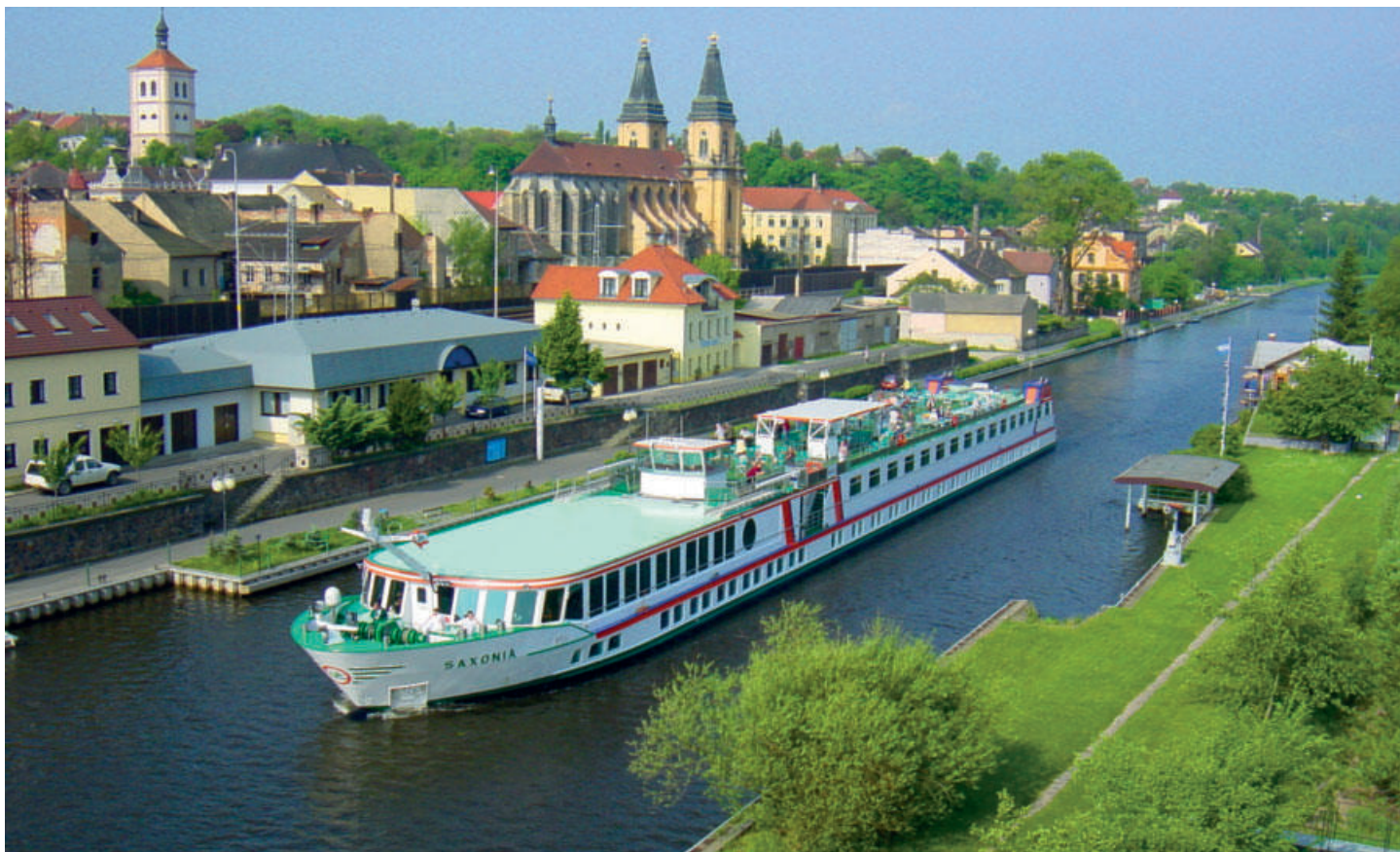
Ředitelství závodu Roudnice nad Labem na břehu plavebního kanálu
