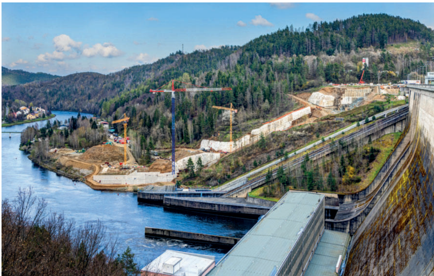
Celkový pohled na vzdušnou stranu hráze
