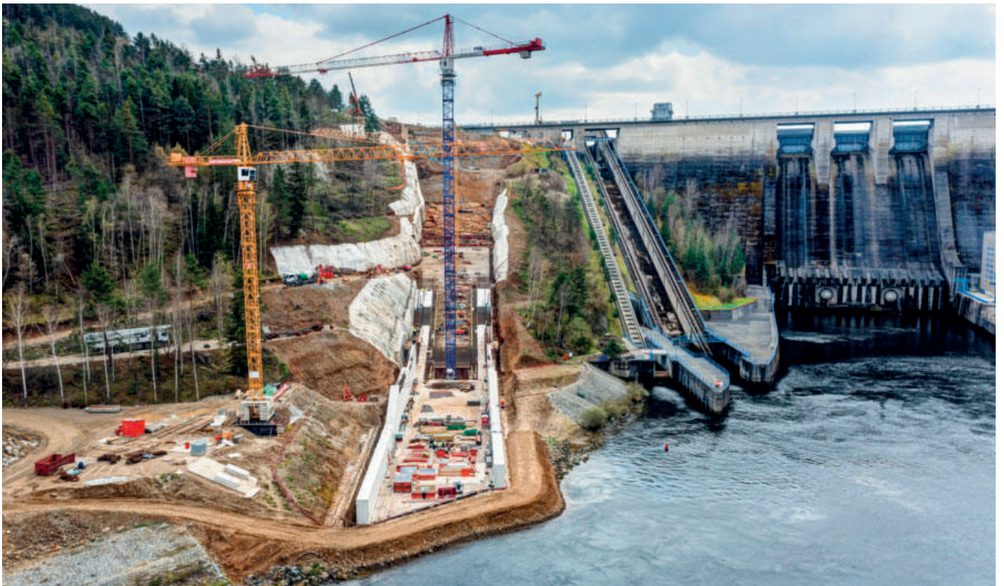
Pohled na celý stavební objekt 03 před zahájením prací na mostě
