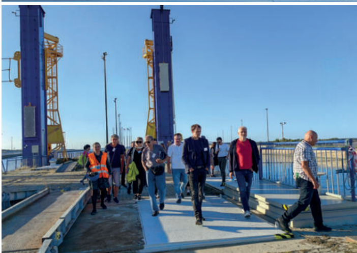
Účastníci konferencie na hornom zhlaví ľavej plavebnej komory
