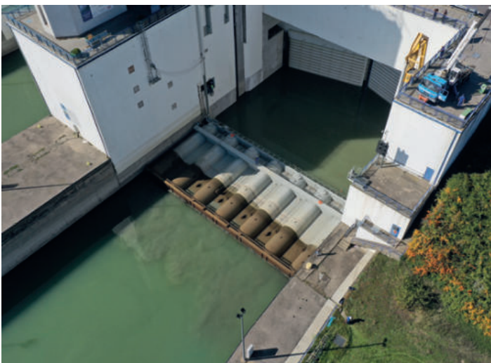
Rušení suchého doku - velkého provizorního hrazení šířky 34 m před zahájením mokřých zkoušek
