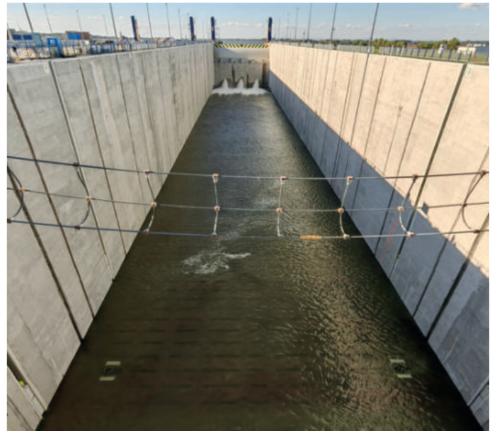
Ľavá PK – 1. netradičné skúšobné napúšťanie pred kolaudáciou
