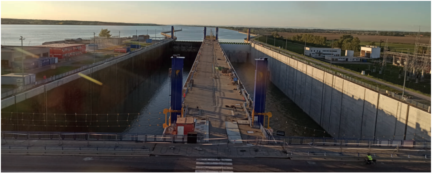
Pohľad na plavebné komory Stupňa Gabčíkovo z velína plavby
