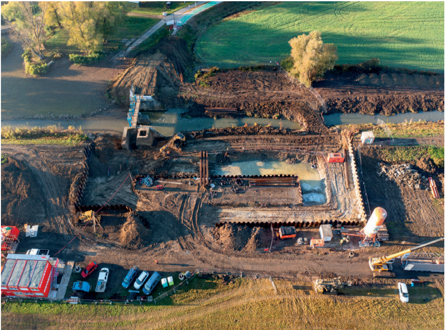
Detailní pohled na staveniště PK Rohatec
