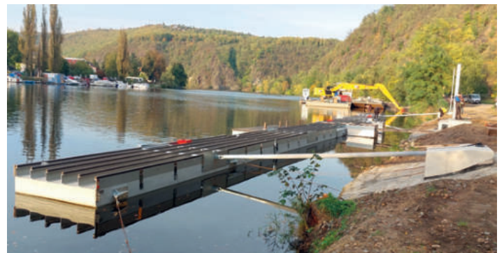
Usazení nových mol veřejného přístaviště Davle
