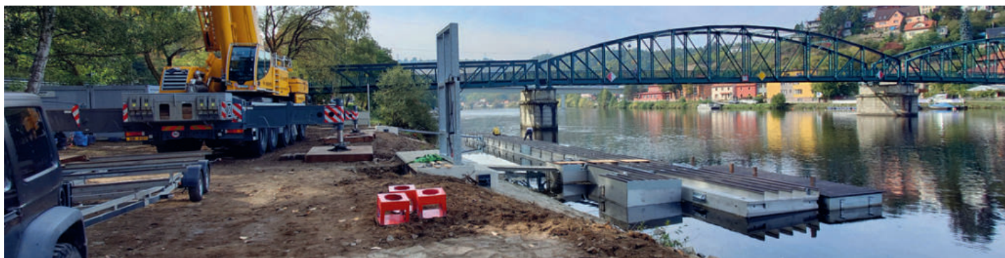
Usazení nových mol veřejného přístaviště Davle
