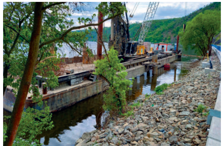
Výstavba čekacího stání v horní vodě plavební komory Vrané nad Vltavou
