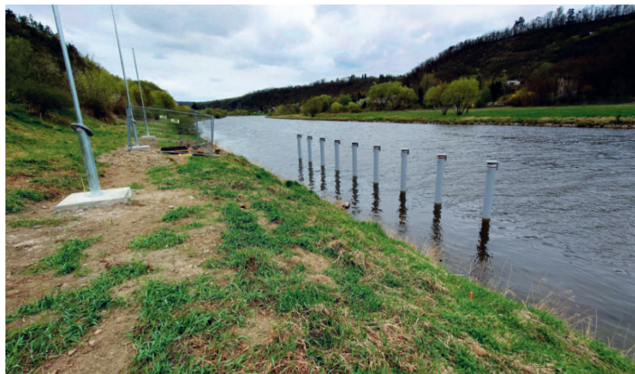
Stavba čekacích stání pro malá plavidla v horní a dolní rejdě plavební komory Roztoky na Vltavě
