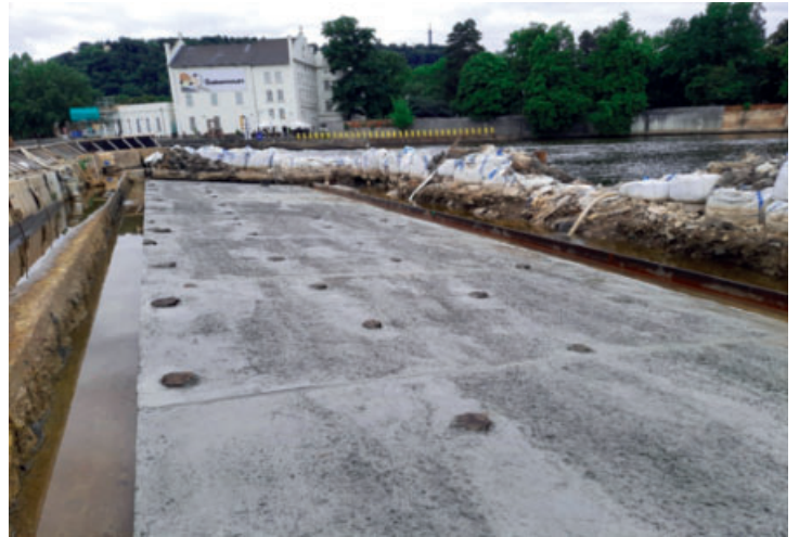
Železobetonová plocha s pilotami pro kotvení dřevěného roštu
