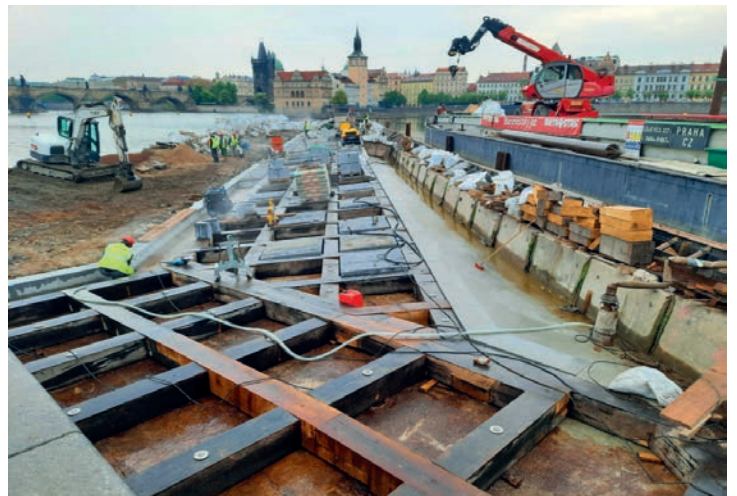
Osazování žulových desek do oken roštu
