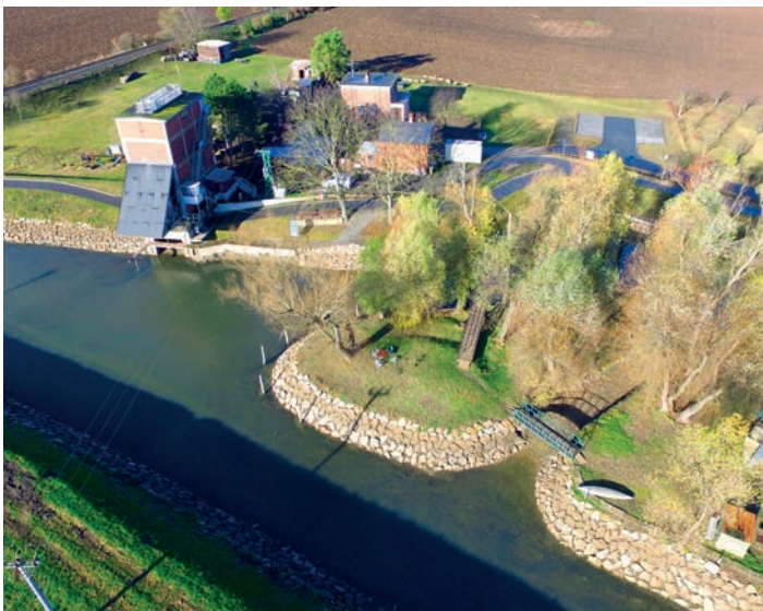
Oprava opevnění výklopnik – Valcha
