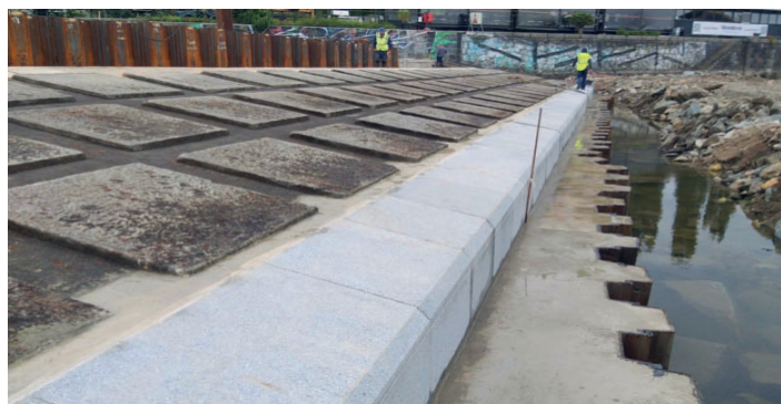
Pohled na osazenou plochu žulovými kopáky
