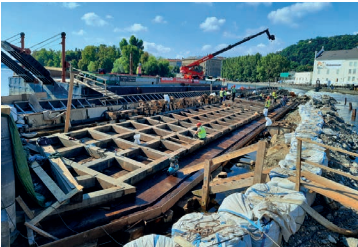
Realizace dřevěného roštu
