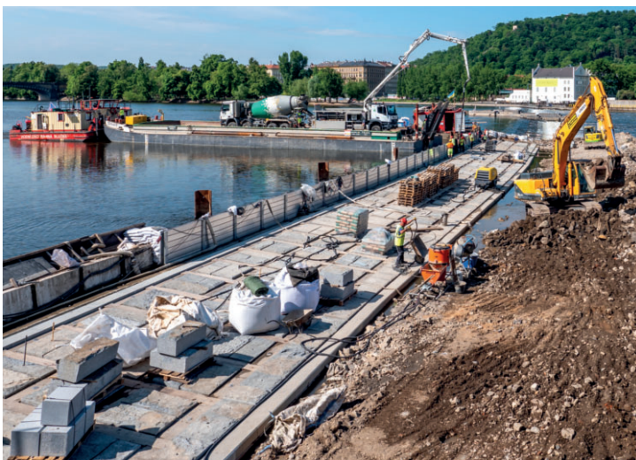
Betonáž z mixů umístěných na pontonu
