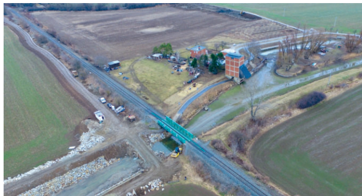
Oprava opevnění výklopnik – Valcha
