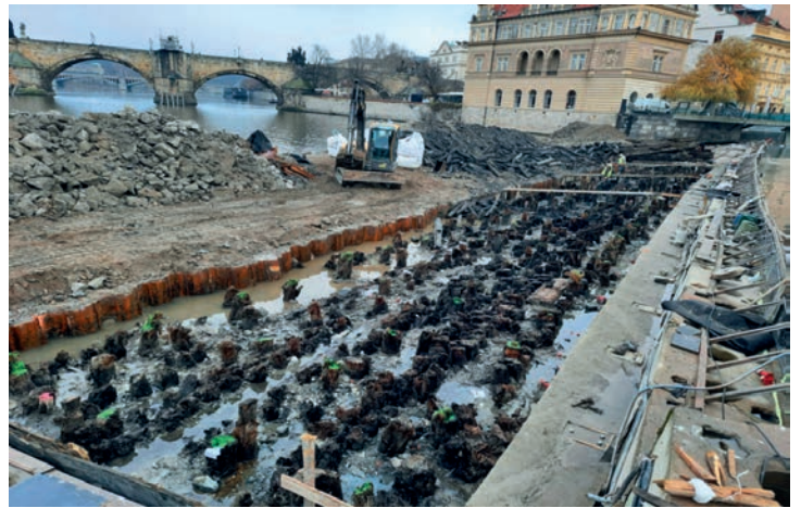
Dřevěné piloty po vybourání přelivné plochy
