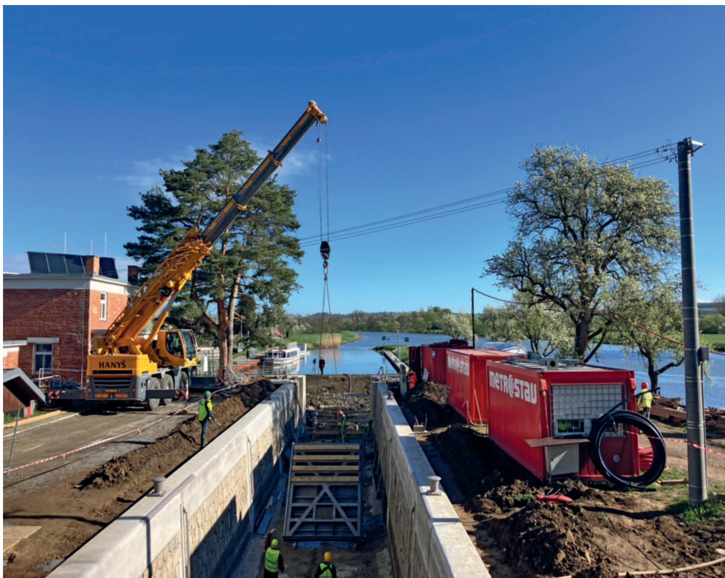
Osazování vrat na plavební komoře Spytihněv
