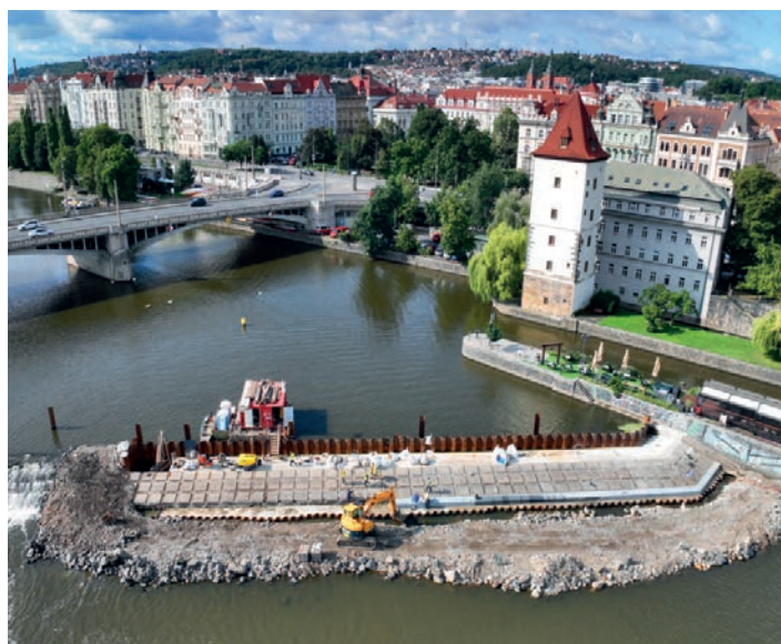
Celkový pohled na rekonstruovaný Šitkovský jez
