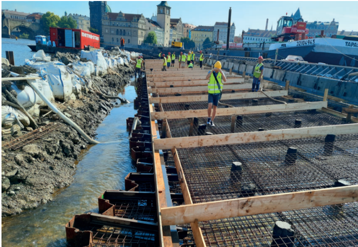
Příprava na betonáž přelivné plochy
