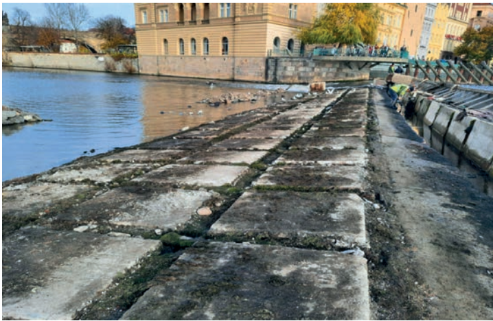
Původní konstrukce přelivné plochy
