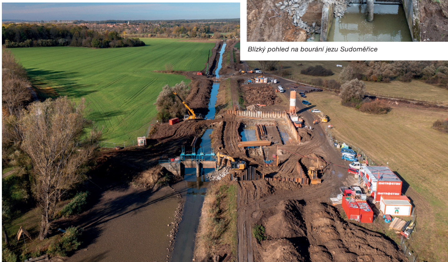
Celkový pohled na stavenišťe PK Rohatec po proudu
