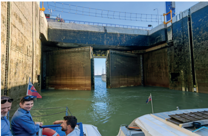
Pravá PK - zatváranie dolných vrát
