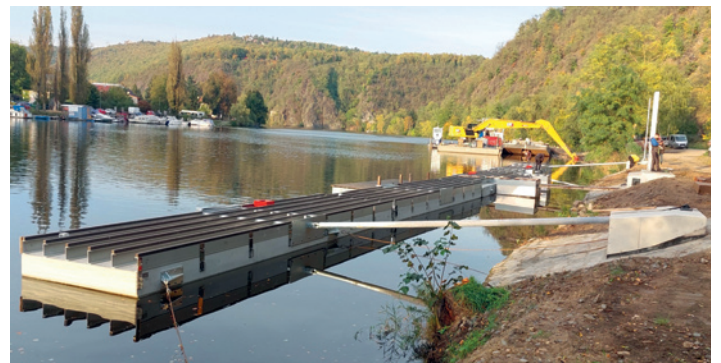
Usazení nových mol veřejného přístaviště Davle
