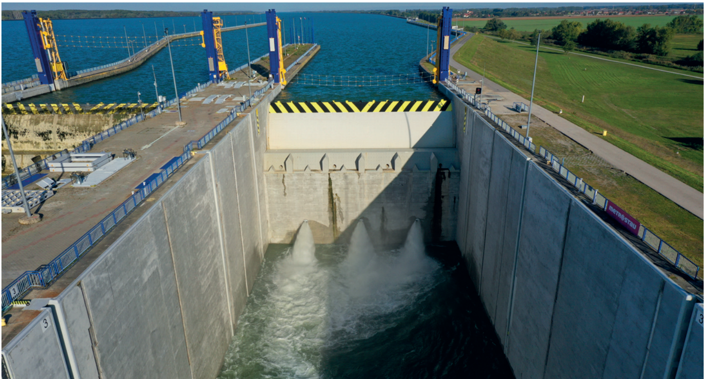
Zatápění komory pomocí šoupátek DN600
