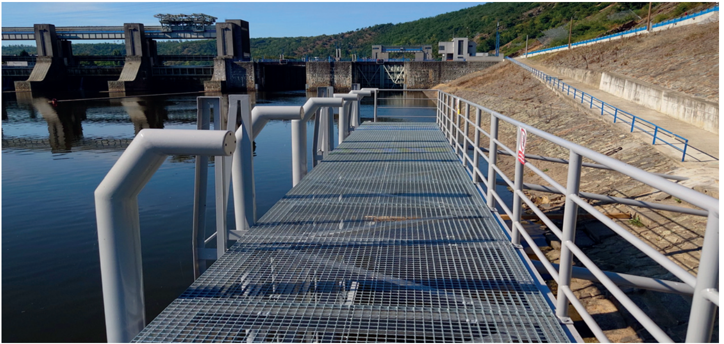
Nové čekací stání v dolní vodě plavební komory Vrané nad Vltavou
