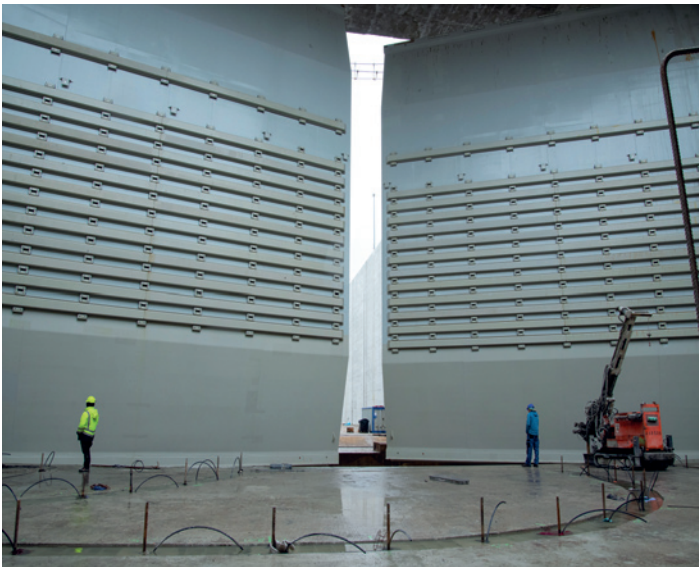
Realizace ocelových kotev hloubky až 9 m k sepnutí poškozených železobetonových konstrukcí
