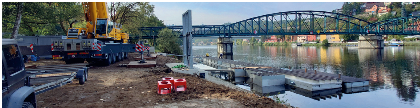
Usazení nových mol veřejného přístaviště Dvle
