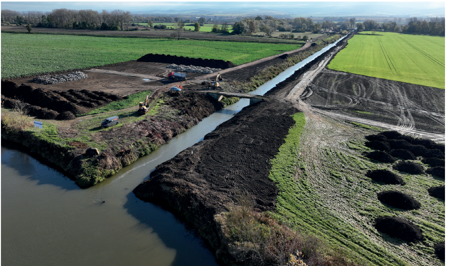
Pohled na stavební práce v ústí Radějovky do Moravy
