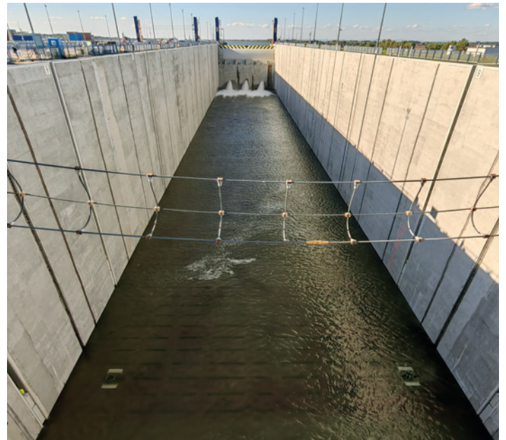
Ľavá PK – 1. netradičné skúšobné napúšťanie pred kolaudáciou
