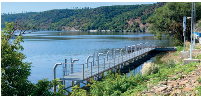
Nové čekací stání v horní vodě plavební komory Vrané nad Vltavou
