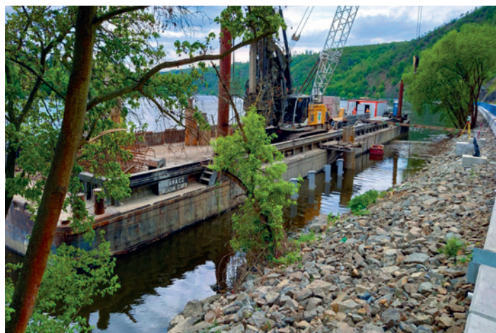
Výstavba čekacího stání v horní vodě plavební komory Vrané nad Vltavou
