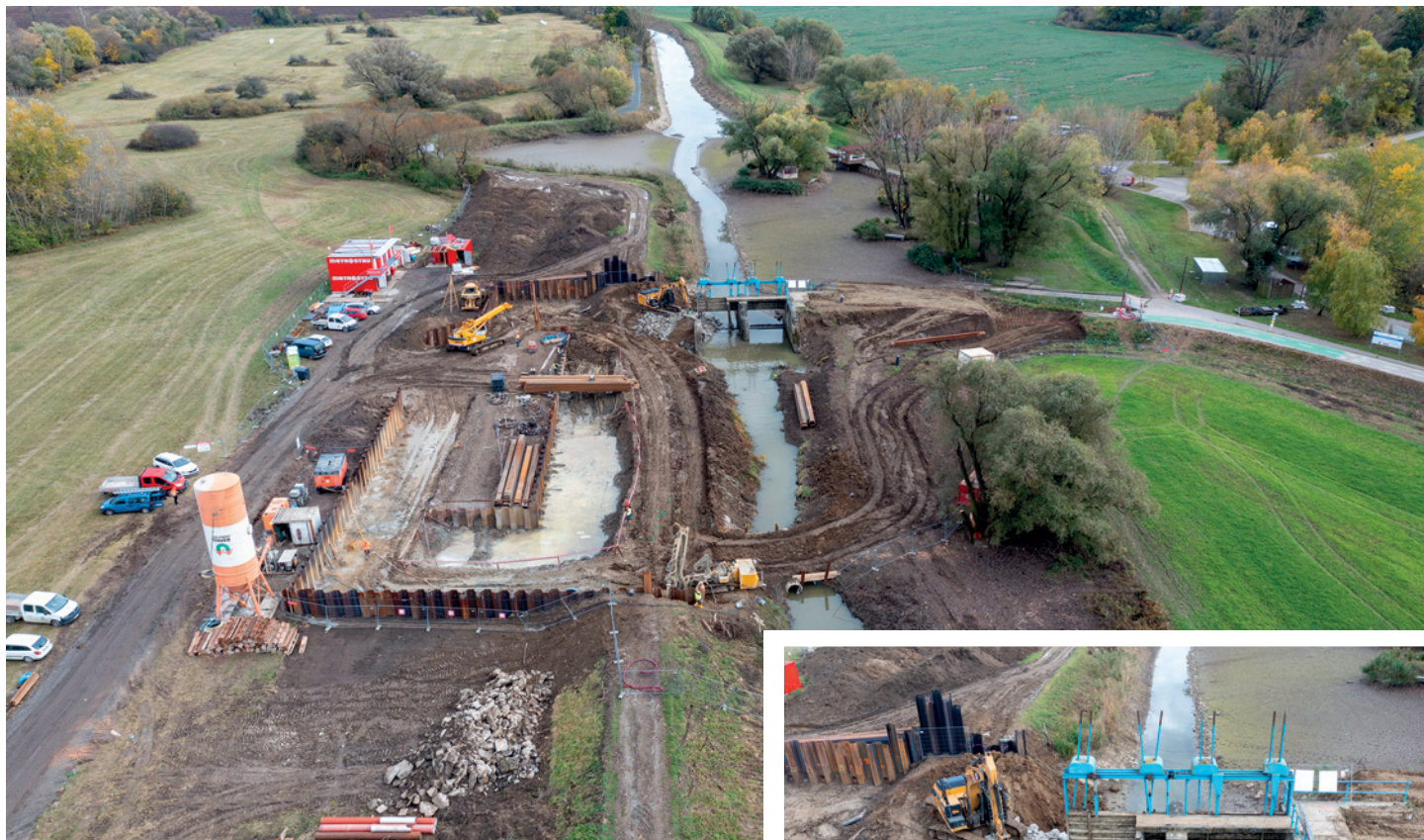
Celkový pohled na stavenišťe PK Rohatec, vpravo stávající přístav Skalica
