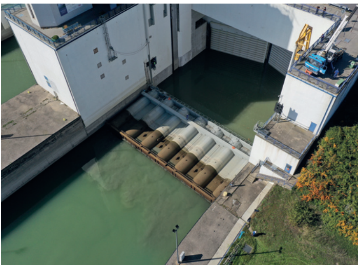
Rušení suchého doku - velkého provizorního hrzení šířky 34 m před zahájením mokřých zkoušek
