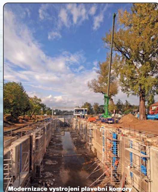
Modernizace vstrojení plavební komory
