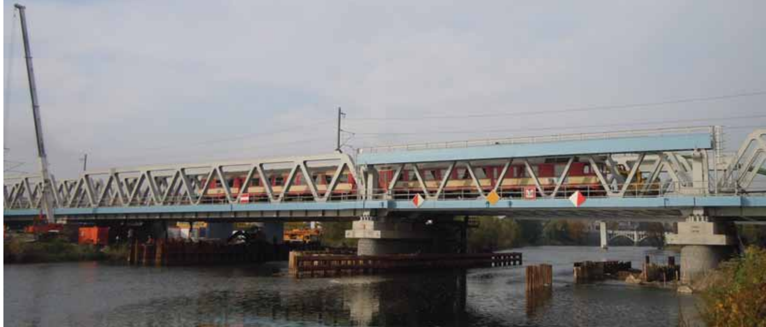
▲ Obr. 4. Nový most před dokončením
