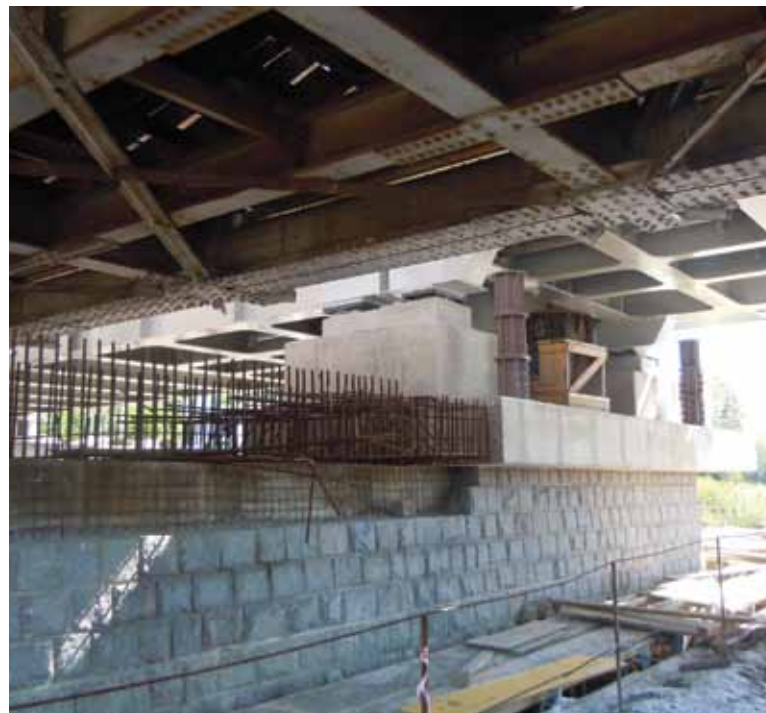
▲ Obr. 10. Postupná výstavba pilíře P3
