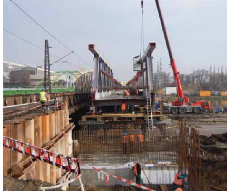
▲ Obr. 14. Výstavba opěry O1 a montáž nosné konstrukce nového pravého mostu
