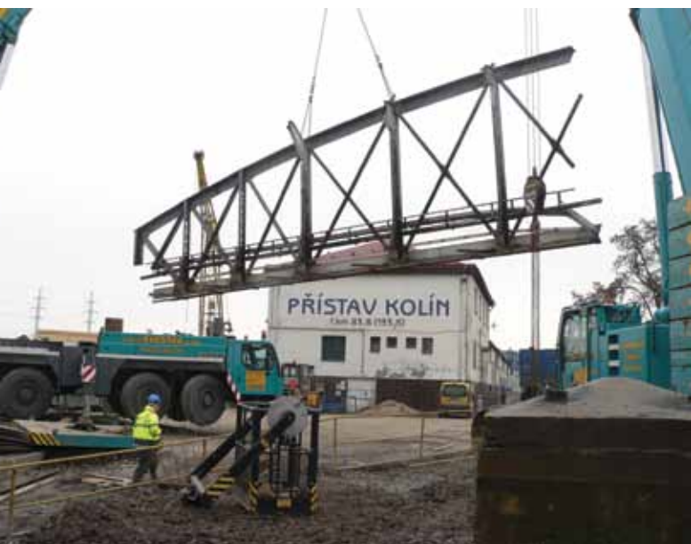
▲ Obr. 3. Demolice stávajícího mostu
