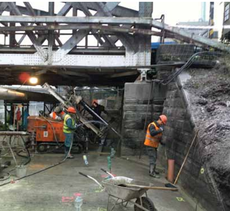
▲ Obr. 9. Injektážní práce u opěry O2
