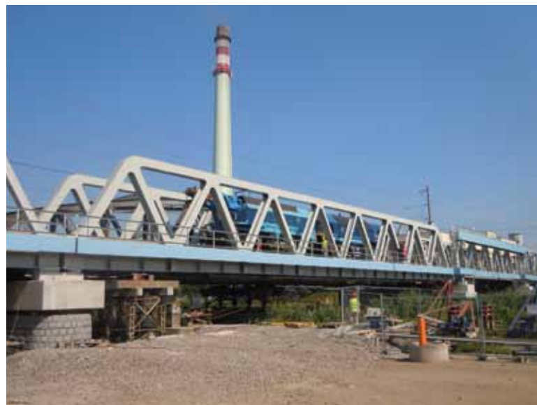
▼ Obr. 16. Zatěžovací zkouška pravého mostu
