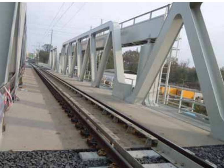
▼ Obr. 15. Přejech kolejevého lože na pevnou jízdní dráhu
