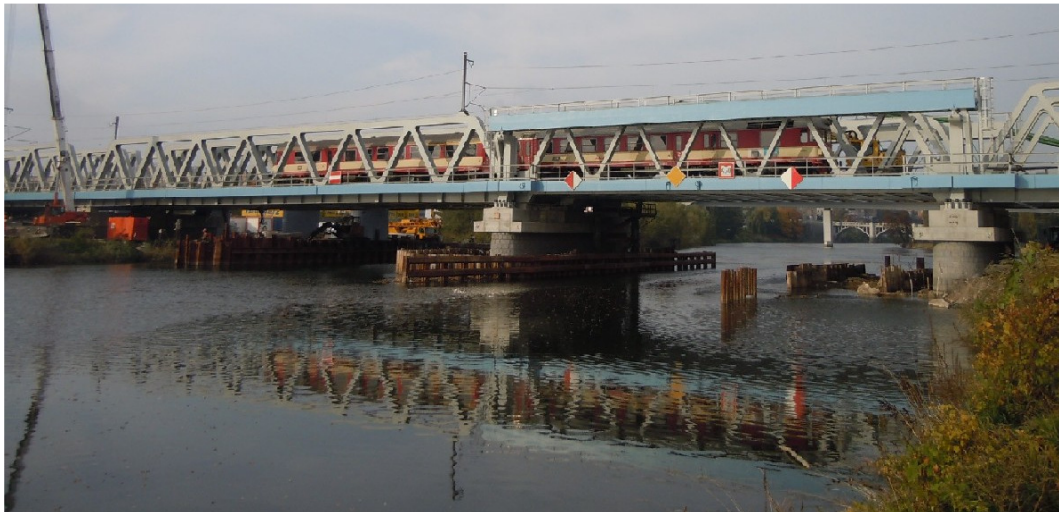
Obr.9) Pohled na nové přemostění před dokončením
