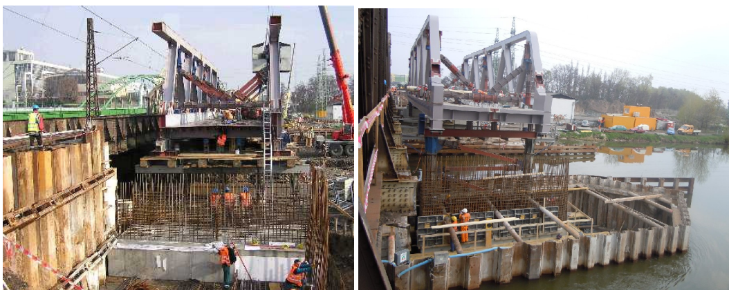
Obr.7) Výstavba opěry O1 a montáž NK pravého mostu, štětová jámka
