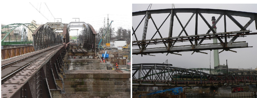
Obr.6) Demolice stávajícího mostu za nepřerušného provozu
