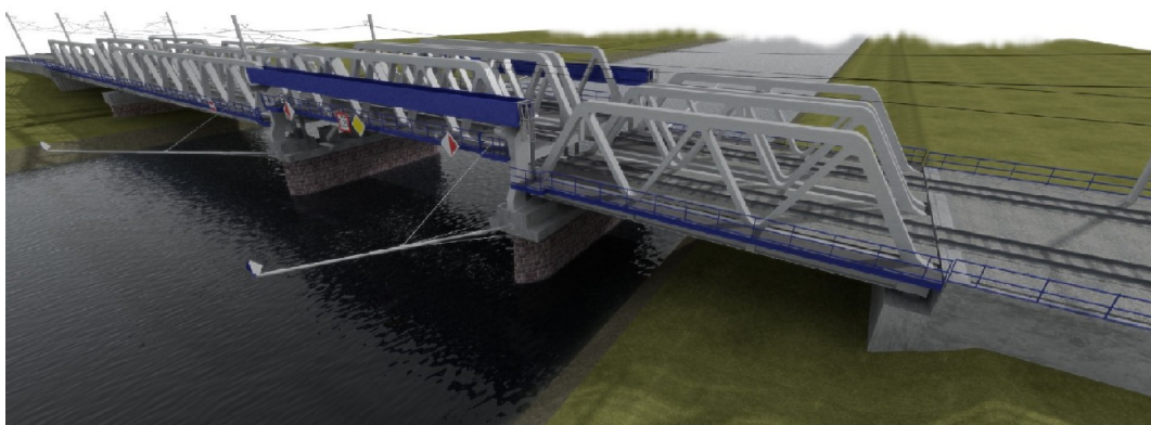
Obr.4) Vizualizace nového mostu z návodní strany – ve výhledové zdvižené poloze
