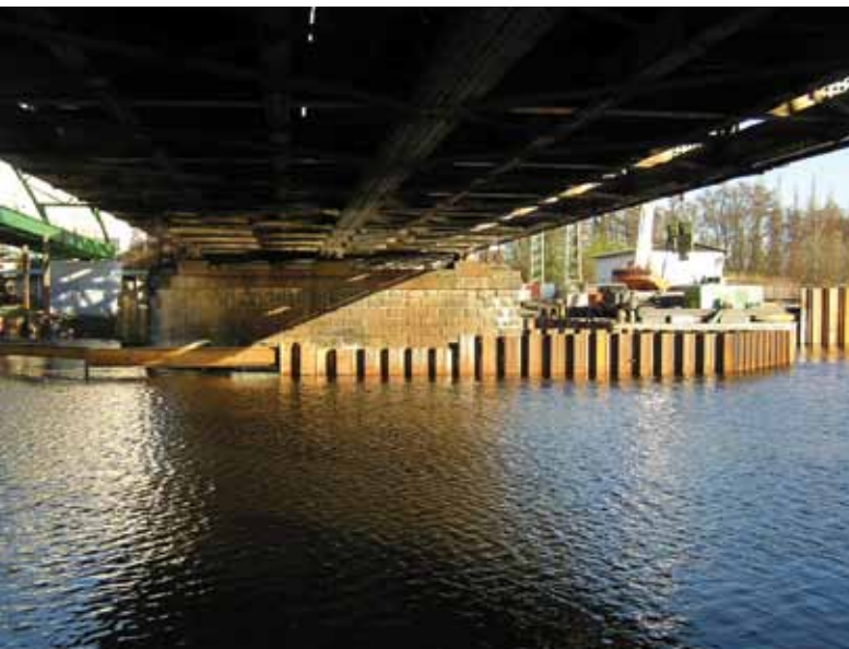
▼ Obr. 11. Výstavba štětové jímky u pilíře P2
