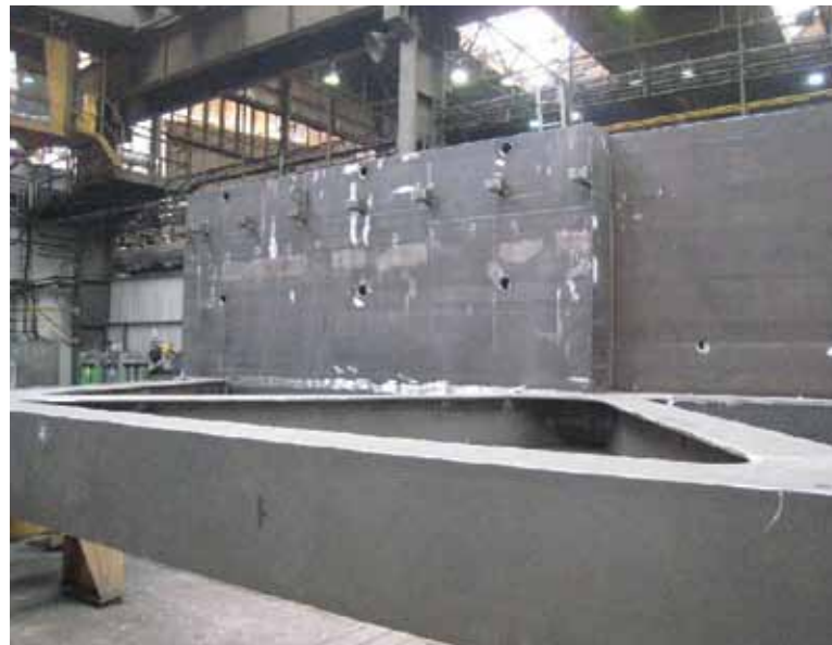
▼ Obr. 12. Výroba ocelové konstrukce, zobrazen přechod mezi štěrkovým ložem a přímým upevněním koleje
