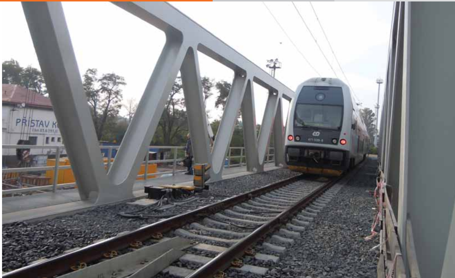
▲ Obr. 1. Nový most v provozu
