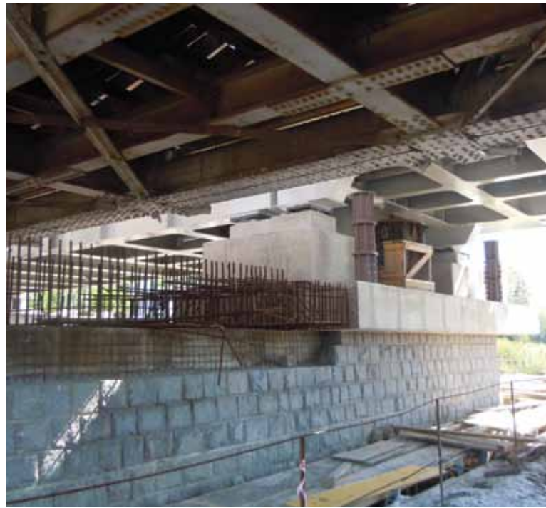
▲ Obr. 10. Postupná výstavba pilíře P3
