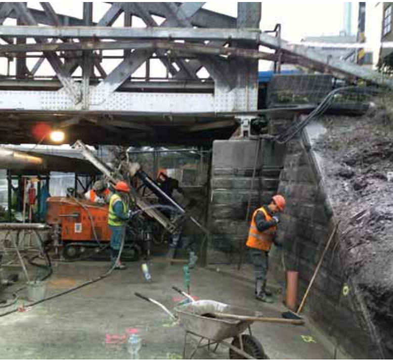
▲ Obr. 9. Injektážní práce u opěry O2
