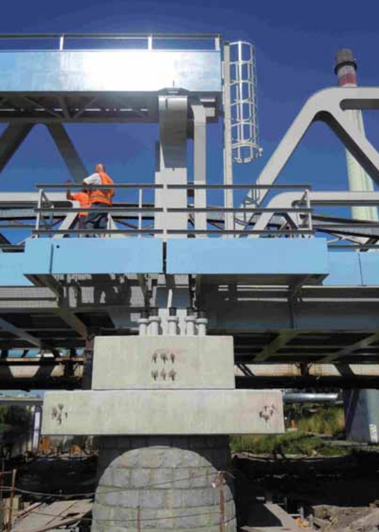
▲ Obr. 13. Pylon pro zdvih mostního pole
